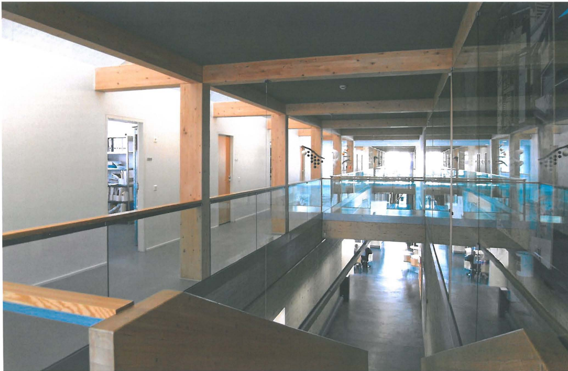
175. Rakennuksen keskikäytävässä näkyvät rakennuksen kantavat puurakenteet.
