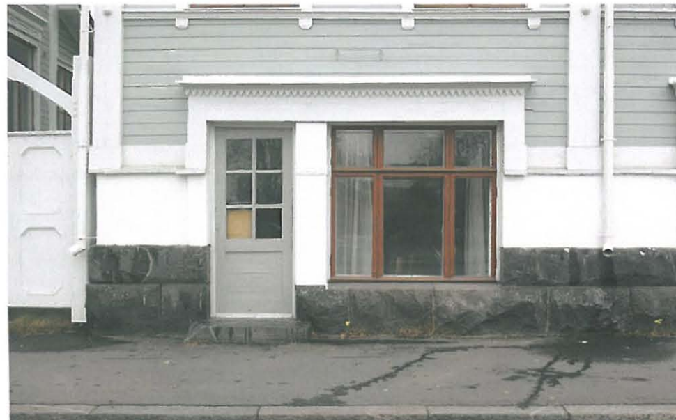
128. Sisäänkäynti rantakadun liiketilaan. Liiketilat valmistuivat 1910-luvun alkupuolella.
