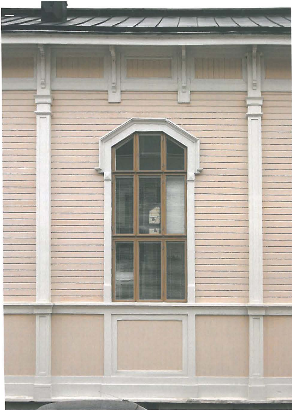
73. Pilasterien rajaama ikkunavuohyke Pakkahuoneenkadulle lokakuussa 2012.
