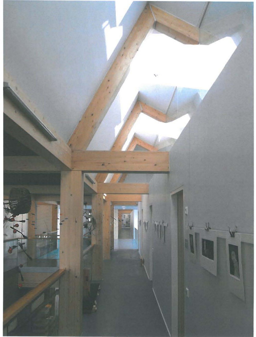
174. Toisessa kerroksessa keskikäytävälle valoa tulee kattoikkunoiden kautta.
