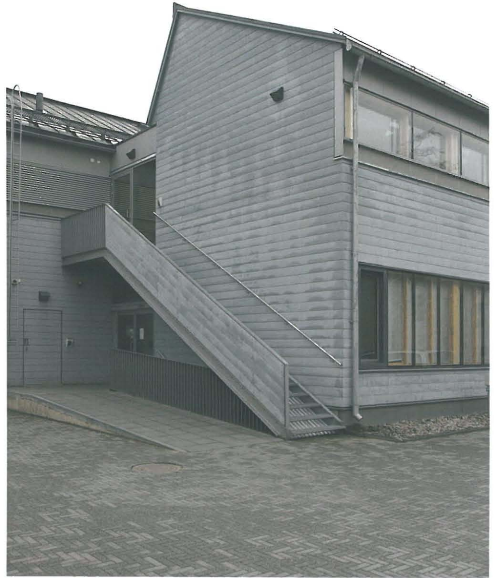
167. "Apajan" pääty ja ulkoporras piirustussalirakennukseen päin.
