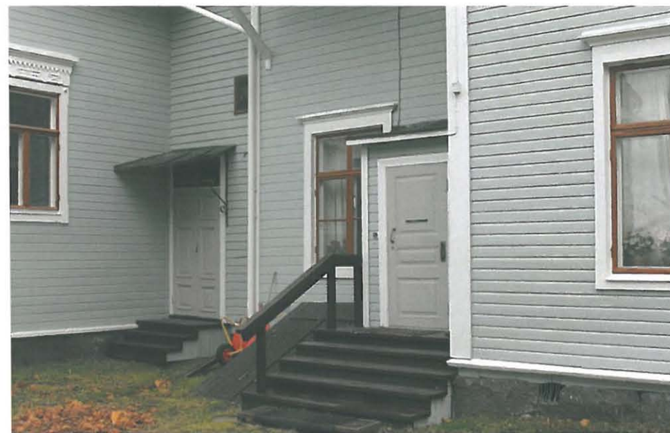
112. Sisäpihan puoleisia sisäänkäyntejä.
