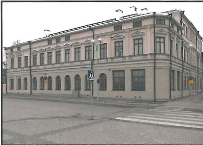
Arkkitehtuurin osaston päärakennus - Rantakatu 3 Alunperin asuin- ja liikeyrakennus, rakennuslupa 10.7.1883. Insinööri Hugo Neuman.
