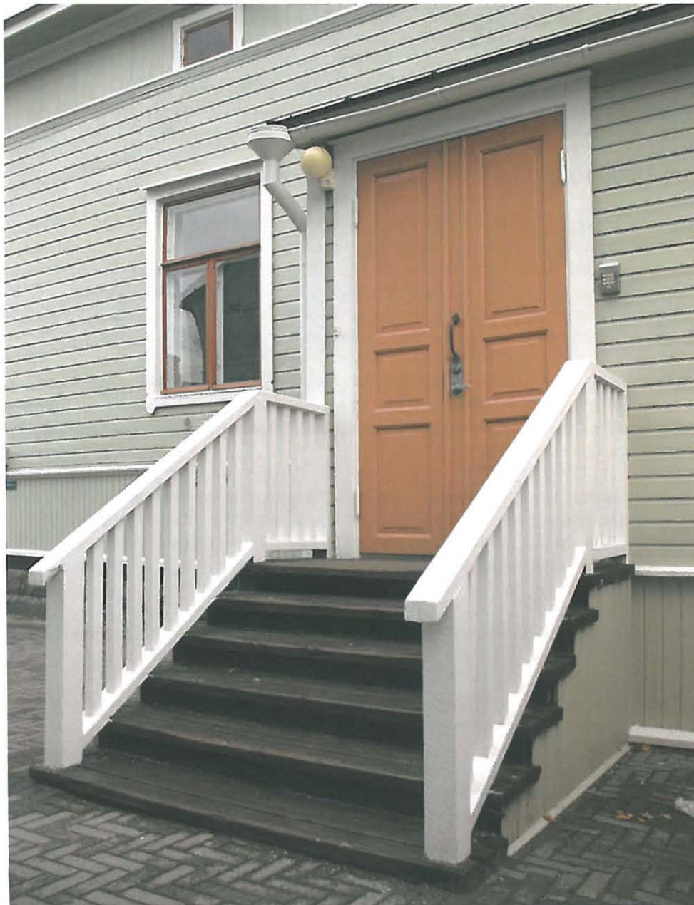
94. Pihanpuoleinen sisäänkäynti porrasaskelmiseen ei ole alkuperäinen. Se on lisätty myöhemmin 1920-luvulla toteutettuun kylmään pienehköön kuistiin mahdollisesti yliopiston toiminnan alettua.
