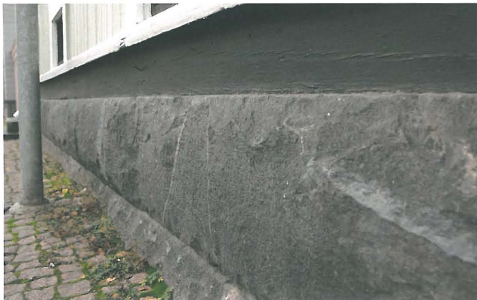
93. Luonnonkivinen sokkeli on hyvässä kunnossa.
