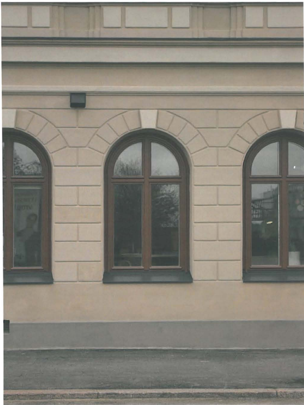
54. Katkelma Rantakadun puoleisesta katujulkisivusta.
