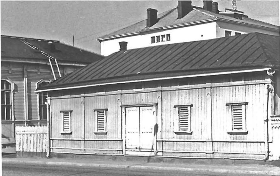
154. Uudisrakennuksen paikalta purettiin kuvan piharakennus. Piharakennus toteutettiin liikuntasalin kanssa samanaikaisesti. Se toimi halkovarastona (täydennys suoraan kadulta) ja käymälänä. Valokuva on vuodelta 1972. Puretusta suurimmaksi osaksi rankorakenteisesta piharakennuksesta on hirsinen nelinurkainen osa siirretty Pikisaareen Arkkitehtikillan tontille.
