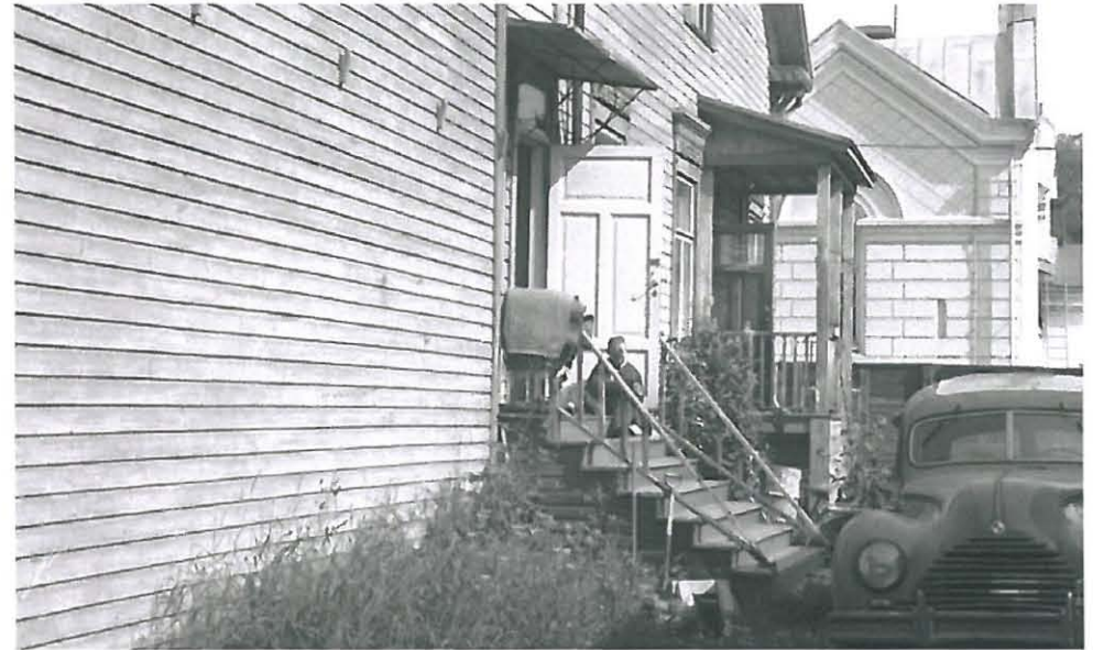
107. Valokuva vuodelta 1964. Kumpikaan sisäänkäynneistä ei ole alkuperäinen. Kuvassa taempana oleva ja mahdollisesti myös lähempi sisäänkäynti toteutettiin vuosina 1930-31, kun kulmarakennus jaettiin kahteen asuinhuoneistoon.
