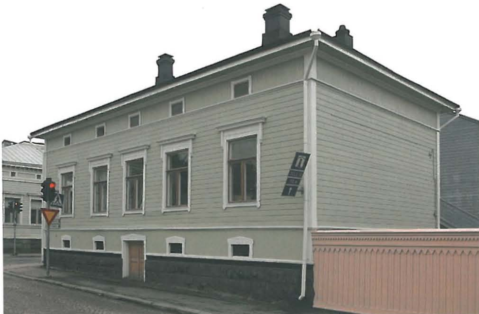
92. Hallituskadun puoleinen katujulkisivu.
