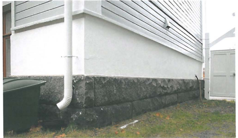
134. Valokuva lokakuulta 2012. Kuvassa näkyy betoninen sileä sokkelin korotusosa, joka korvasi rakennuksen alimmat hirsikerrat, kun katutasoon toteutettiin liiketiloja. Liiketiojen yläpohja toteutettiin kiviaineisena holvattuna rakenteena paloturvallisuussyistä.
