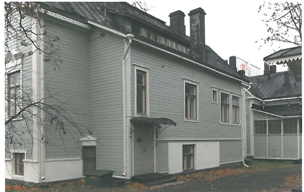
135. Sisäpihan puoleinen julkisivu lokakuulta 2012.
