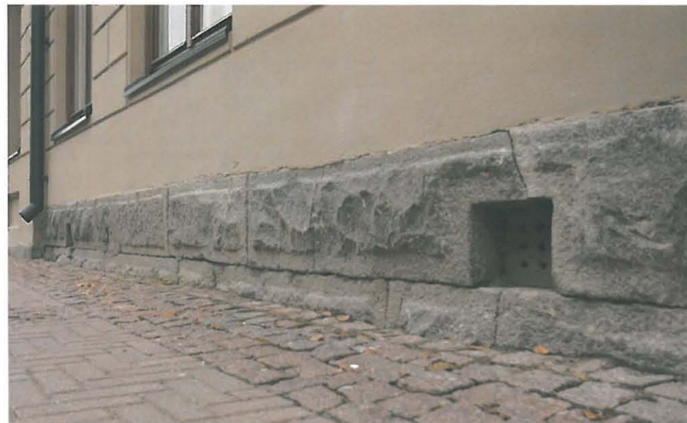
52. Osa Pakkahuoneenkadun puoleisesta sokkelista poikkeava muista rakennuksen sokkelipinnoista. Tämä sokkeli on perua vanhemmasta tontilla sijainneesta rakennuksesta. Kauppakartanon pohjaratkaisut suunniteltiin käyttökelpoisten vanhojen perustusten ja sokkelien pohjalta.
