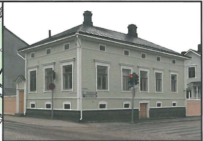
Arkkitehtuurin osaston piirustussalirakennus - Aleksanterinkatu 4 Alunperin konttorirakennus, rakennuslupa 20.12.1893. Rakennusmestari K. A. Wiklund.
