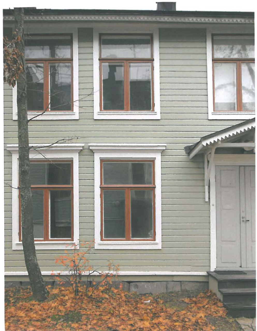
150. Rakennus lokakuussa 2012. Käyttötarkoituksen muutostöissä lisätyt ikkunat ovat hieman ylimitoitettuja ja antavat jokseenkin oudon vaikutelman rakennuksen julkisivuihin.
