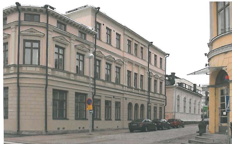
53. Rakennuksen kolmas kerros toteutettiin vuosien 1921-22 laajennus- ja korjaustöiden yhteydessä.
