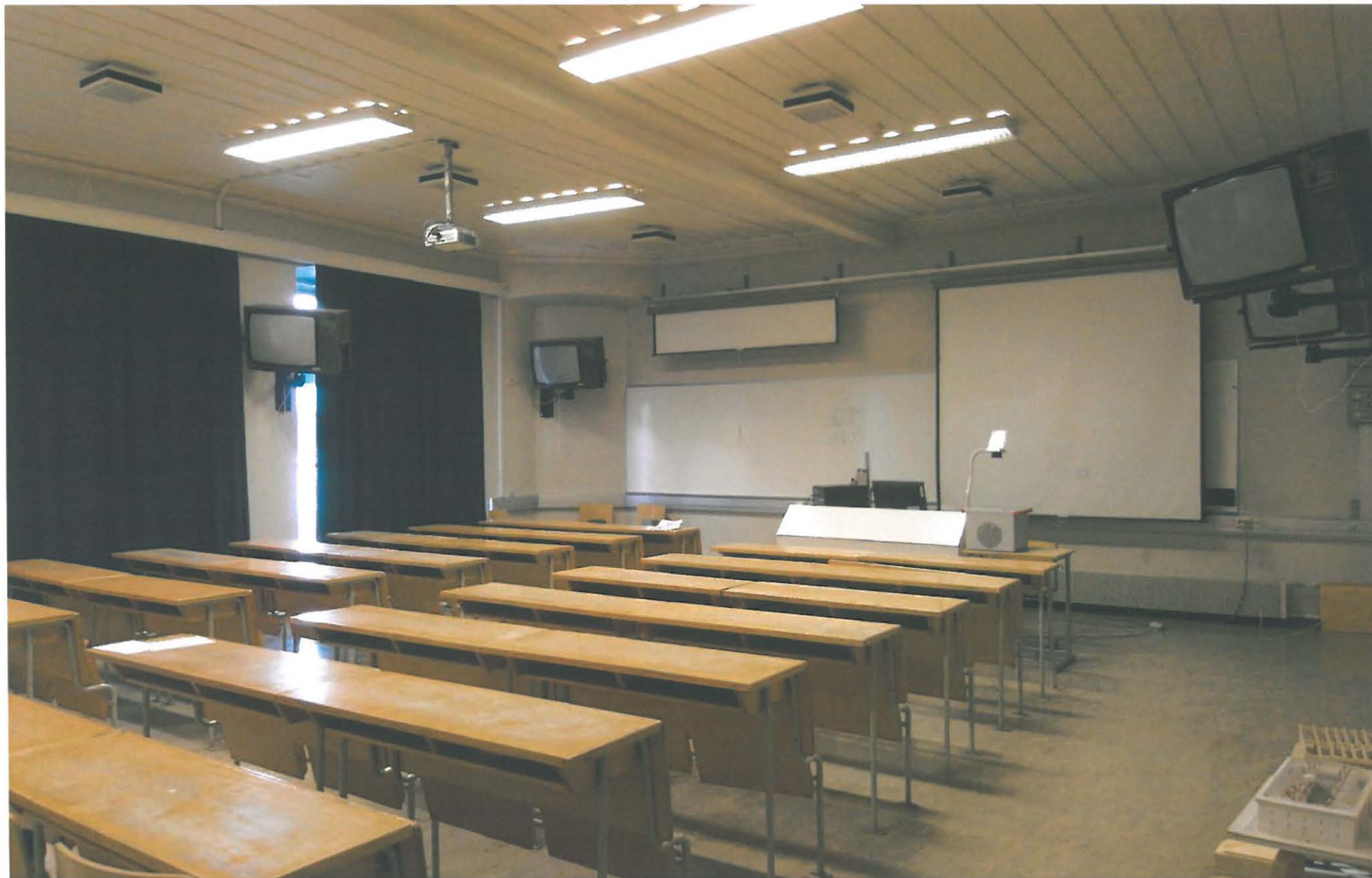
66. Ensimmäisen kerroksen kulmauksessa sijaitseva luentosali. Alunperin tässä huonetilassa oli liiketila. Myöhemmin tämä salitila toimi pitkään koulun rukoushuoneena. Rantakadun puoleiset ikkunat on laitettu umpeen, vaikkakin ikkunat ovat edelleen paikoillaan. Salitilan lattia on korotettu alkuperäistä ylemmäksi. Salitilan sisäkatto voi olla hyvinkin vanha.
