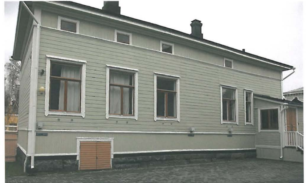
95. Sisäpihan puoleinen julkisivu. Ikkuna-aukoitus ei ole säännöllinen julkisivussa tapahtuneiden muutosten takia.
