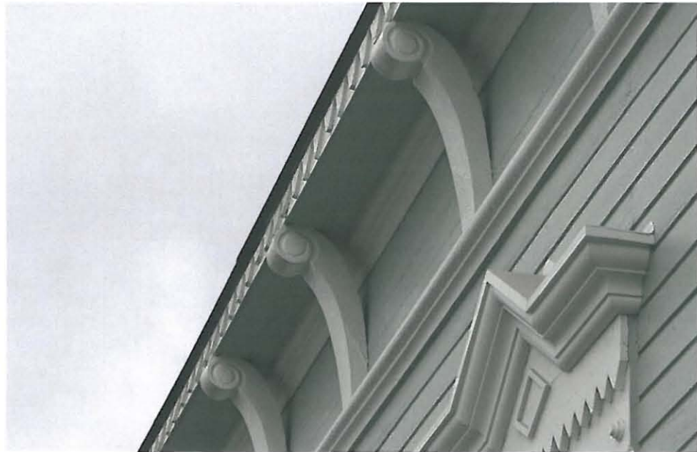
110. Rakennuksen räystäätä kannattelee voluutta-aiheiset puukonsolit.
