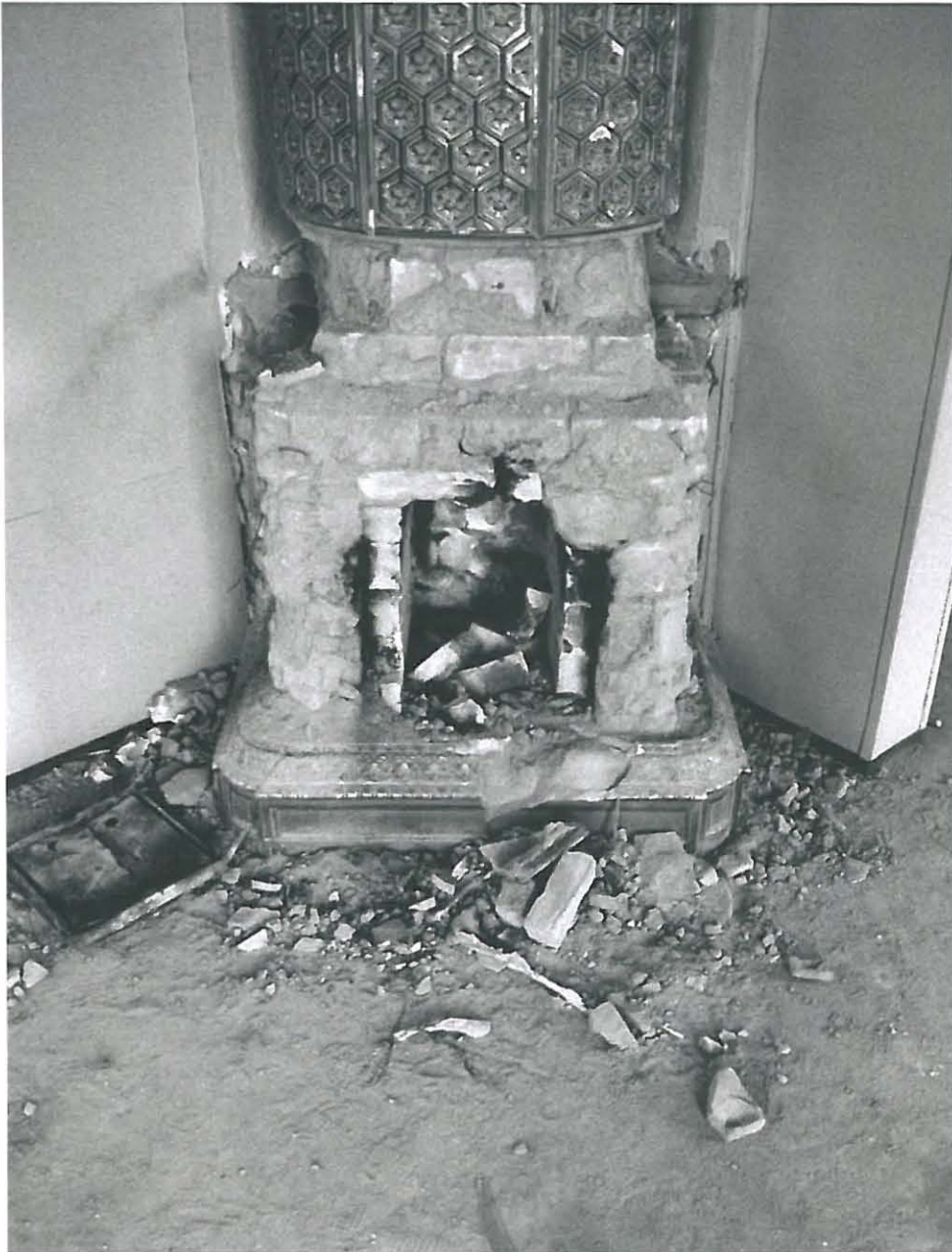
133. Kakluunin purkutyöt ovat käynnissä 10.7.1990. Peruskorjauksissa rakennus mm. liitettiin kaukolämpöön. Osa sähkövaraaviksi muutetuista kakluuneista purettiin pois.
