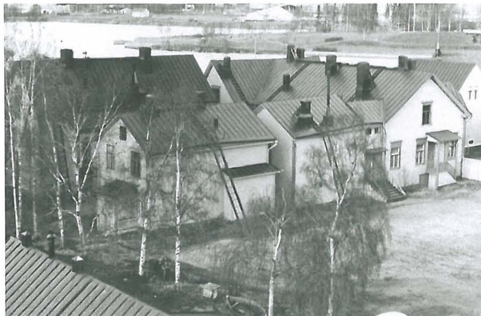
142. Valokuva 1960-puolivälin jälkeen. Kuvasta voi päätellä, että mm. puurakennusten vesikatot on ehostettu vastikään.
