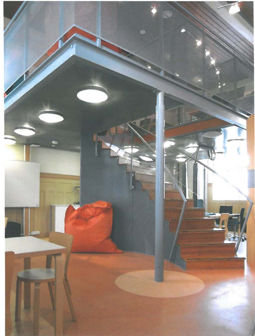
83. Viimeisimpien korjaustöiden yhteydessä toteutettu teräsrakenteinen oleskelu- ja lukuparvi.
