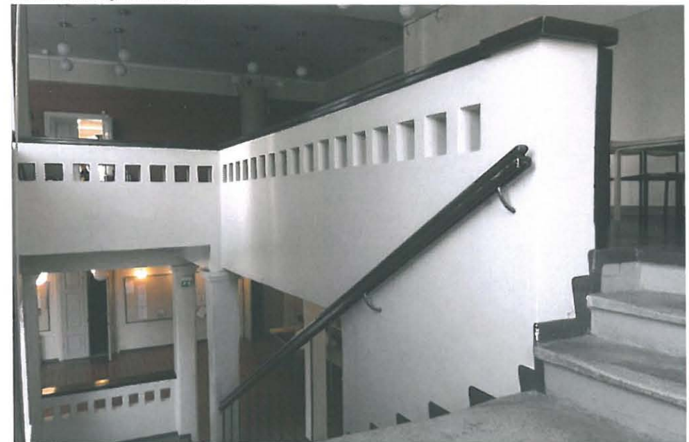
60. Porras ensimmäisen kerroksen aulasta toisen kerroksen aula- ja salitilaan. Porras on rakennettu 1920-luvun alun korjaus- ja laajennustöiden yhteydessä.
