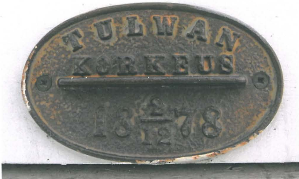
102. Torinrannassa tulva kohosi 2.12.1878 ennätyslukemiin. Rakennuksen Rantakadun puoleisessa julkisivussa on merkintä tulvakorkeudesta. Rakennuksen ensimmäisen asuinkerroksen lattia toteutettiin tämän tulvakorkeuden yläpuolelle ja siksi se on keskimääräistä ylempänä.
