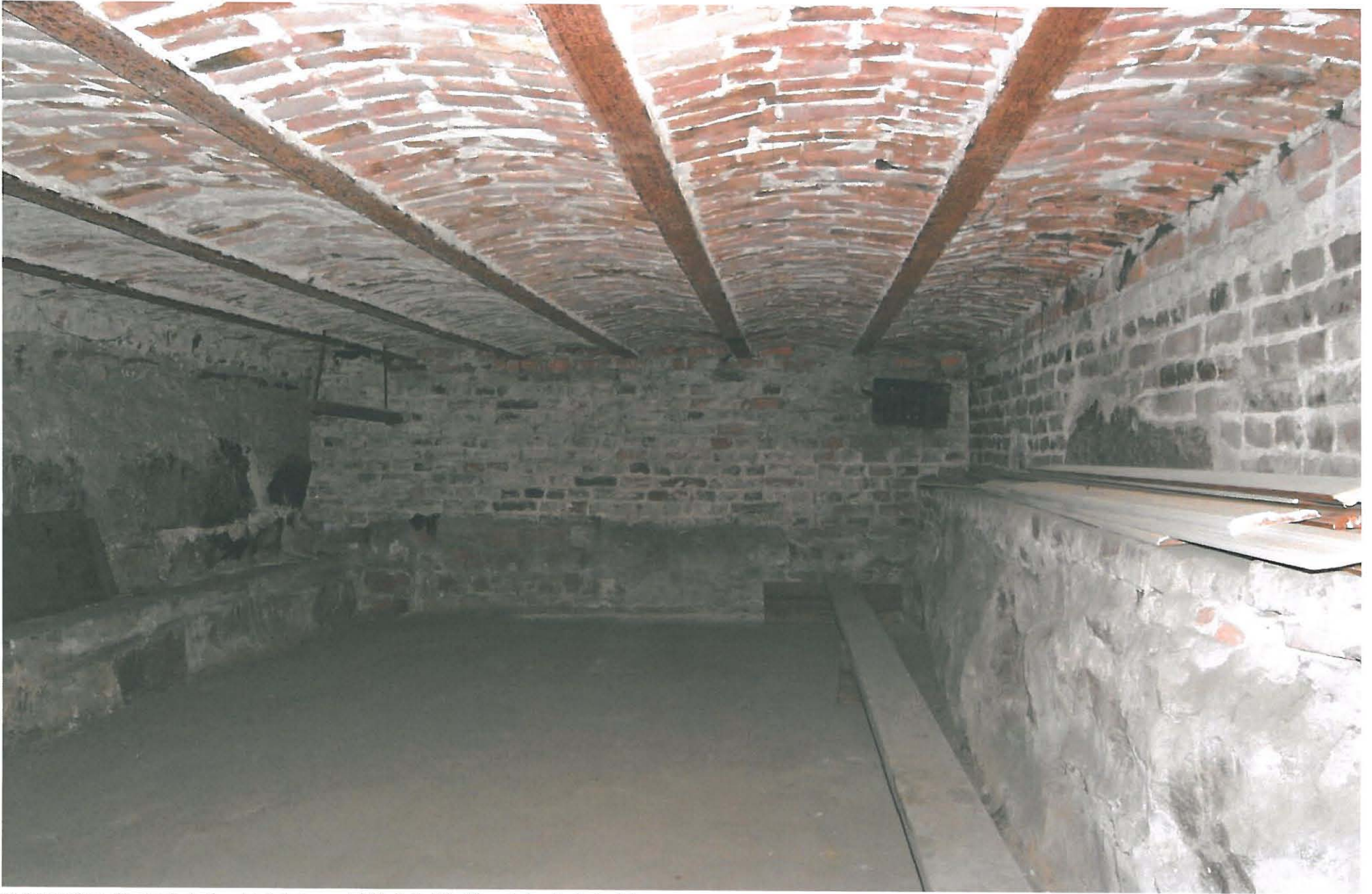
67. Rakennuksen alla on noin 4 x 6 metrin kokoinen matalahko kellaritila. Tila on kuivan ja siistin oloinen.
