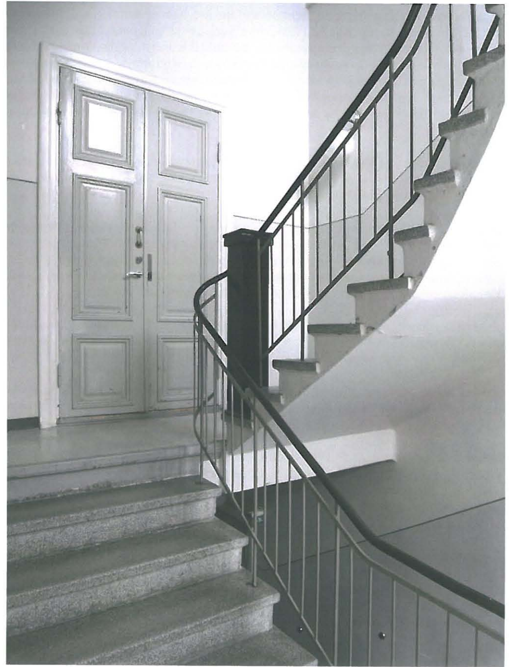
65. Toisesta kerroksesta kolmanteen kerrokseen noustessa porras muuttuu huomattavan jyrkäksi.
