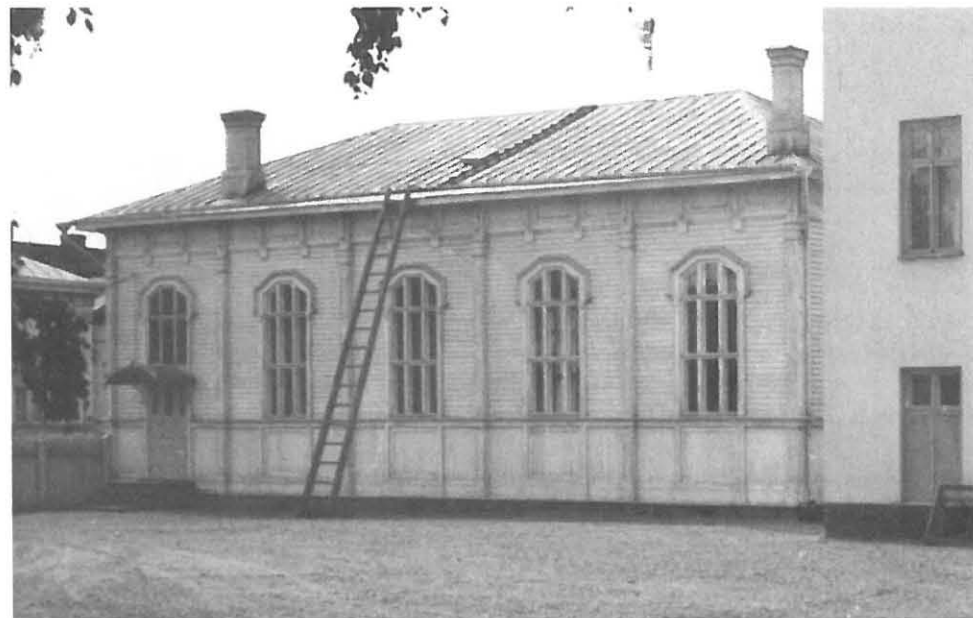
71. Liikuntasali otettiin yliopiston käyttöön suurena luentosalina, jossa järjestettiin mm. tohtorin väitöslaisuudet. Kuva on 1960-luvun alusta ennen vuotta 1965, jolloin katolle asennettiin huippuimuri ilmanvaihdon parantamiseksi.
