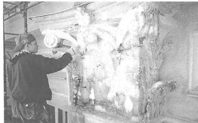
Jani Sarajärvi puhdistamassa peruskerroksen pilasterikapiteelia. Poistettavat kappaleet on jo irroitettu. Säilytettävien kappaleiden lukumäärä vaihteli kapiteelista riippuen.
