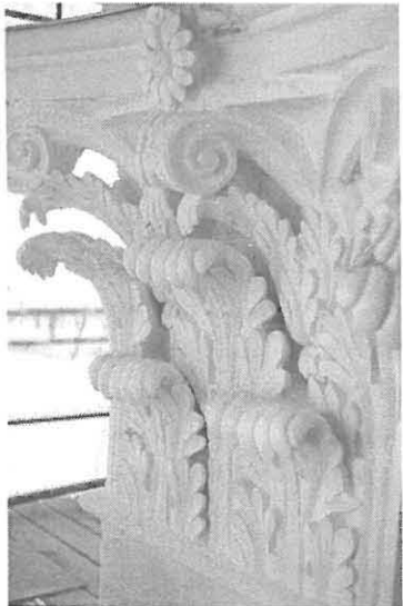
KKa-RPL - kapiteelin pohjoispuoli sijaitsee päätykatoksen alla suojassa ja oli erittäin hyväkuntoinen.
