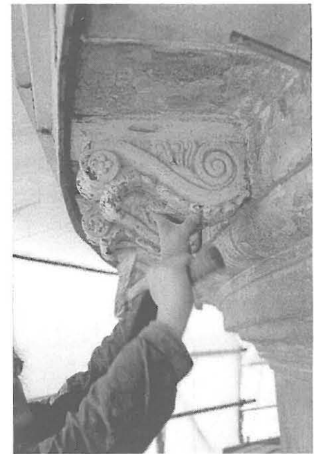
Osa keskitornin konsoleista oli jo suorastaan vaarallisia, koska vanhat kiinnitykset olivat pettäneet. Kaikki konsolit irroitettiin ja korvattiin uusilla valuilla.
