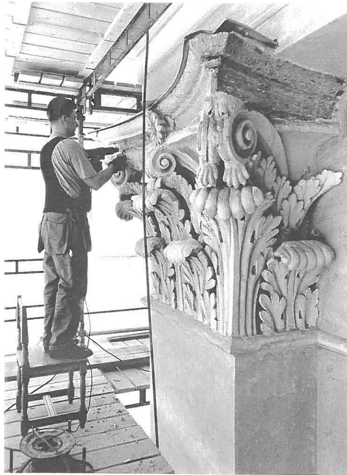
Valurautaisen abakuksen maalinpoistoa kuumailmapuhaltimen avulla. Kuva Matti Karjanoja.
