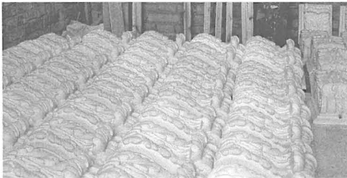
Uudet konsolit odottamassa kiinnitystä.
