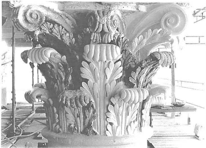
Pylväskapiteeli, jonka tummat kappaleet ovat vanhoja, puhdistettuja, vaaleat uusia, tämän vuoden valuja. Kuva Matti Karjanoja.
