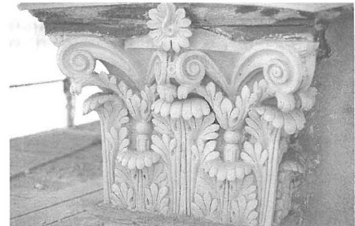
Uusia valukappaleita ennen maalausta.
