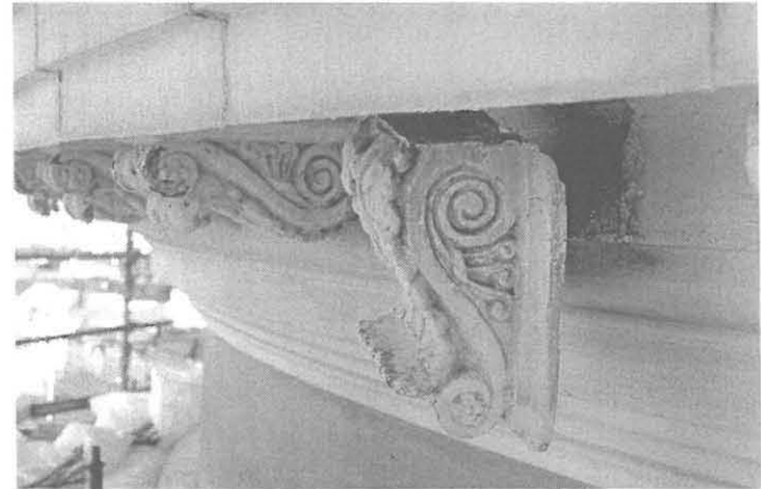
Osa keskitornin konsoleista oli jo suorastaan vaarallisia, koska vanhat kiinnitykset olivat pettäneet. Kaikki konsolit irroitettiin ja korvattiin uusilla valuilla.
