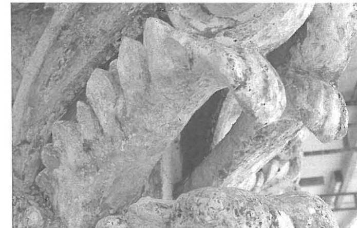
Tapulirakennukseen on tehty ilmeisesti vuosisadan alkupuolen korjauksen yhteydessä muutama hyvin vapaamuotoinen korjauskappale, kuten alla oleva maljalehdykkä.
