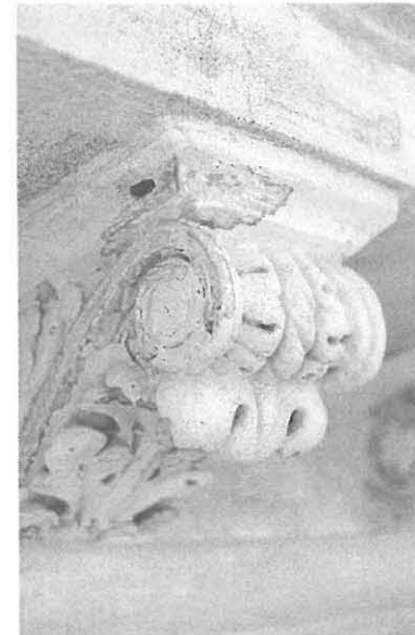
Yllä 70-luvulla tehty harmaasta puolalaiskipsistä valettu konsoli, alla vanha, todennäköisesti alkuperäinen konsoli.
