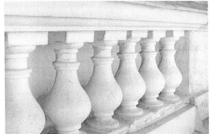
Balustereiden kunnostaminen ei vaatinut uusia valuja, vaan vanha materiaali oli edelleen korjauskelpoista.
