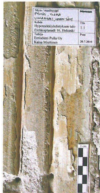
Kuva vasemmalla: vanhin vihreä öljymaalikerrostuma ja siihen liittyvä ruskea liimamaaliboordi. Kuva oikealla: alue oikeassa reunassa, vaurioituneen rappauksen vieressä on oletettavasti alkuperäinen liimamaalikäsittely.
