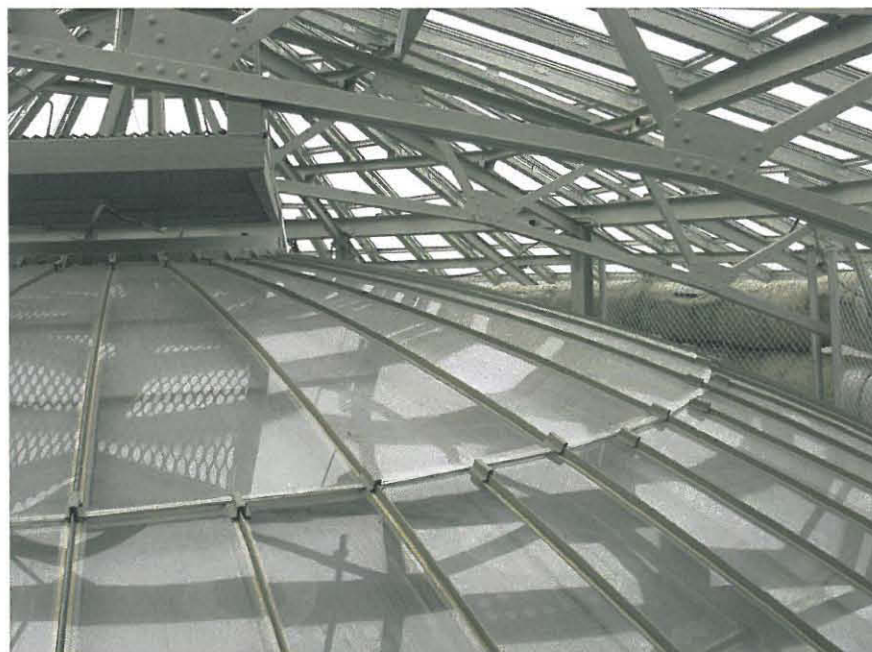
Rotundan ullakko nykytilassaan. Kupo- lilasin päälle lisätty 1998-2000 kirkaat muovilevyt.
