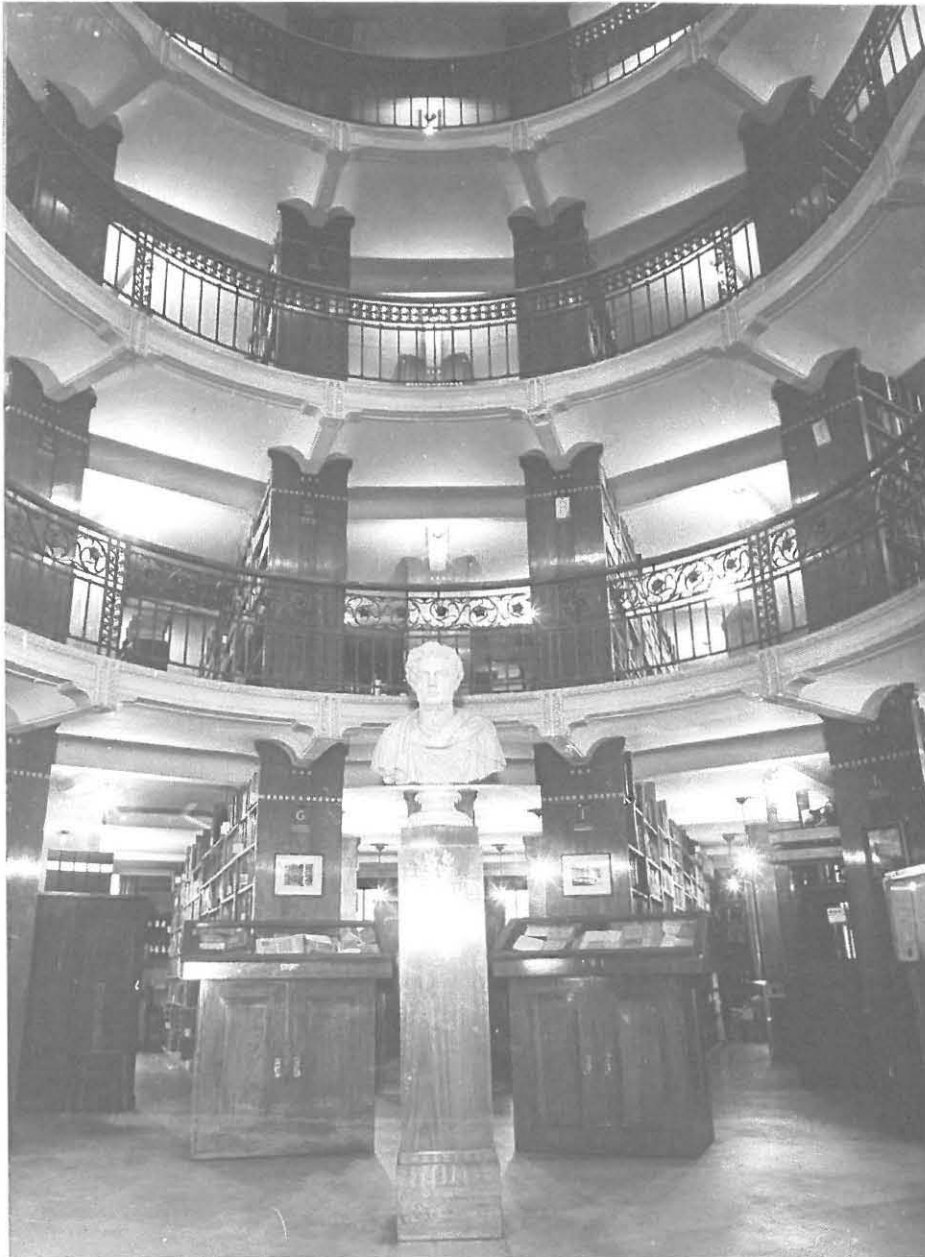
Ennen peruskorjausta: dokumentoitu kuva vuodelta 1950 tai -51. Rotundan, eli kirjavaraston, kirjajohlyjen välinen valaistus perustuu paljaisiin hehkulamppuihin. Lintunen / HYM
