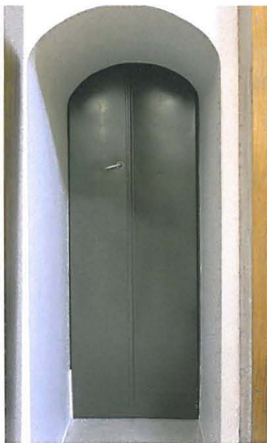
Ovi 2 eli Hanssonin suunnittelema palo-ovi PO22 kupolisalilin ja etelä- ja pohjoissalien välillä, lehterikerroksissa.
