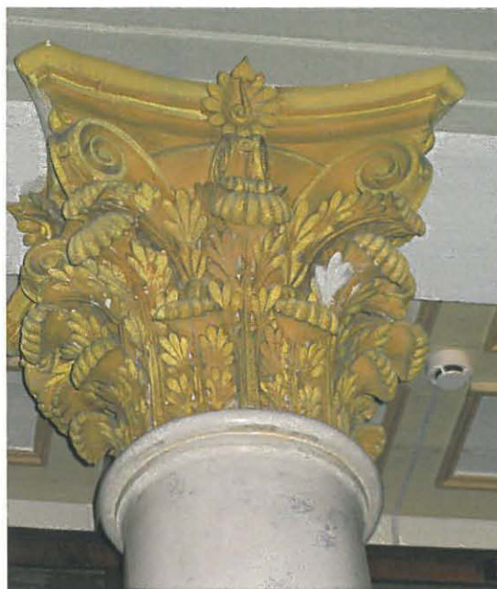
Kipsinen korinttilainen kapiteeli, jonka koristeiden ulkosyrjät on maalattu heleämmällä keltaisella. Vaaleana näkyvä lehdykkä on vuonna 2010 tehdyn korjauksen jäljiltä, tarkoituksella maalaamattomaksi jätetty.
