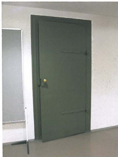
Kupolialiini johtava palo-ovi, joka on tehty Hanssonin peruskorjauksessa uudestaan, mutta vanhoiin heloiin.
