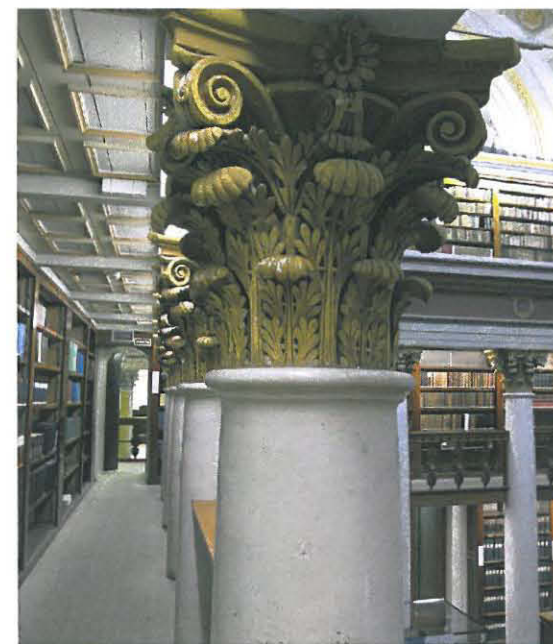
Kipsinen korinttilainen kapiteeli, jonka koristeiden ulkosyrjät on maalattu heleämmällä keltaisella. Vaaleana näkyvä lehdykkä on vuonna 2010 tehdyn korjauksen jäljiltä, tarkoituksella maalaamattomaksi jätetty.
