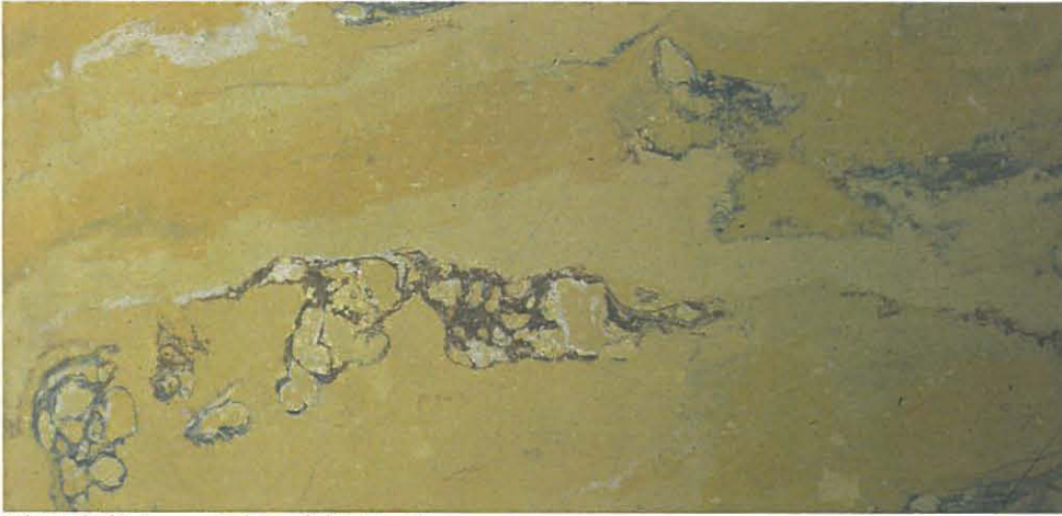
Pohjoissalin kipsimarmoripylvään "keltaista" pintaa
