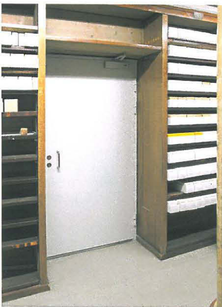
Ovi 3: Ervin suunnitelmien mukaan avattu kulkuyh- teys kirjajhylyjen läpi, jossa uudempi palo-osastoiva peltiovi. Kirjahyllyt on yllättäen muokattu Rotundan kirjahyllyjen osilla.
