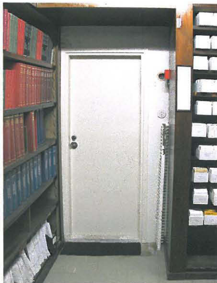
Ovi 4: Jo Engelin aikaan tehty kulkuyhteys pohjoissa- lista nk. lukusaliin eli nykyiseen vaatesäilöhuoneeseen R119, johon Hanssonin suunnitelman mukaan lisäty palo-osastoiva peltiovi.
