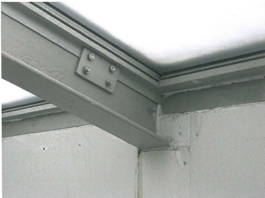
Vesikattorakenteen lämpölasikerros.
