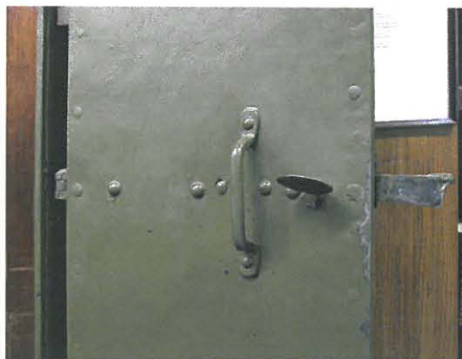
Vanhimman, vuoden 1908 palosuojaoven lukkomekanismi.
