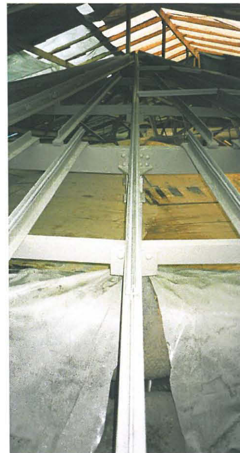
Kuva kattorakenteen perinpohjaisesta kunnostuksesta LPR:n aikana 1998-2000. Kuva Ola Laiho
