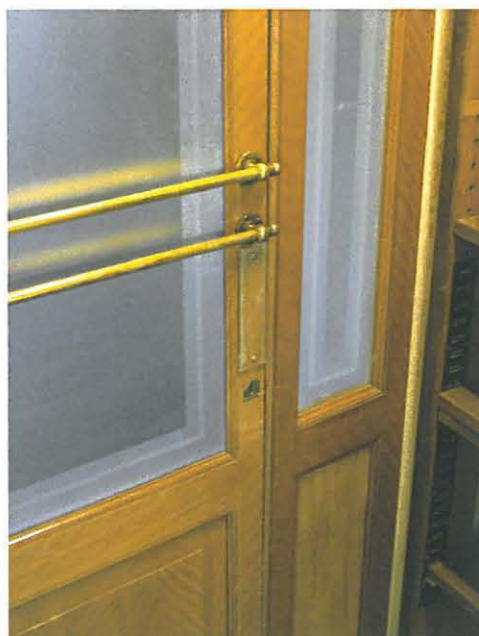
Nyströmin vaiheesta säilynyt, oletettavasti mahnkinen väliovi, jossa etsatut koristelasit ja messinkihelat Rotundan 5. kerroksessa
