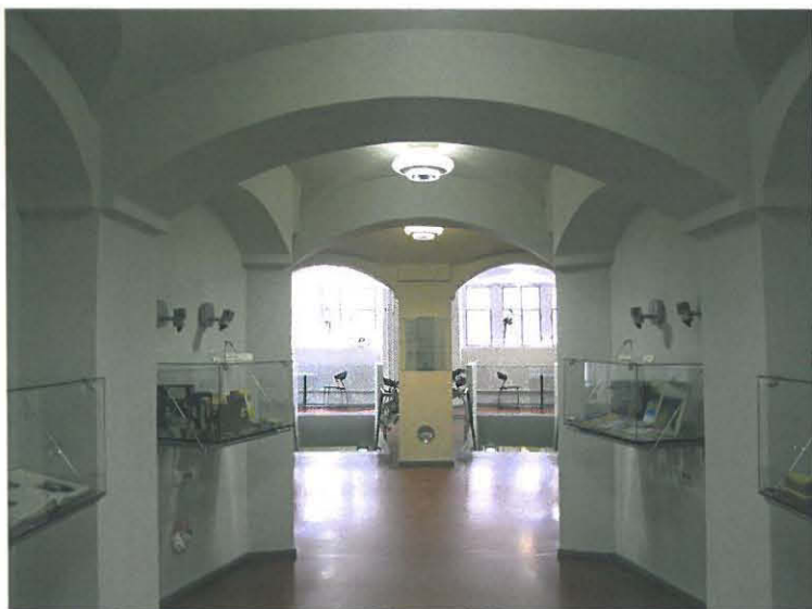
Rotundan kellarikerroksen keskikäytävä / näyttelyaula nykyasussaan. Vain lattiainväli, harmaa nappimatto, on vaihdettu punaiseksi pinnoitteeksi, kellarin kosteusteknisestä toiminnasta johtuen.
