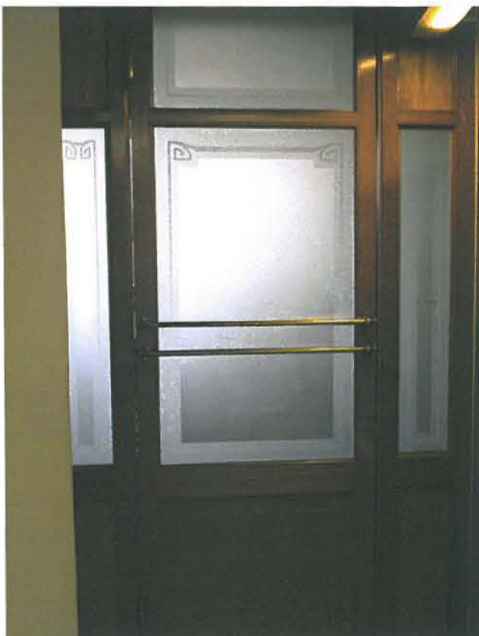
Nyströmin vaiheesta säilynyt, oletettavasti mahnkinen väliovi, jossa etsatut koristelasit ja messinkihelat Rotundan 5. kerroksessa
