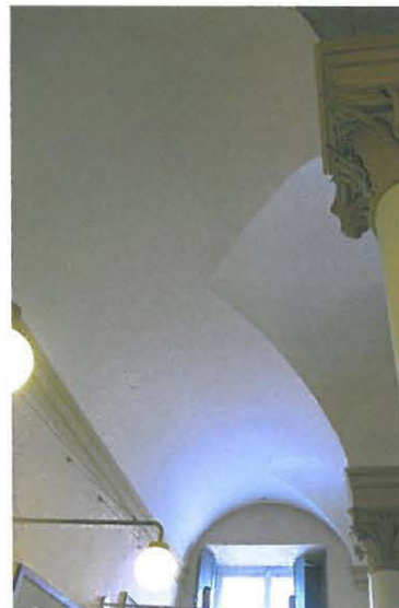
Tynnyriholvin ja ristiholvin liitos
