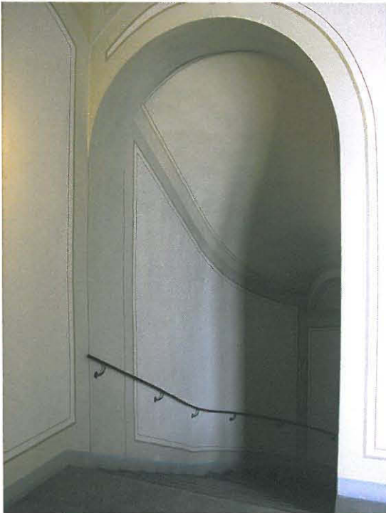
Päärakennuksen vanha porrashuone on tietävästi suurelta osin Sjöströmin 1880-luvun asussa, pintojen osalta väritutkimusta ei ole tullut esille, mutta tunnetut korjausvaiheet (1955-6 ja 1980-l) ovat asiakirjamainintojen perusteella toistaneet edellistä väriasua.
