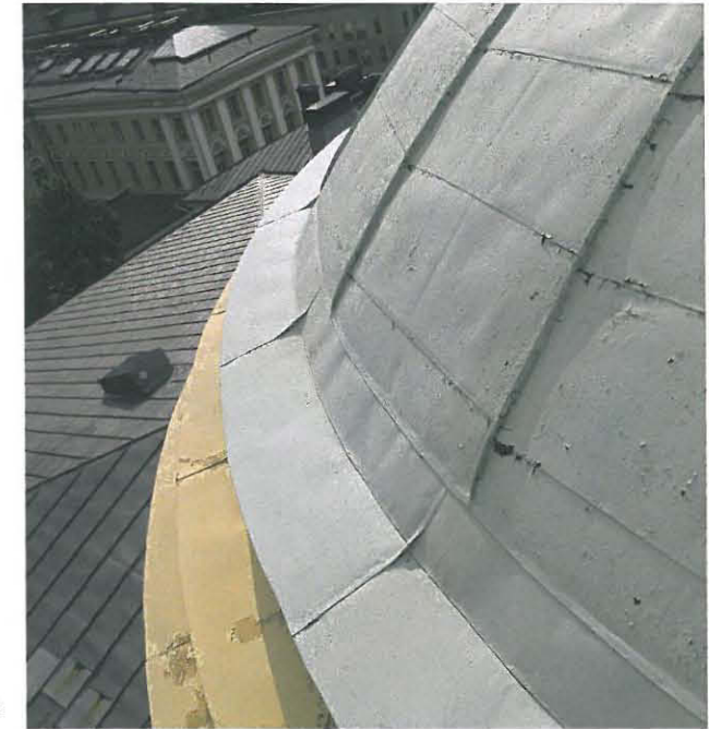
Uudemman ja vanhemman pellin rajapinta erottuu kuvassa selvästi. Vanhemman pellin päällä maalikerrosten tartunta on selvästi heikompaa. Kuva 2011
