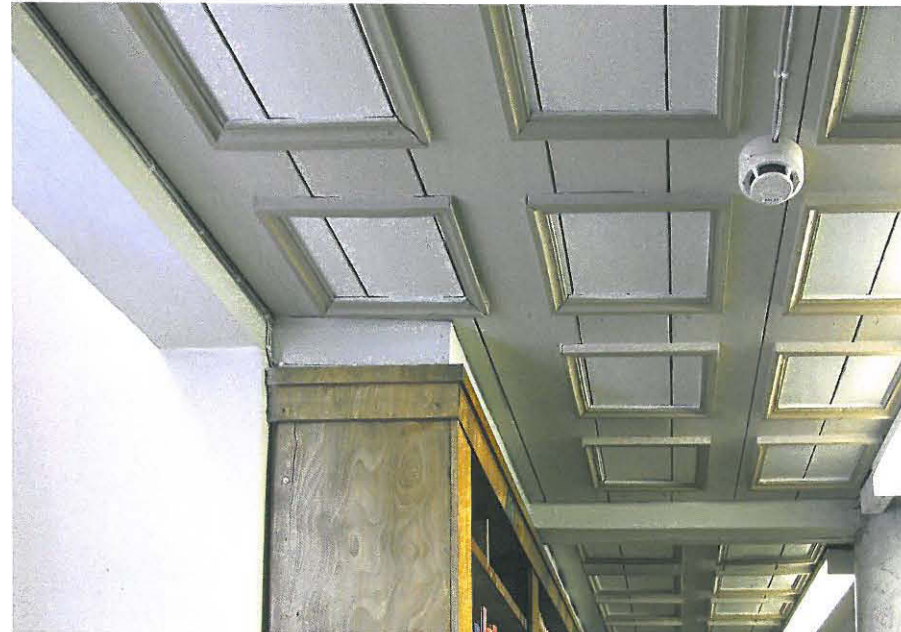
Eteläsalin keskilehterin muodostamaa alakattoa eteläisellä seinustalla; etualalla ikkuna-aukon kohta, jossa pienempi ja tiheämpi peilijako kuin muissa katon osissa.
