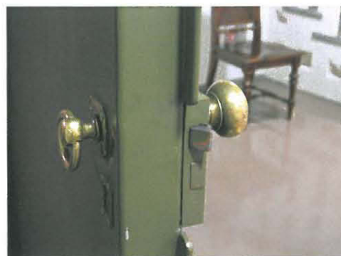
Kupolialiini johtava palo-ovi, joka on tehty Hanssonin peruskorjauksessa uudestaan, mutta vanhoiin heloiin.
