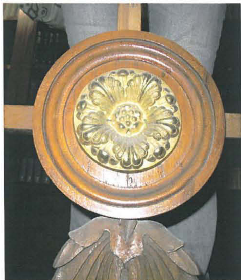
Peruskaiteen (vieressä) messinkipeltinen 5-lehtinen koriste-ruusu. Kuvassa olevan kaiteen ylempi puinen lehdykkä on irronnut.
