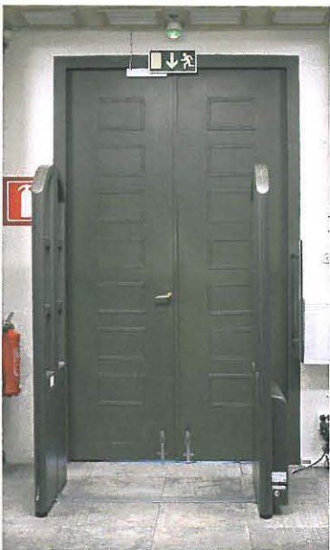
Ovi 3 eli Hanssonin suunnittelema palo-ovi PO1 ja samaan sävy maailmaan soinnutettu kulunvalvontalaite.
