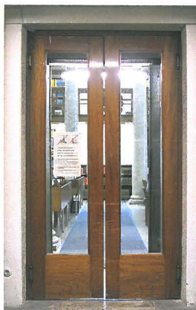
Ovi 2 eli tiettävästi 1954-1957 peruskorjauksessa uusittu ovi; vrt. viereinen kuva ja esim. alapeilirakenne.
