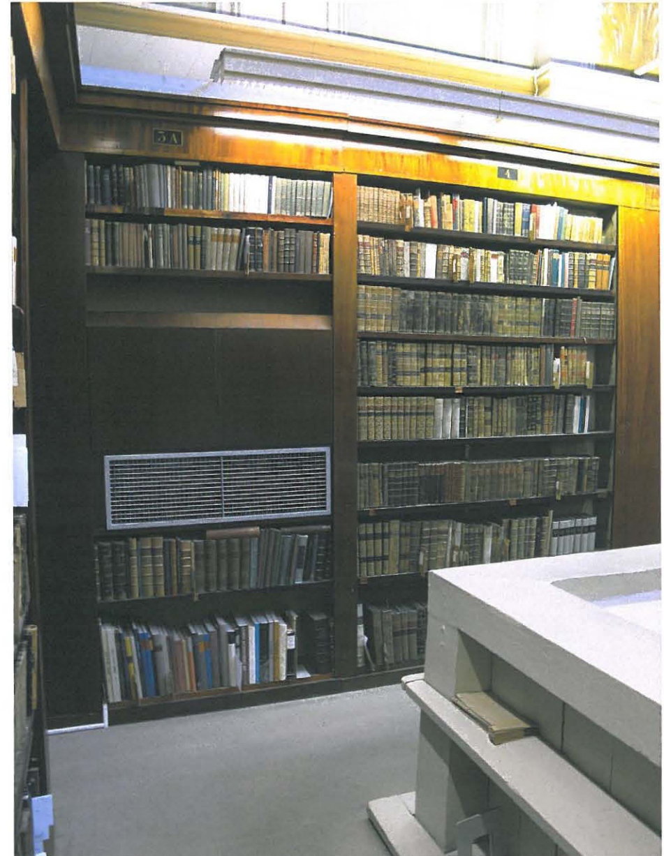
Koko peruskorjauksen vaikeimpia tehtäviä oli ilmanvaihdon ratkaiseminen komeita tiloja turmelematta. Suurien salien ilmanvaihdon pääreitit sijoitettiin kirjahyllyihin. Vaakavedot asennettiin kirjahyllyjen päälle, otasalauksen ja valaisinrampin taakse, jokseenkin näkymättömiin. Ilmanvaihtosäleikköjä sijoitettiin salien nurkkiin siten, että asennustilat peitettiin mahonkiviilutetulla lastulevyllä ja IV-säleiköt ovat paljaana kirjahyllypinnassa. Kuva 2011
