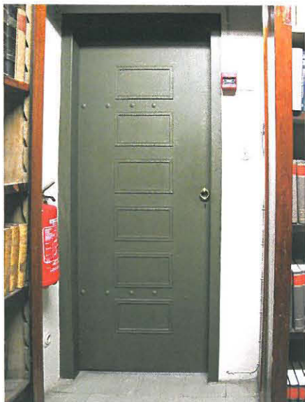
Ovi 2: Hanssonin suunnittelema palo-ovi eteläsalin ja porrashuoneen R106 välillä, oletettavasti vanhoilla heloilla varustettuna.
