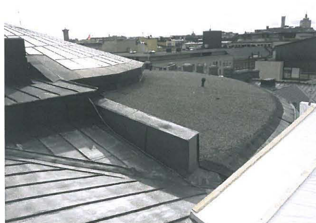
Alla nykyinen Rotundan umpiosan kate, tieltävästi hitsattua bitumikermiä jonka päällä on soraa. 2011.
