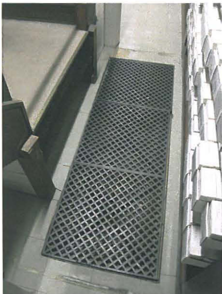
Vanhempi valurautainen ritilä pohjoissalin itäpäässä, peittää kanavaa tms. jonka käyttötarkoitusta ei tunneta.
