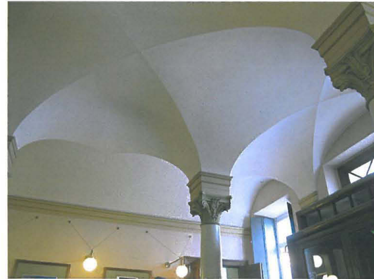
Eteishuoneen holvimuurattu katto muodostaa geometrisesti sängen rikkaan ja monimuotoisen kokonaisuuden:
