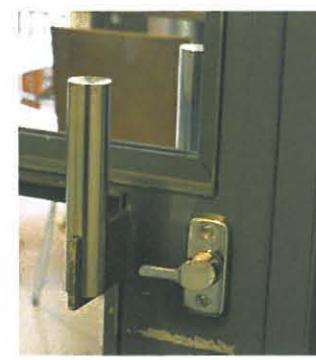
LPR:n suunnittelema tyypillinen, vakiorakenteinen teräslasi-ovityyppi, jossa erikoismallinen rst-vedin.
