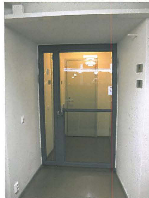
LPR:n suunnittelema tyypillinen, vakiorakenteinen teräslasi-ovityyppi, jossa erikoismallinen rst-vedin.
