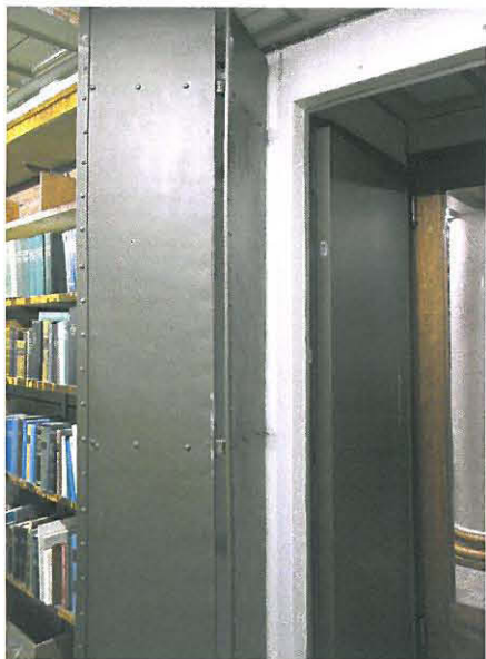
Ovet 1a ja 1b: Kolme erilaista ja eri-ikäistä ovea eteläsalin ja kupolisalin välillä, vasemmalta lukien: taottuvalehtinen palosuojaovi (luukku), Hanssonin suunnittelema palo-ovi PO4 ja tiittävästi 1950-luvulla uusittu mahonkipintainen lasipariovi.
