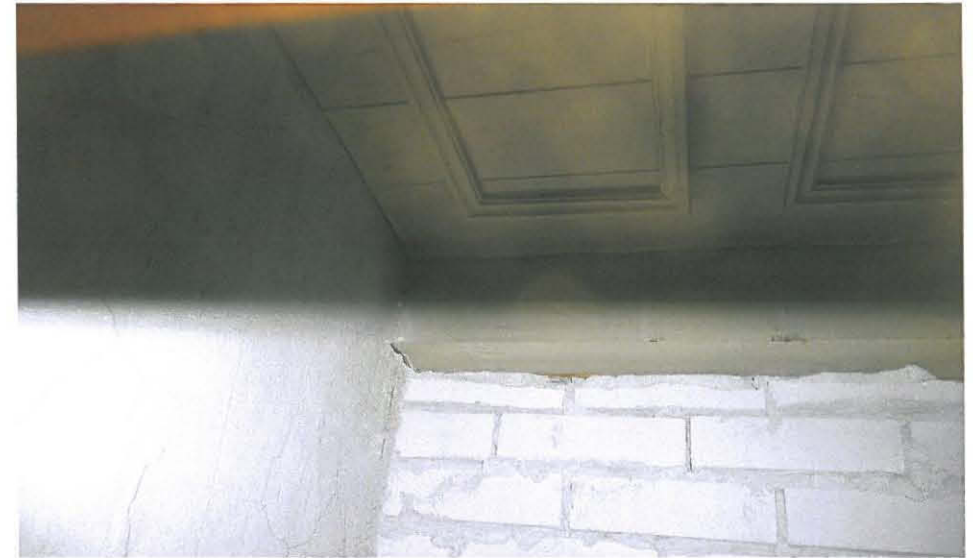
Yllä kupolisalini keskilehterin vanha keskiakselini oviaukko, joka Hanssonin vaiheessa muurattiin umpeen kahitiileillä. Kattopaneloinnissa esiintyy siis oletettavasti 1880-esillä ollut yksivärinen väriyty. 2011
