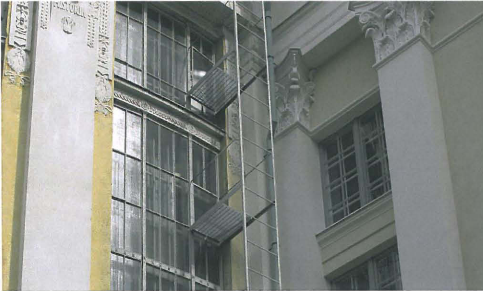
Rotundan ja päärakennukseen väliseen eteläiseen sisänurkkaan sijoitettu terästikas hätäpoistumistienä. Kuva 2011
