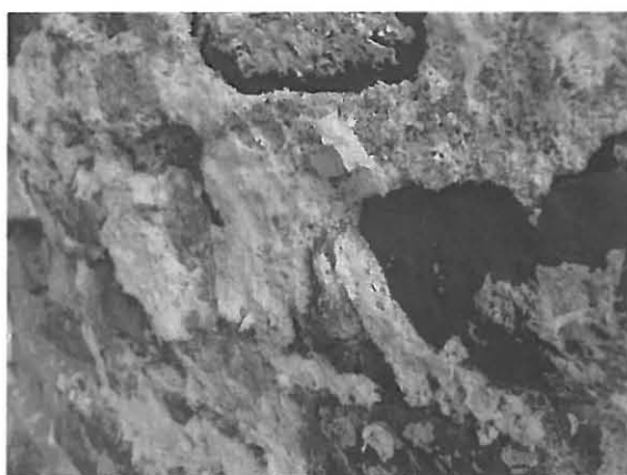
KUVA 27. Ampuma-aukon L 109 pinnan suolakiteytymää.
