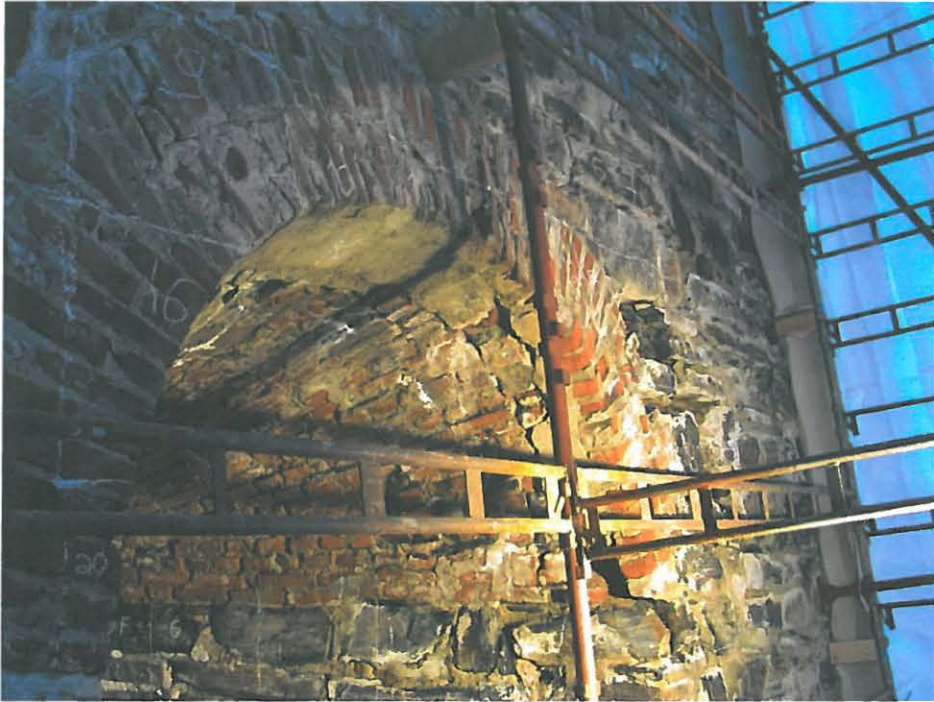
KUVA 18. Ampuma-aukon L 206 holvikaari ruudutettuna ja numeroituna.
