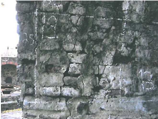
KUVA 24. Ampuma-aukon L 103 halkeamaverkostoa.
