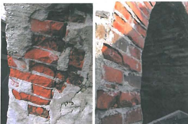
KUVAT 28 ja 29. Ampuma-aukon L 109 holvikaaren uudet tiilet eivät ole kestäneet vaikeissa olosuhteissa joustamattoman korjauslaastin kanssa.
