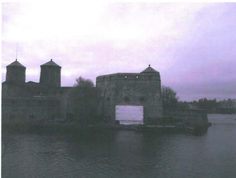
KUVA 5. Paksun bastionin edessä pressuilla suojatut rakennustelineet syksyllä 2009.
