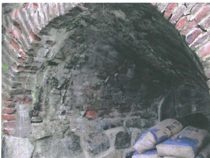
KUVA 32. Ampuma-aukko L 104 kärsii kosteudesta. Kosteus on edesauttanut biologisen kasvuston muodostumista.
