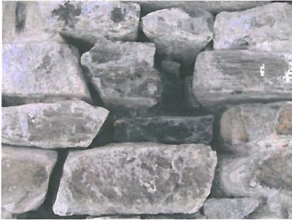
KUVA 8. Paksun bastionin avattua muuripintaa.
