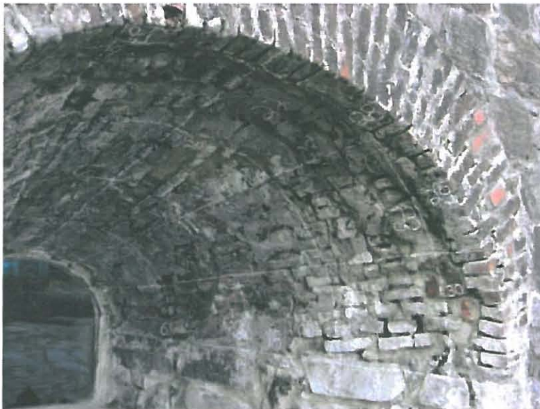
KUVA 16. Ampuma-aukon holvi on ruudutettu ja numeroitu dokumentoinnin helpottamiseksi.
