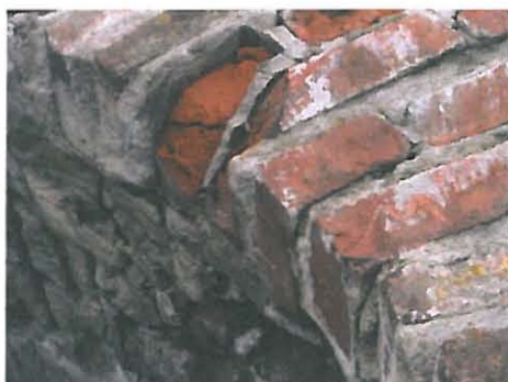
KUVA 30. Kuvassa ampuma-aukon L 207 holvikaari. Laasti on kestänyt, tiili ei.
