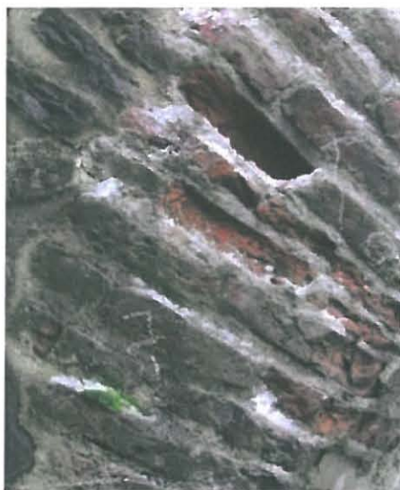
KUVA 31. Ampuma-aukon L 104 holvikaaren vaaleat tiilet ovat rapautuneet pakkasen vaikutuksesta. Huomiona: Kuvan valkoiset alueet ovat lunta, eivät suolaa!
