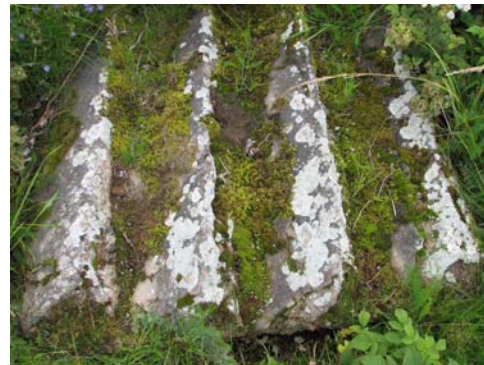
Kuva 17. Osia perustuksesta (nro 168).
