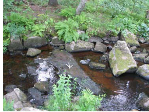
Kuva 36. Lähikuva mylly perustuksesta (nro 117).
