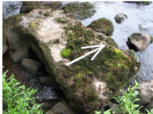
Kuva 48. Yksittäinen osa rakenteita ollut kivi (nro 038).
