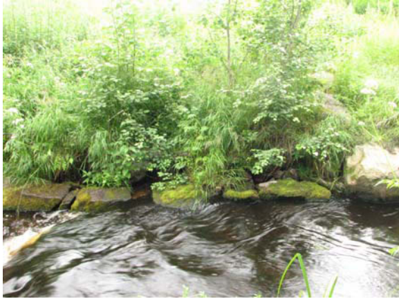
Kuva 27. Perustus rannassa (nro 046).
