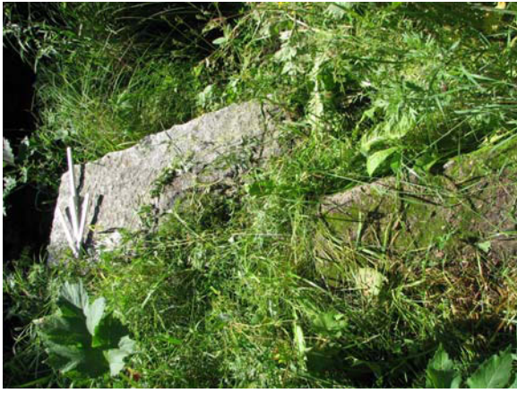
Kuva 73. Perustus rannassa (nro 065).
