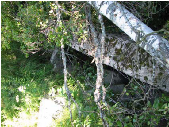
Kuva 75. Uoman keskellä oleva betoniperustus (nro 066).
