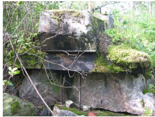
Kuva 9. Betoniperustus II (nro 155).
