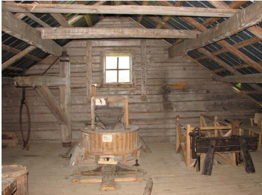
Kuva 56. Yleiskuva yläkerroksesta (nro 007).
