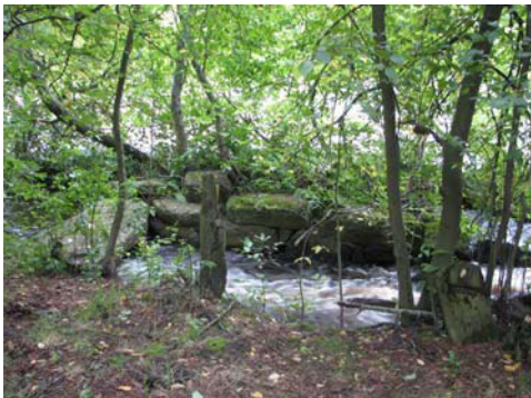
Kuva 40. Yleiskuva myllyn perustuksesta (nro 170).
