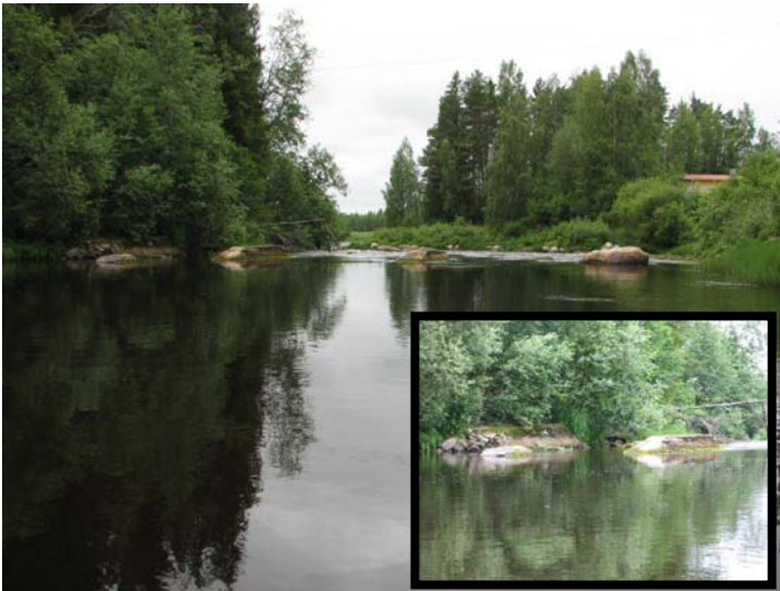
Kuva 44. Ennen koskea sijaitsevat 1900-luvun sillan jäänteet (nrot 041, 042).
