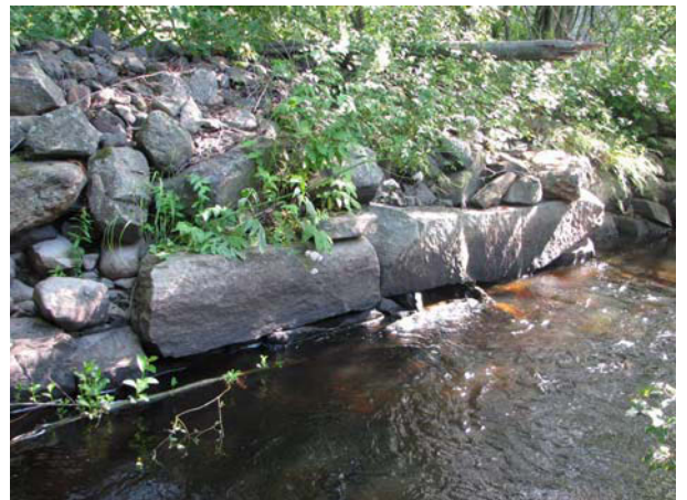
Kuva 21. Lähikuva kiviperuksesta uomassa (nro 061)
