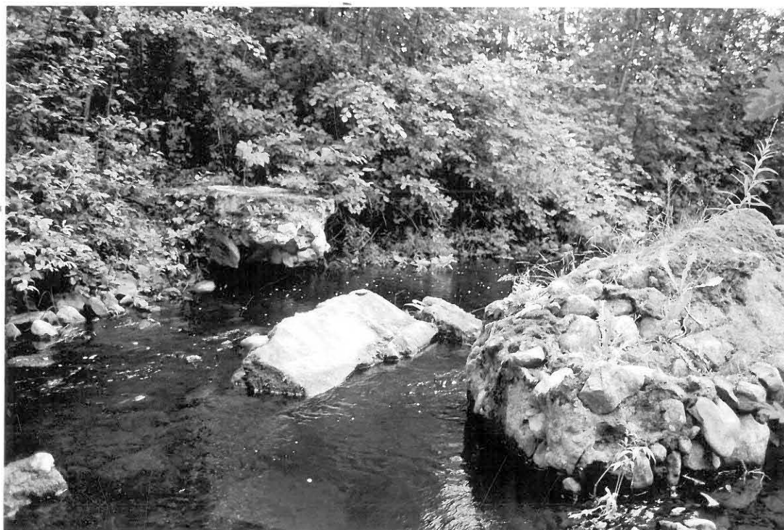
125725:26 26 Kannus Jäväjänkoski Betoniperustukset uomassa ja saarella 100 ML 25.7. 2007
