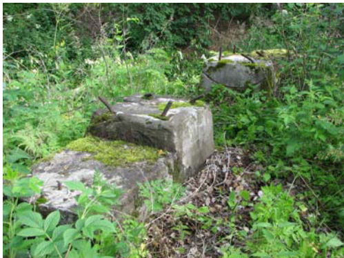
Kuva 8. Betoniperustus II (nro 156).
