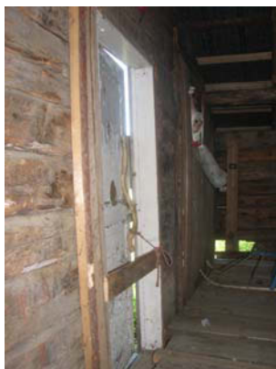
Kuva 69. Yläkerrokseen kunnostuksen yhteydessä laitettu ovi (nro 086).
