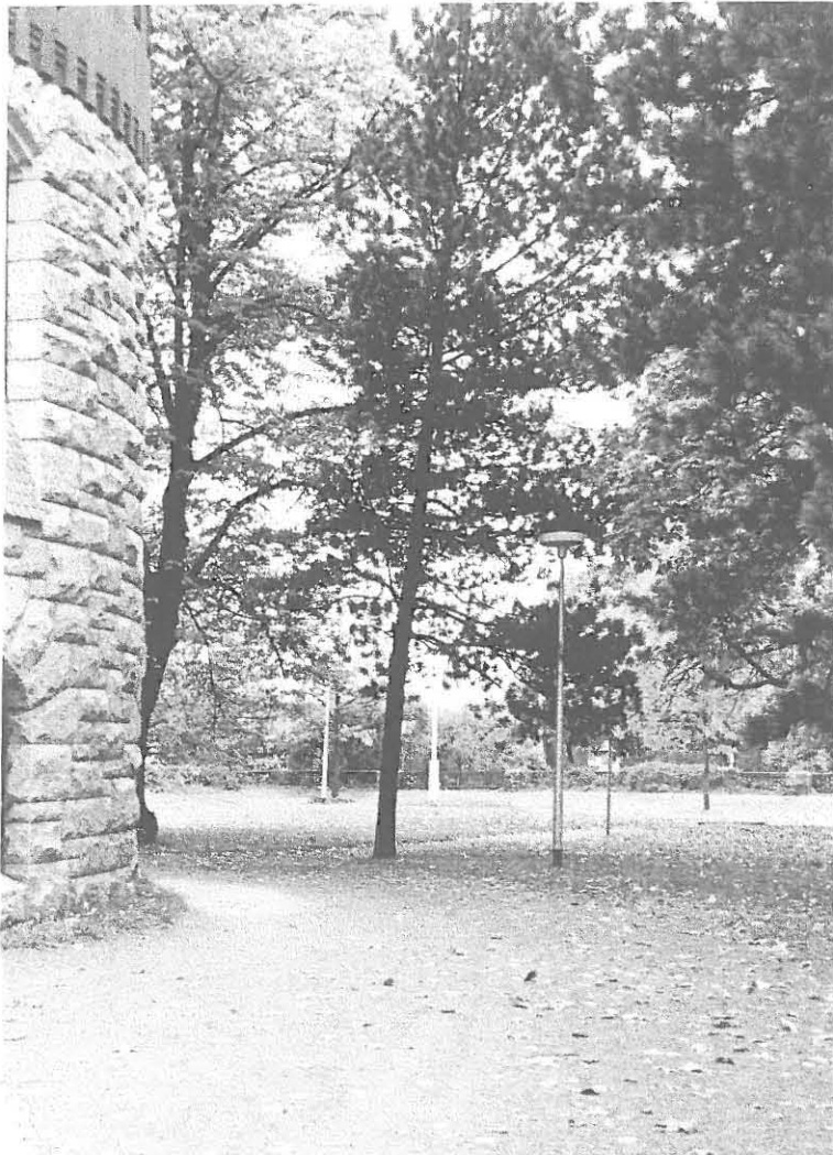
49. Pyöreän kulmatornin kohdalta etelään. Mänty on kasvanut valoa kohti vinoon, rakennusta reunustava nurmikko on kaventunut käytävän pinnan noustessa. JP 9/93, MV
