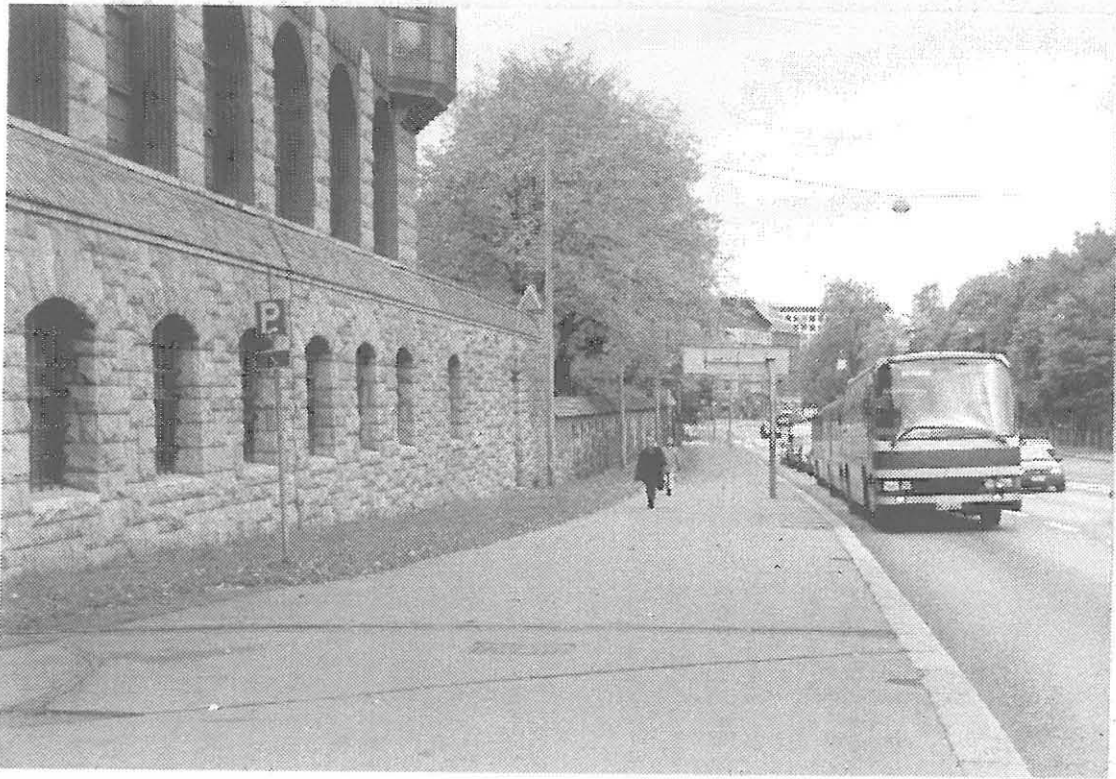
86. Mannerheimintien puoleinen jalkakäytävä. Tietyn levyinen kaistale on asfaltoitu ja jäljelle jäävällä osalla on nurmikkoa. JP 9/93, MV
