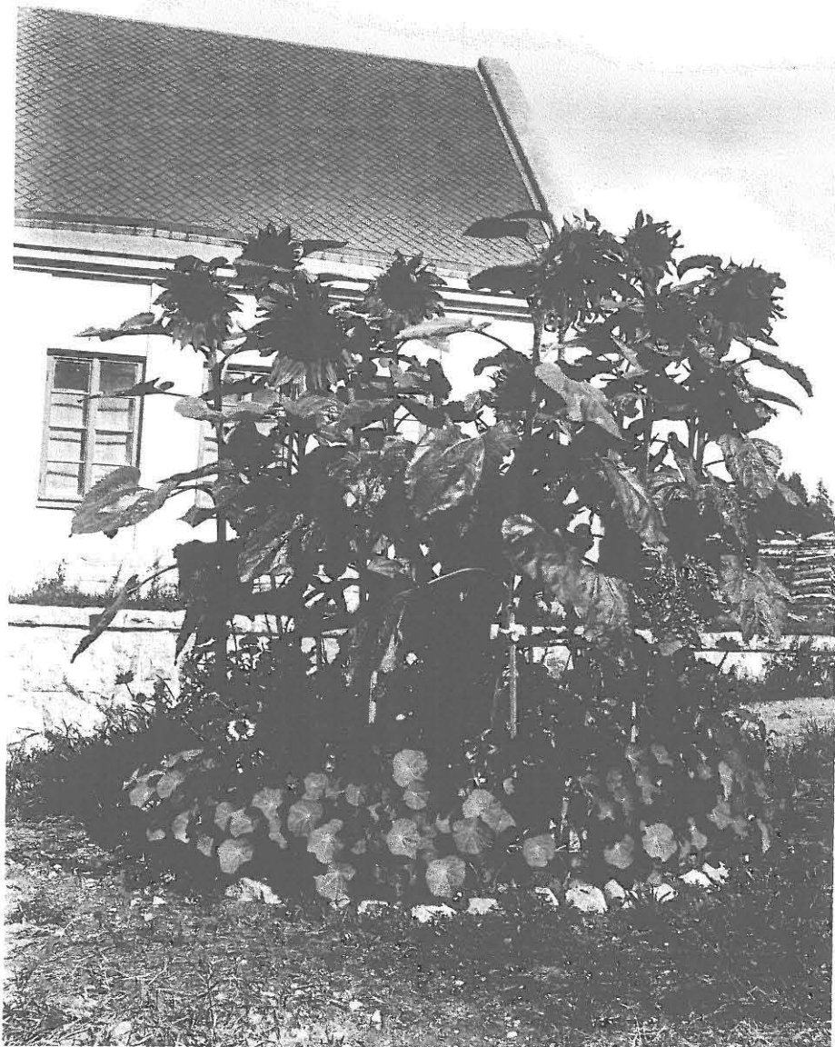
26. E. Holmbergin auringonkukkapenkki 1916. Taustalla desinfiointilaitos. MV 8850
