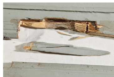
Kuva 2. (Yllä) Hilseilevää maalia. Kuva 3. (Vas.)Kärpäsen ulostetta
