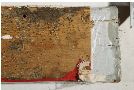
Kuva 1. (Yllä) Vauriokuva. Pinttynyttä likaa ovesta.
