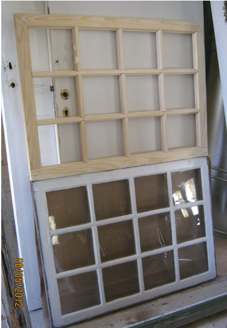
Kuva 28. Alkuperäinen ja uusi ikkuna.
