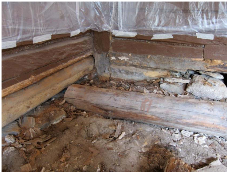
Eteisen lattialankkujen kannattajaniska maassa
