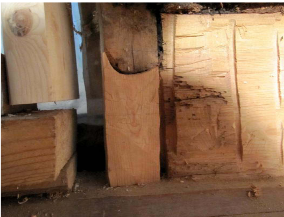
Alimmassa kuvassa on karapuun alaosa korjattu. Kunniahuoneen eteläseinä, oven oikea puoli.
