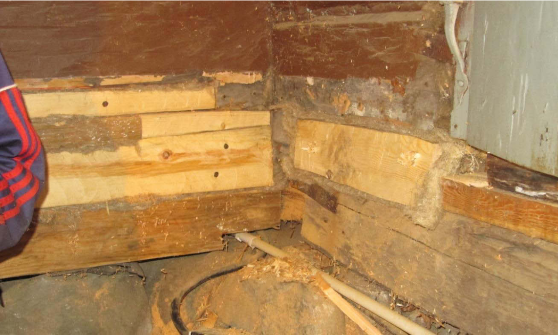
Kuvassa pohjoisseinän ja itäseinän hirsipaikkaukset
