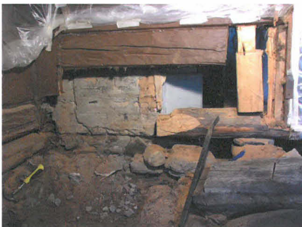
Kuvat 20 ja 21. Eteisen ja asehuoneen välisen seinän korjausta. Korjaus jouduttiin toteuttamaan pala palalta tilanahtauden vuoksi. (J.Toivio)
