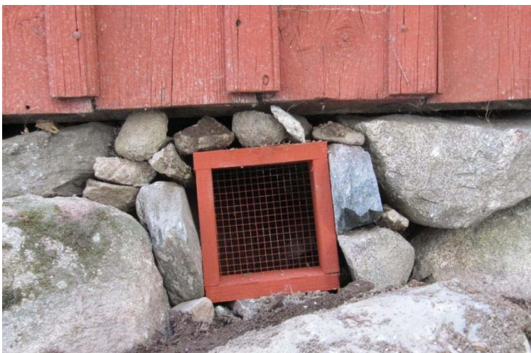
Uusi tuuletusaukko pitkällä sivulla läntisellä julkisivulla
