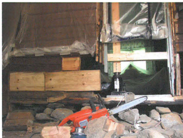
Kuvat 20 ja 21. Eteisen ja asehuoneen välisen seinän korjausta. Korjaus jouduttiin toteuttamaan pala palalta tilanahtauden vuoksi. (J.Toivio)
