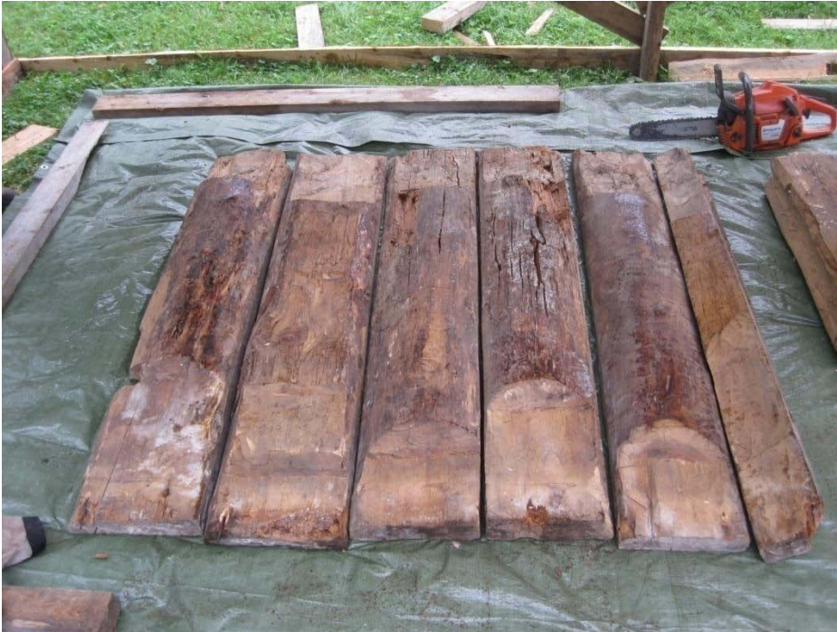
Lankut ulkona vaurioiden selvittämistä, dokumentoimista ja puhdistusta varten.
