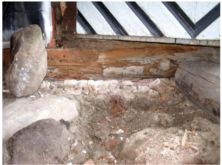
Alimman hirsikerran alapuolinen rakenne
