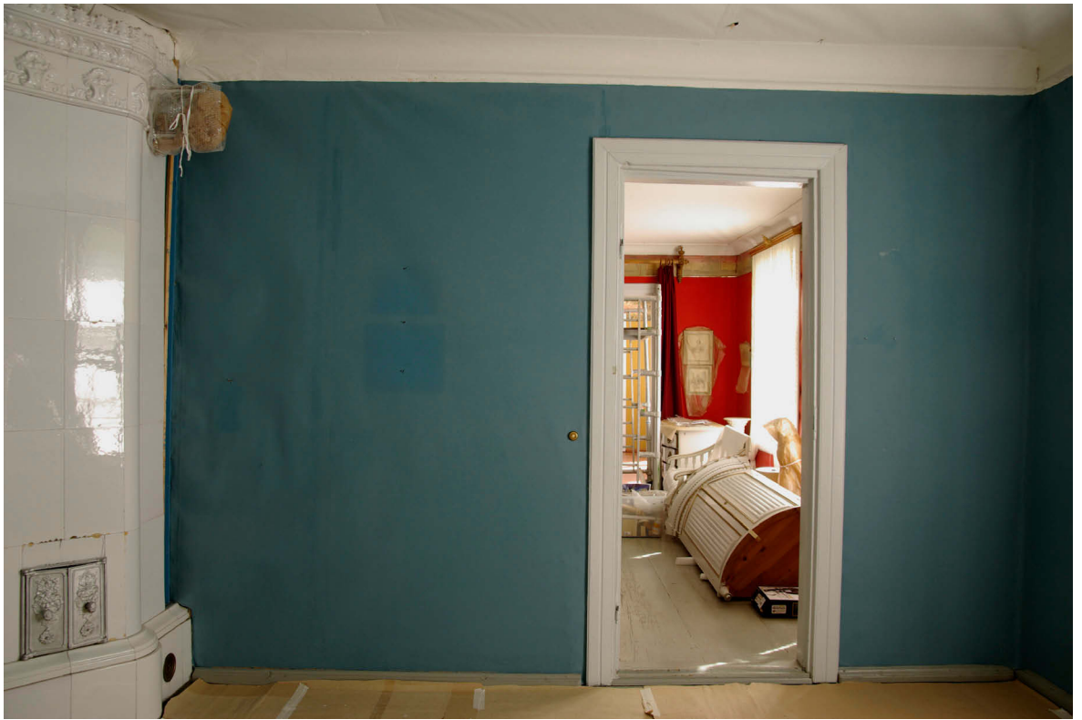
Lilly von Heidemanin huone itäseinä ennen ja jälkeen konservoinnin
