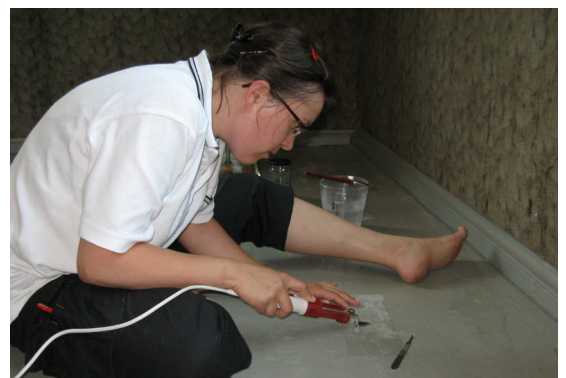
Maali-kerrosten kiinnittäminen lämpö-sikalla liiman levittämisen jälkeen
