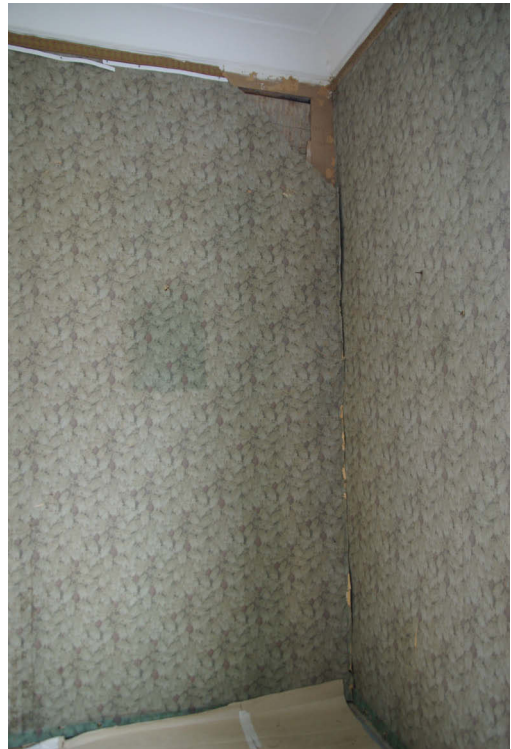
Luoteisnurkan revennyt kulma on irroitettu takaisin kiinnittämistä varten
