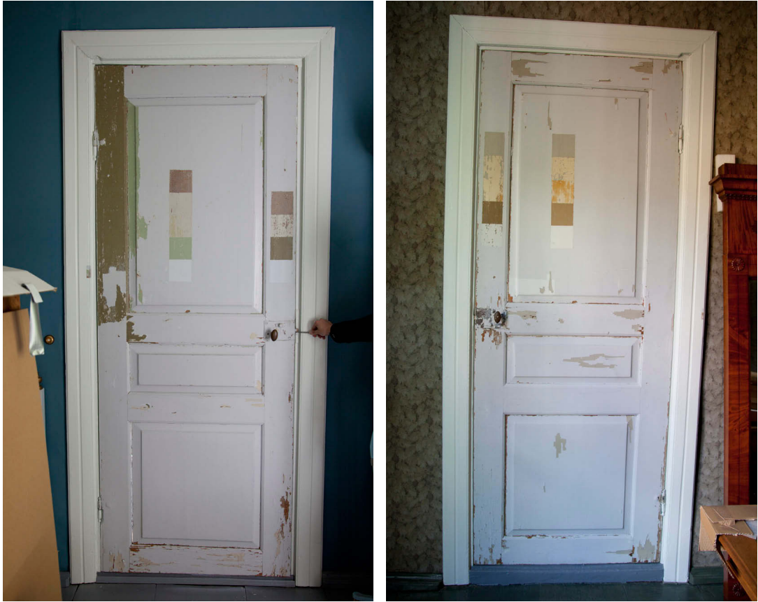
Vasemmalla Lillyn huoneen ovi ja oikealla vierashuoneen ovi ennen maalin poistoa, listat on maalattu.
