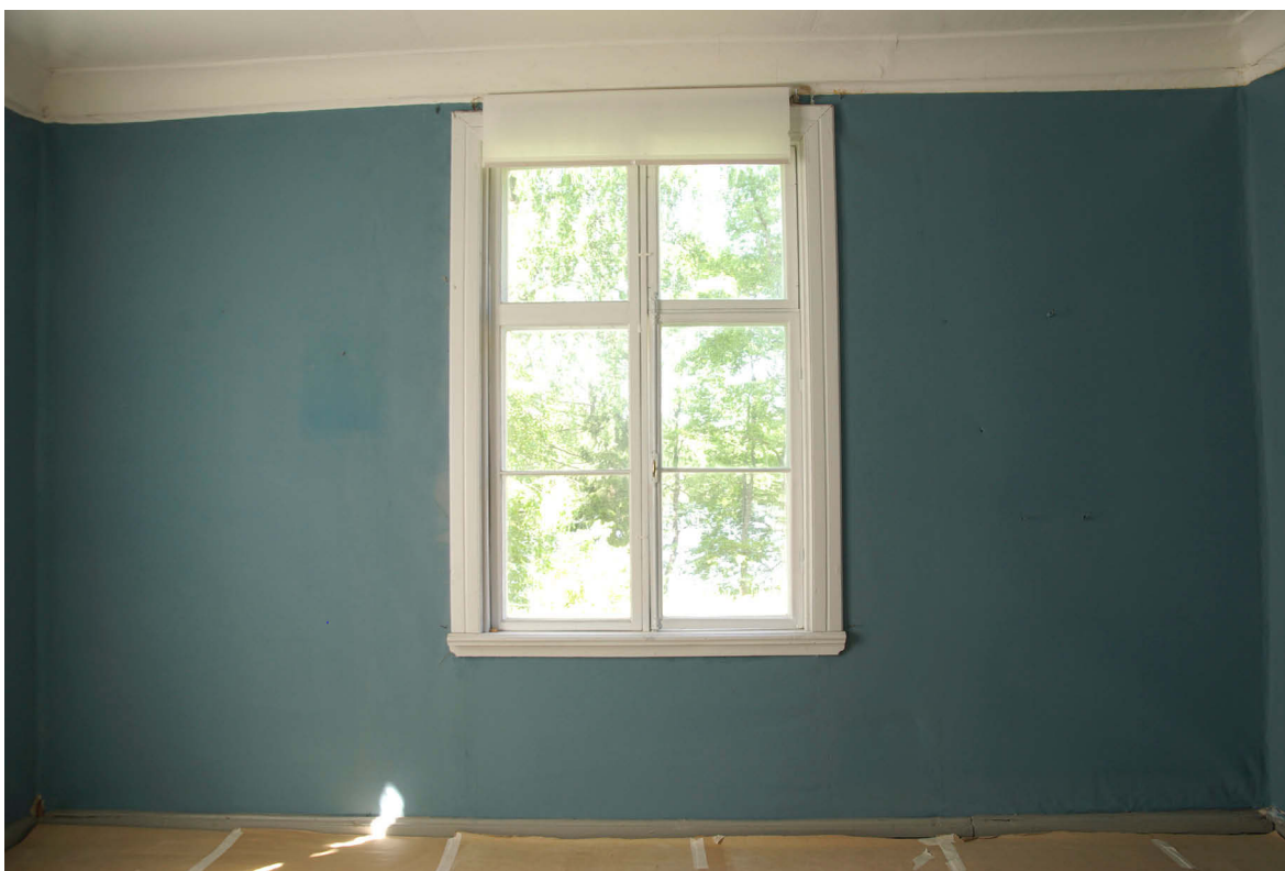
Lilly von Heidemanin huone länsiseinä ennen ja jälkeen konservoinnin
