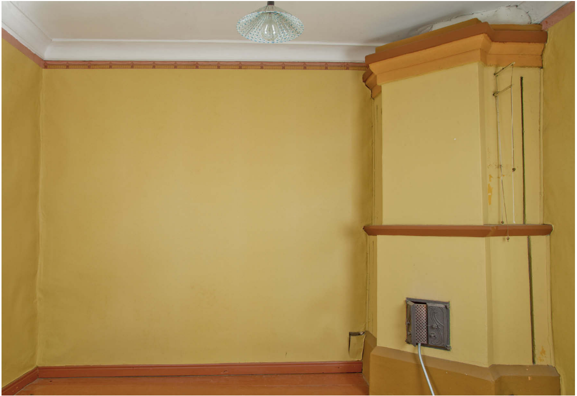
Kuva 20: Pohjoisseinä ennen konservointia.
