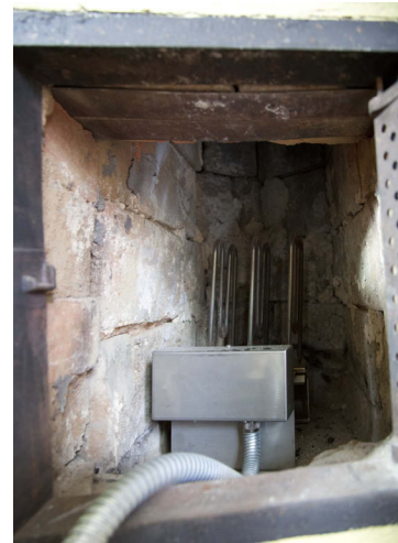
Kuva 35: Uuniin irtoasennettu lämmitysvastus.
