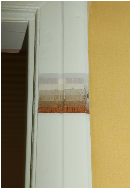
Kuva 18: Väriportaikko itäseinän ovilistassa.
