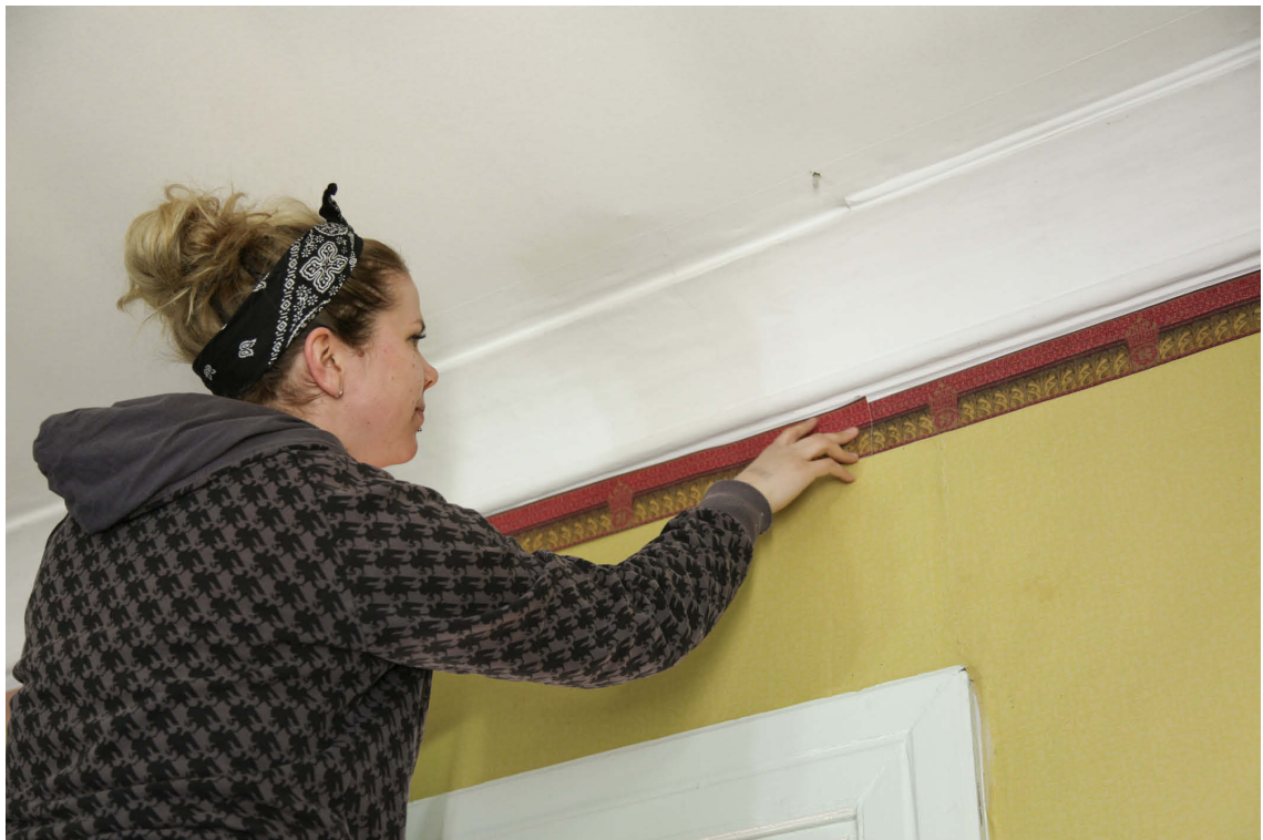
Kuva 8: Kopioboordin kiinnitys tehtiin keväällä 2013.
