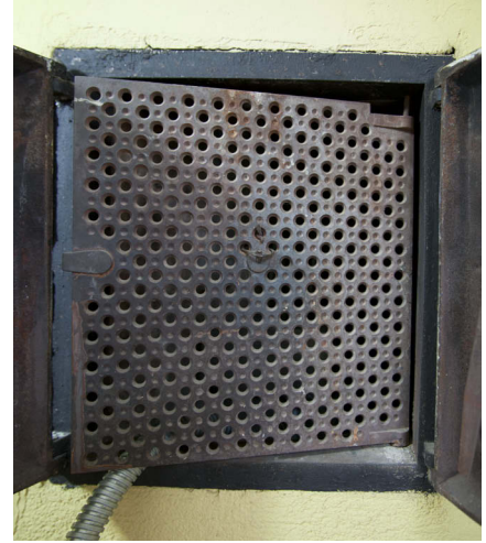
Kuva 33: Kipinäverkko ennen konservointia.
