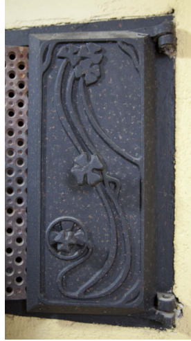
Kuva 32: Uunin suuluukut ennen konservointia.
