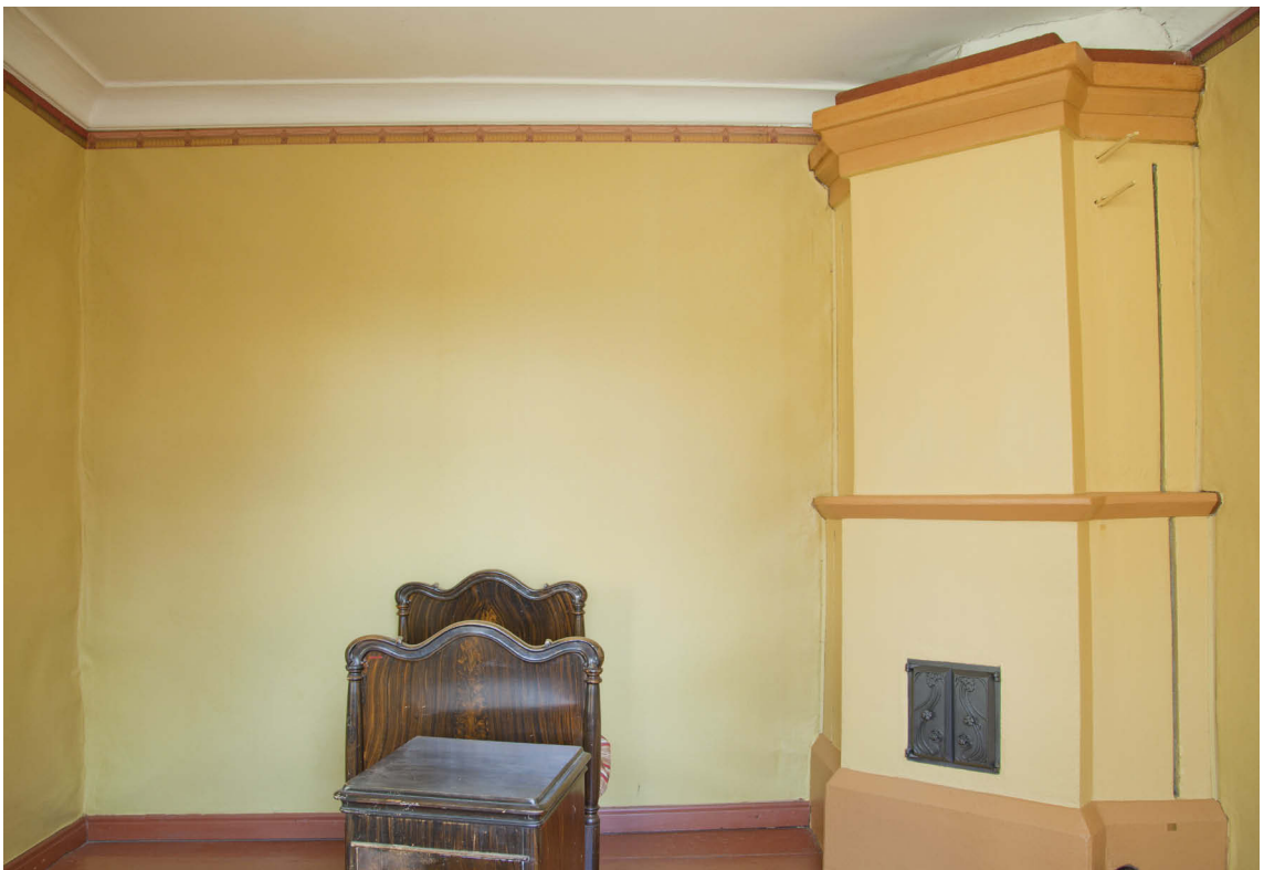
Kuva 21: Pohjoisseinä konservoinnin jälkeen.
