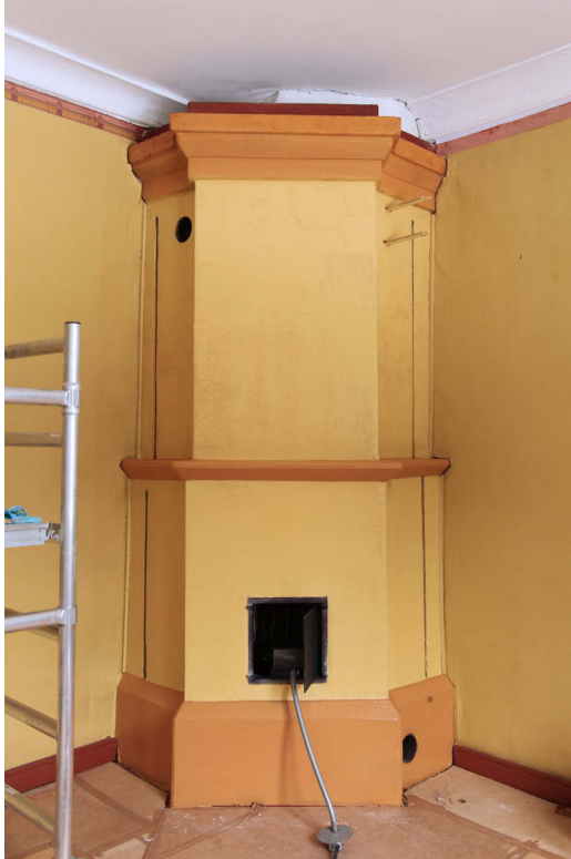
Kuva 16: Uuni yhteen kertaan maalattuna.
