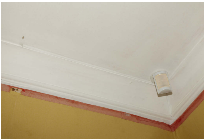
Kuva 7: Liimapaperi holkkalistan alapuolella ja liiketunnistimen johdon peittona.
