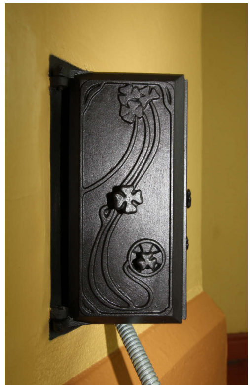
Kuva 15: Uunin luukut käsittelyn jälkeen.
