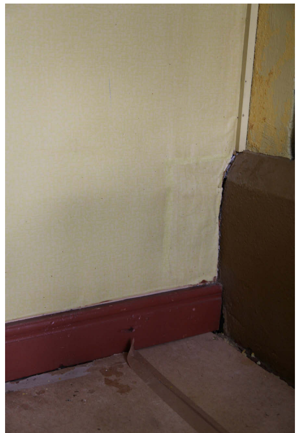
Kuva 12: Tapettiavaus paikattuna.
