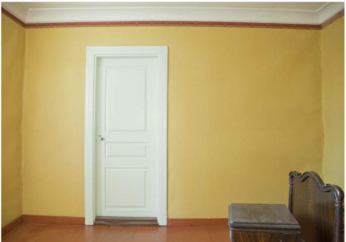
Kuva 27: Länsiseinä konservoinnin jälkeen.
