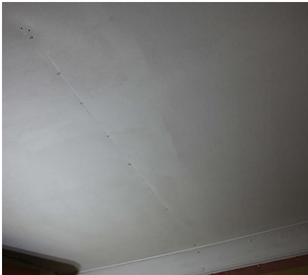
Kuva 5: Katto ennen paikkausta.
