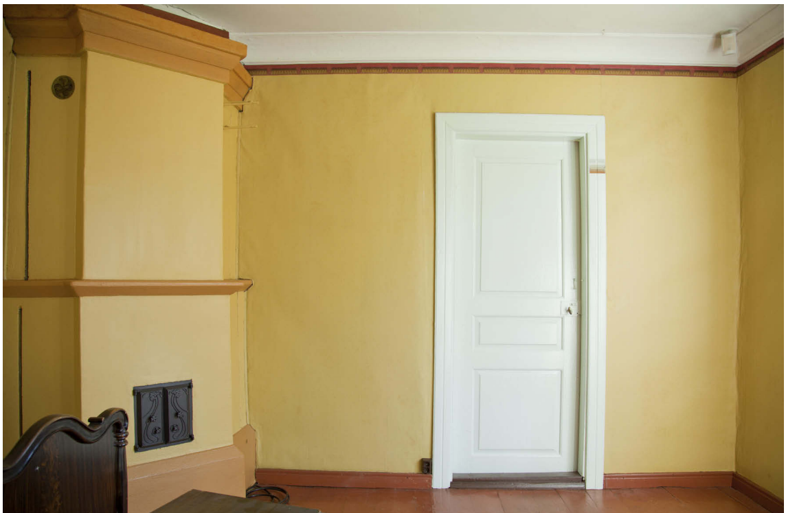
Kuva 23: Itäseinä konservoinnin jälkeen.
