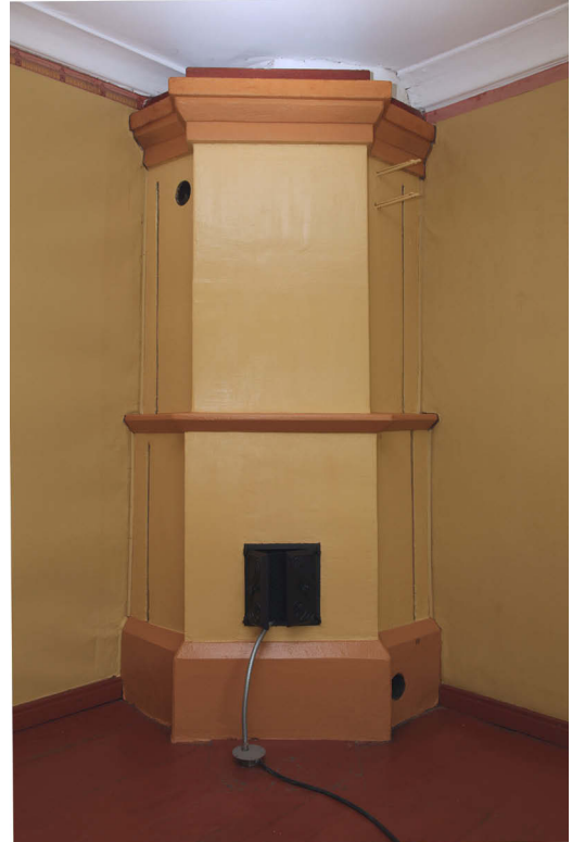
Kuva 17: Uuni kahteen kertaan maalattuna.
