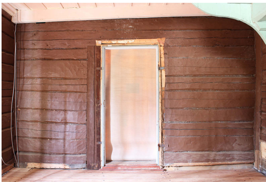
Kuva 39: Eteläseinä hirsikorjausten jälkeen.
