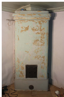
Kuva 20: Uunin irtoavat maalikerrokset on poistettu.
