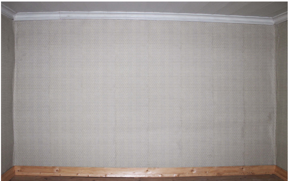
Kuva 45: Pohjoisseinä konservoinnin ja restauroinnin jälkeen.
