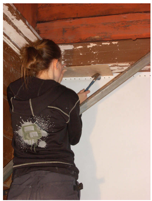
Kuva 11: A-M. Kuitunen suojaa palkkia vasaralta kovalevyllä.
