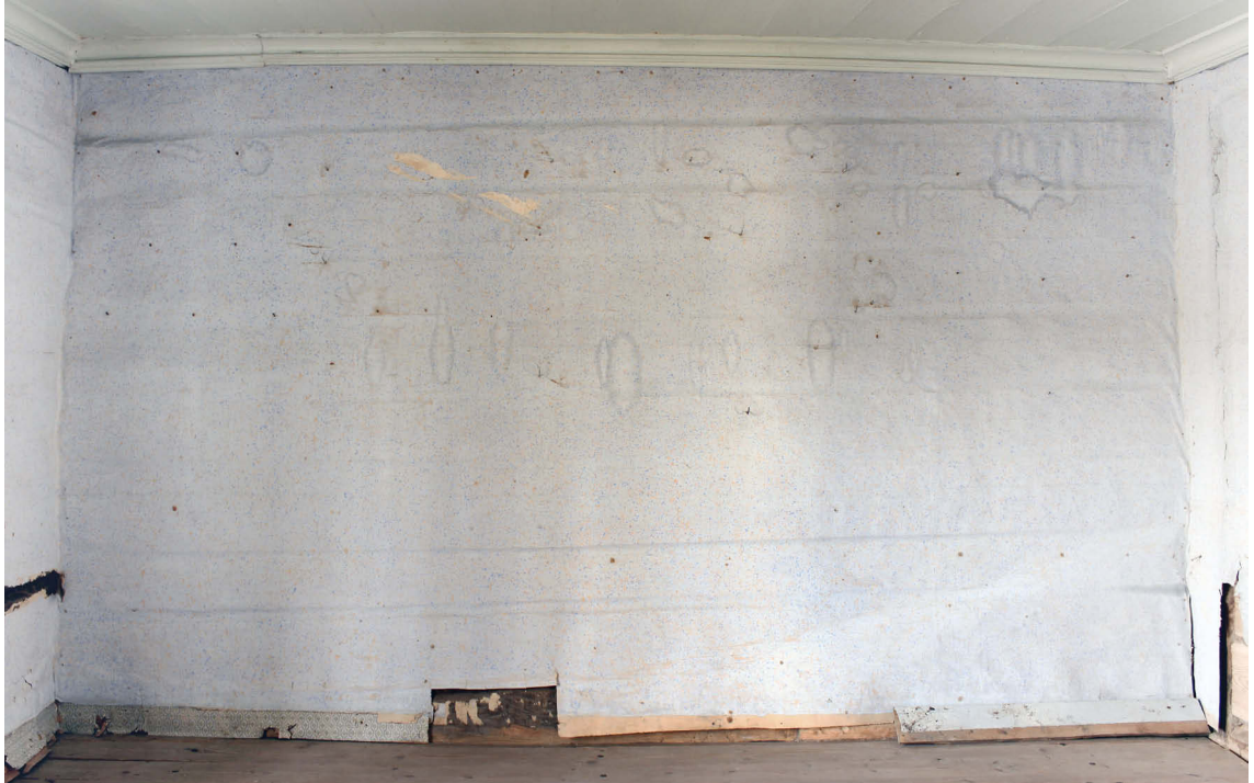
Kuva 44: Pohjoisseinä hirsikorjausten jälkeen, ennen konservointia ja restaurointia.
