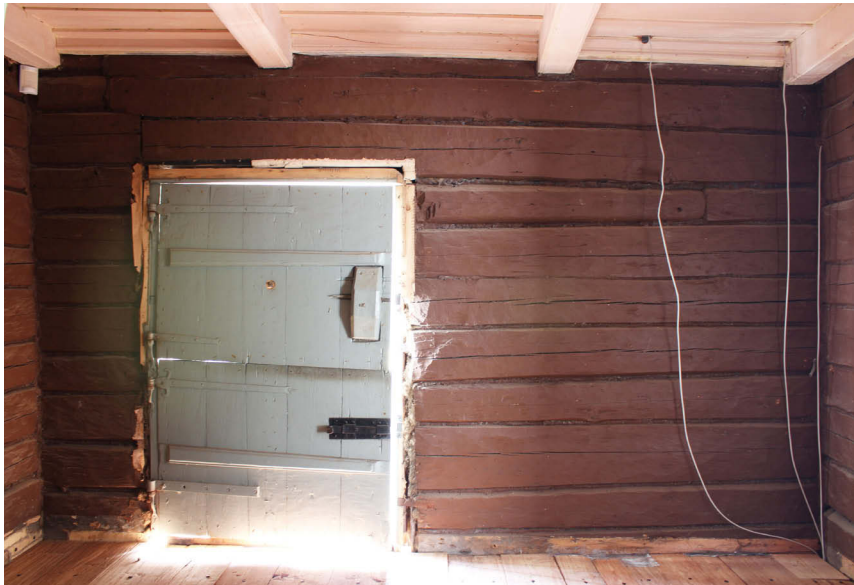
Kuva 36: Itäseinä hirikorjausten jälkeen. Paloilmoinjärjestelmä siirrettiin tupaan.
