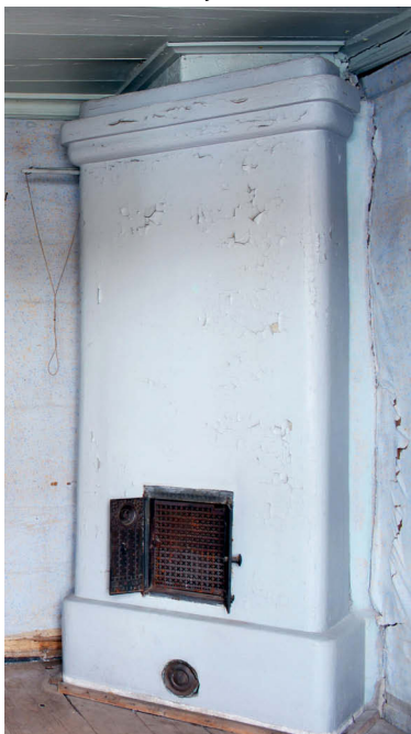
Kuva 19: Uuni ennen restaurointia.
