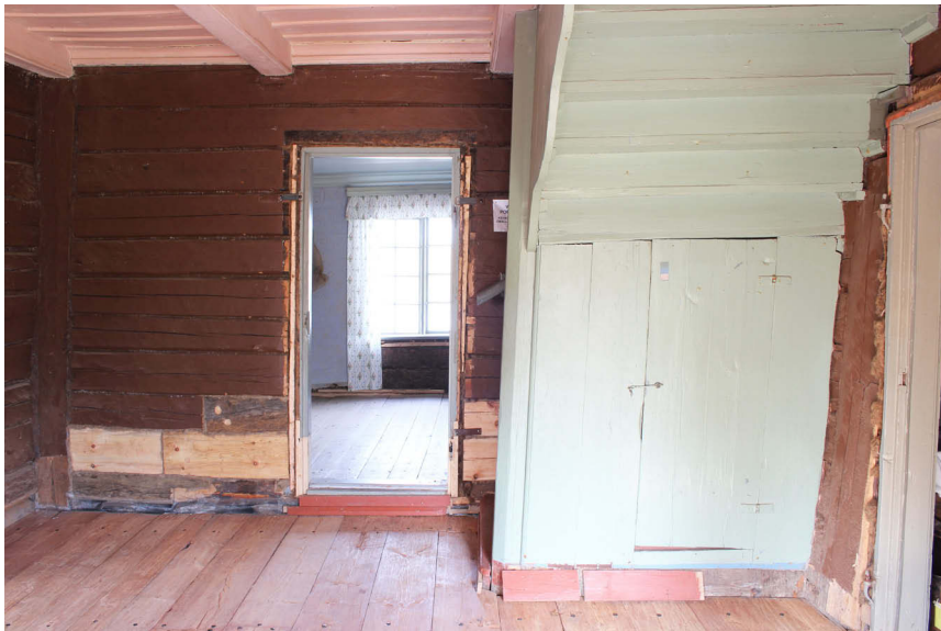
Kuva 42: Länsiseinä hirsikorjausten jälkeen.
