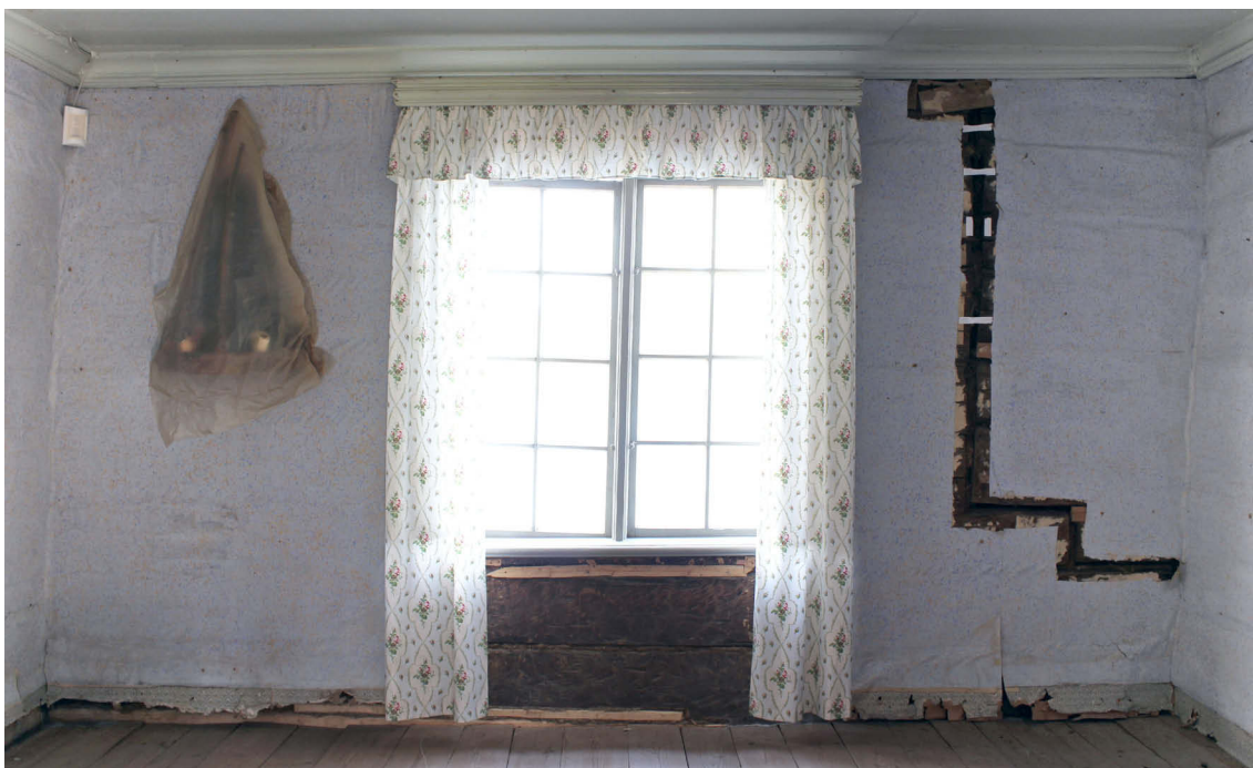
Kuva 50: Länsiseinä hirsikorjausten jälkeen, ennen konservointia ja restaurointia.
