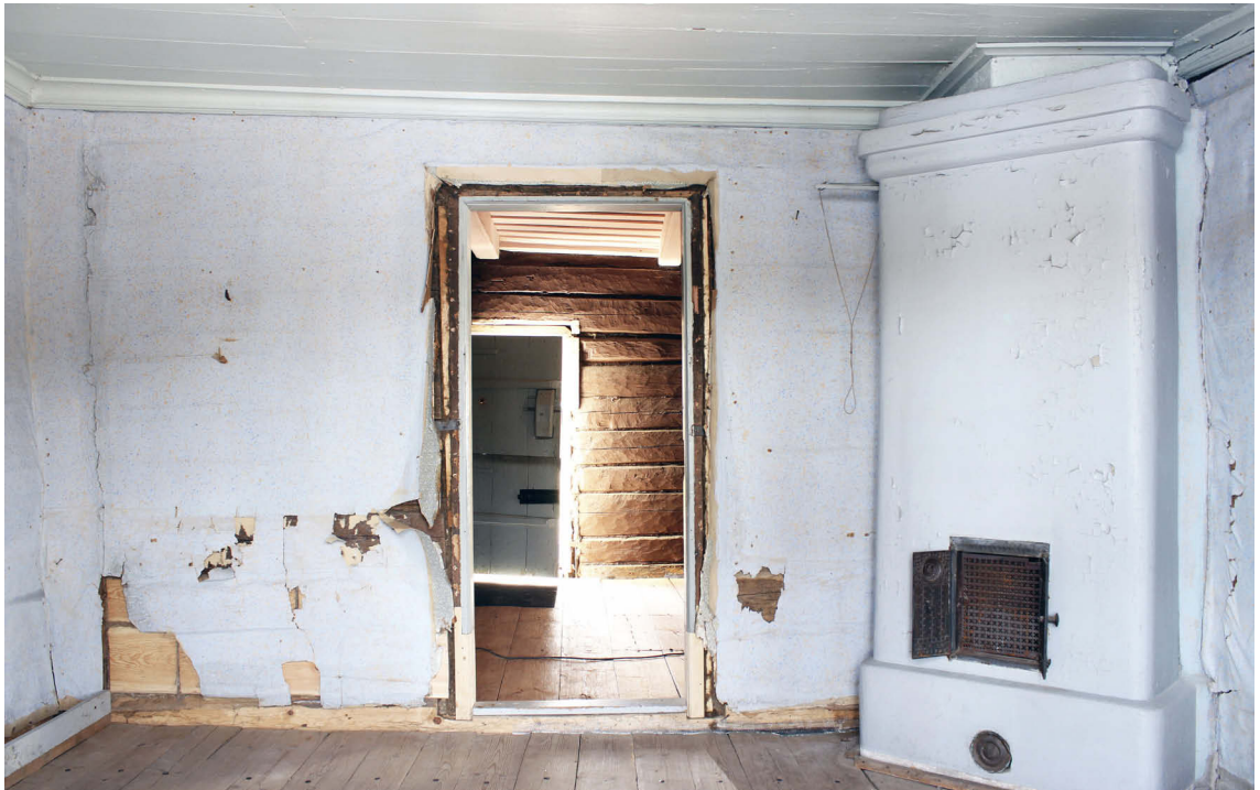
Kuva 46: Itäseinä hirsikorjausten jälkeen, ennen konservointia ja restaurointia.
