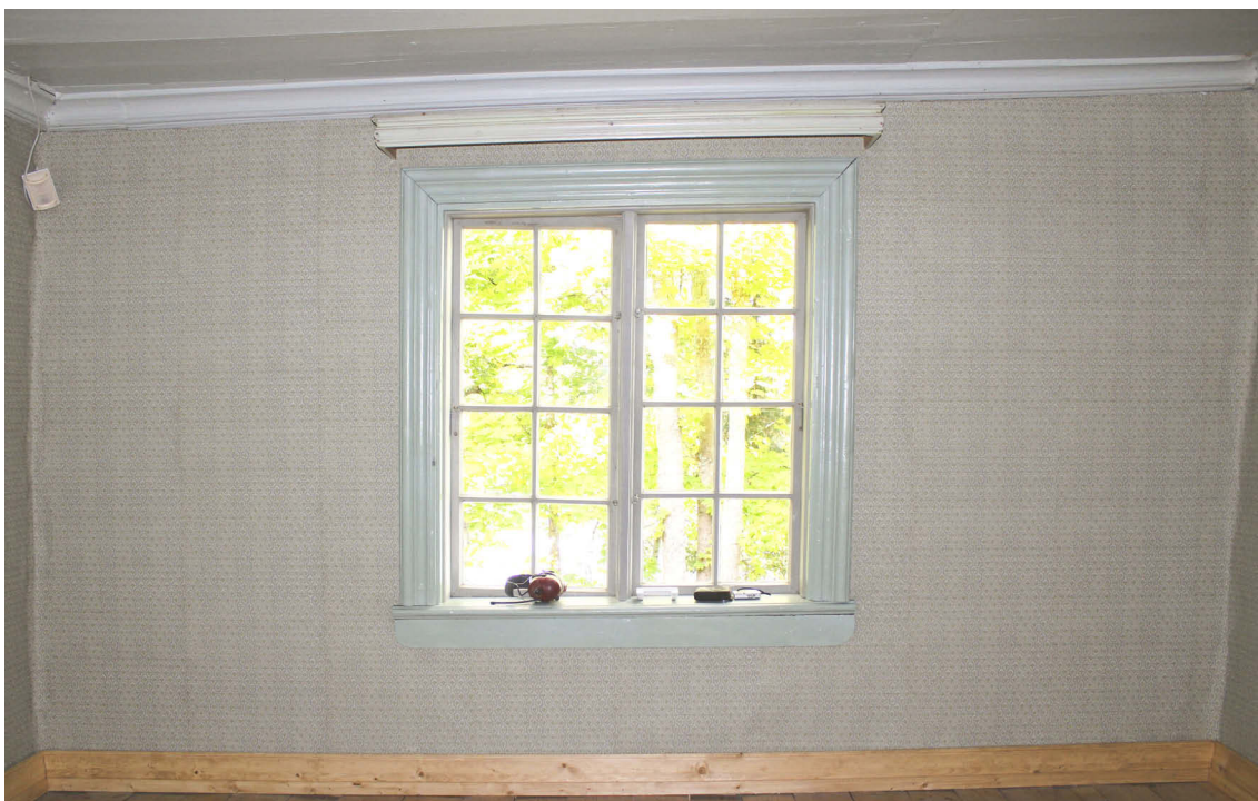
Kuva 51: Länsiseinä konservoinnin ja restauroinnin jälkeen.
