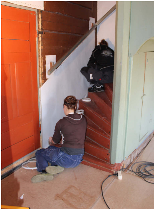
Kuva 10: A-M. Kuitunen ja Katariina Sommarberg pahvittavat eteisen portaikkoa.
