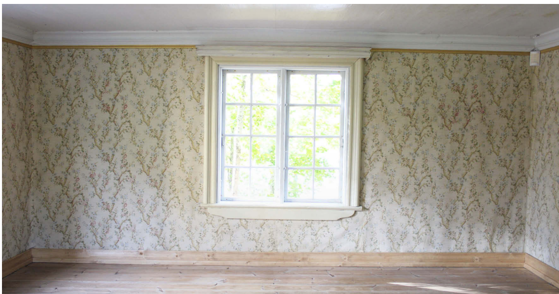
Kuva 59: Länsiseinä konservoinnin ja restauroinnin jälkeen.
