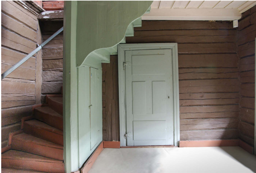
Kuva 32: Pohjoisseinä ennen konservointia ja restaurointia.
