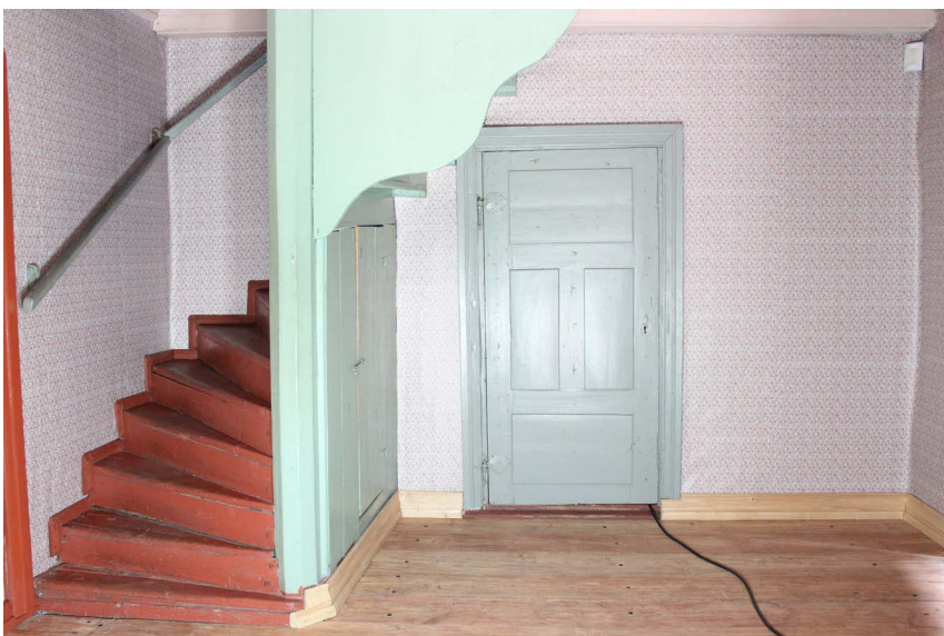
Kuva 34: Pohjoisseinä konservointien ja restaurointien jälkeen.
