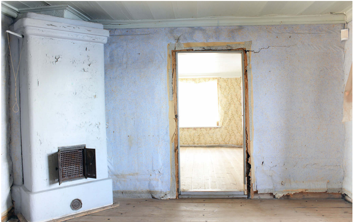
Kuva 48: Eteläseinä hirsikorjausten jälkeen, ennen konservointia ja restaurointia.
