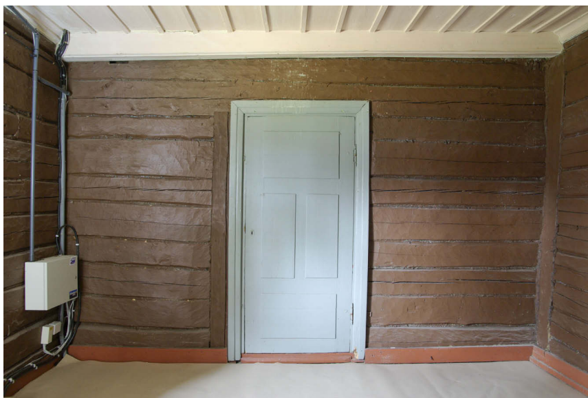
Kuva 38: Eteläseinä ennen konservointia ja restaurointia.
