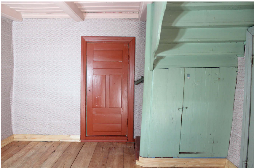
Kuva 43: Länsiseinä konservointien ja restaurointien jälkeen.
