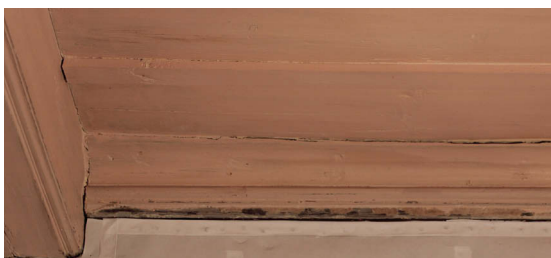
Kuva 4: Maalin irtoamat ennen retusointia.
