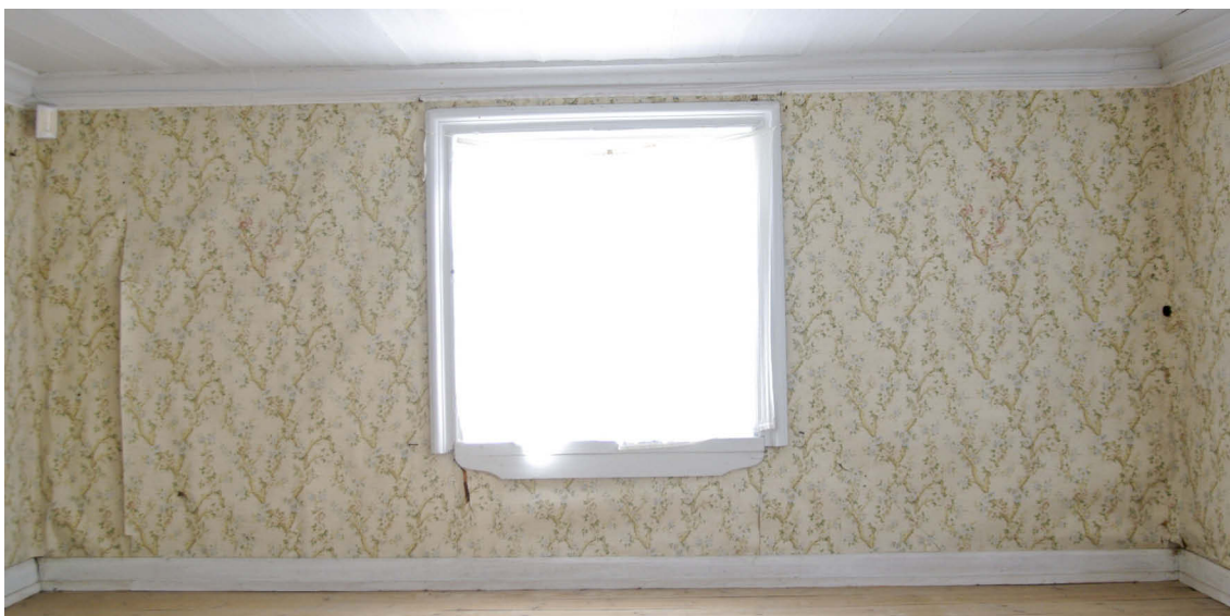
Kuva 54: Itäseinä ennen konservointia ja restaurointia.
