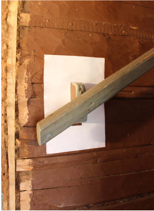
Kuva 8: Kaidepuun pahvitusta vahvistamaan tehtiin palat kaiteen kiinnityskohtiin.
