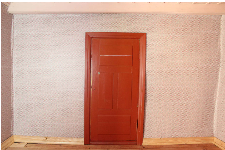
Kuva 40: Eteläseinä konservointien ja restaurointien jälkeen.
