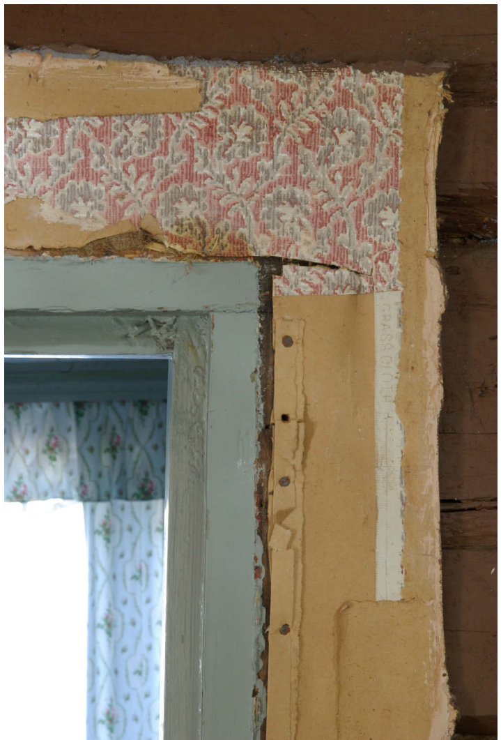
Kuva 2: Listojen alle jääneitä tapettifragmentteja eteisestä.
