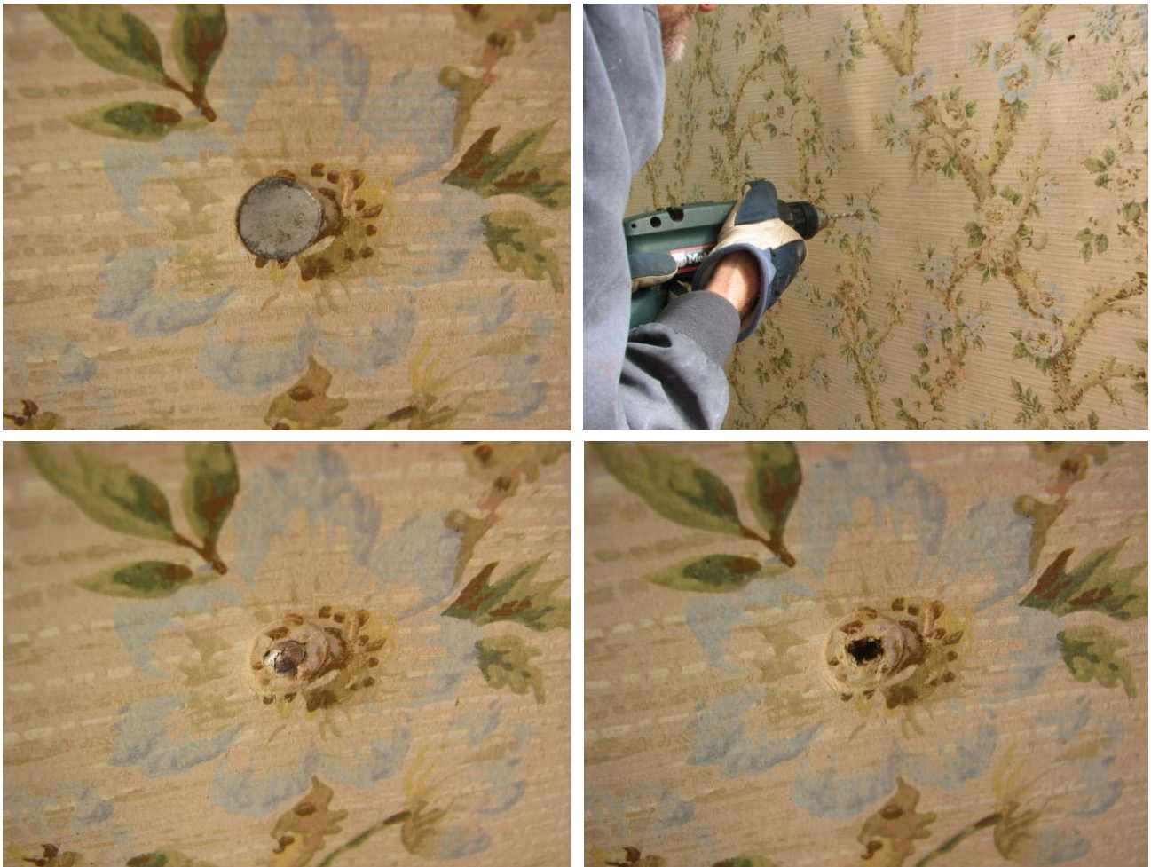
Kuvat 10, 11, 12 ja 13. Huopanaulan kanta porattiin pois ja loppuosaa naulasta lyötiin tuurnalla seinän sisään. (J.Toivio)
