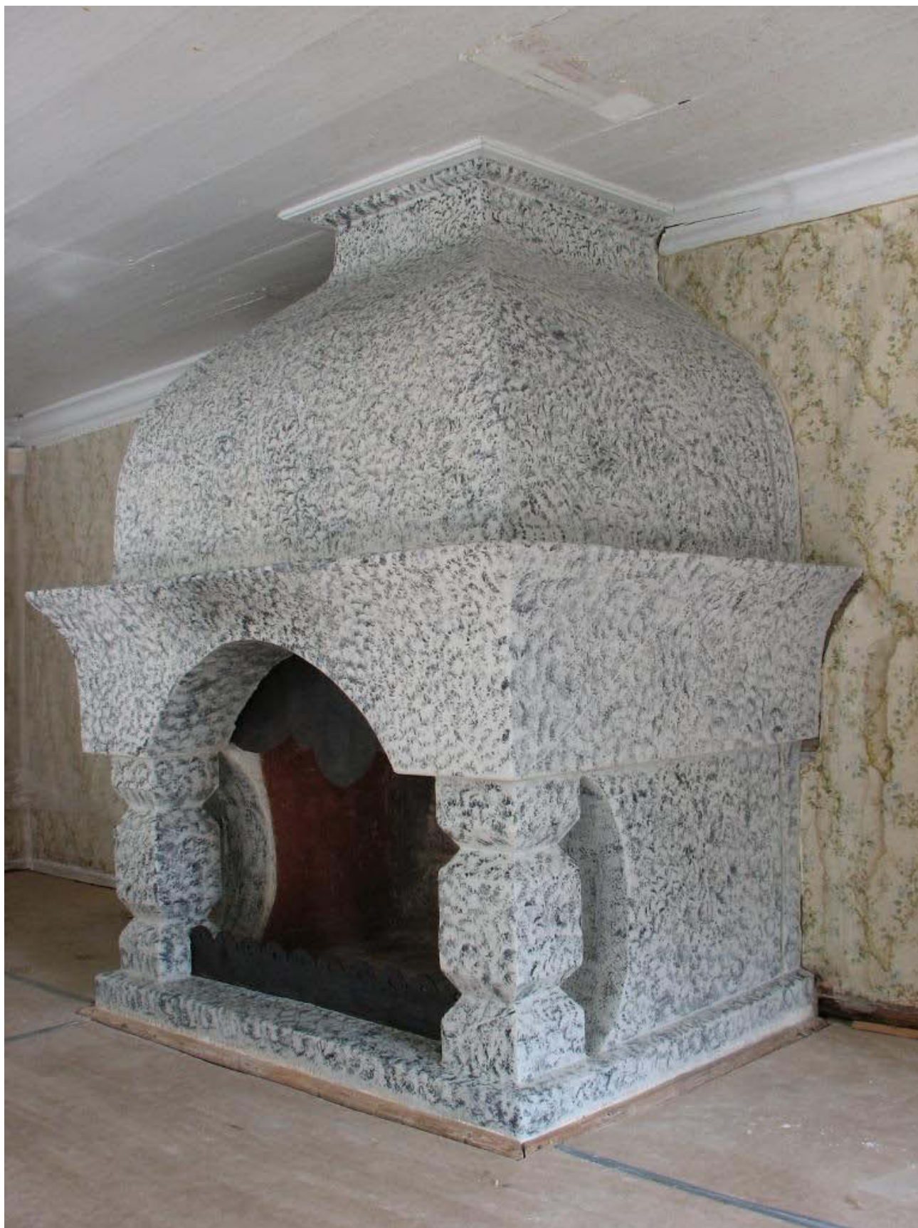
Kuva 43. Urajärven sivurakennuksen salin takka restauroituna. (J.Toivio)
