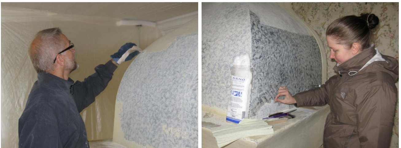
Kuvat 24 ja 25. Takan yläosasta kalkkimaali irtosi helposti. Aluksi testattiin varovasti erilaisia puhdistusmenetelmiä; mm. vanupuikolla ja vedellä, vanupuikolla ja etanolilla. Kun havaittiin, että koristemaalauus kestää hyvin vedellä puhdistusta, jatkettiin pinnan käsittelyä veteen kostutetulla vanulla ja sienellä. Vasemmalla raportin laatija ja oikealla konservaattori Tanja Lindfors. (K.Hoppa)
