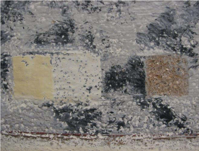
Kuvat 38 ja 39. Väriporras tehtiin takan vasemmalle puolelle huomaamattomaan paikkaan jalustaan. Siitä erottuvat keltainen kalkkimaali pinnassa, sen alla oleva valkoinen kalkkimaali, kivijäljitelmäkoristemaalaus ja alimmaisena rappauspinta. (J.Toivio)
