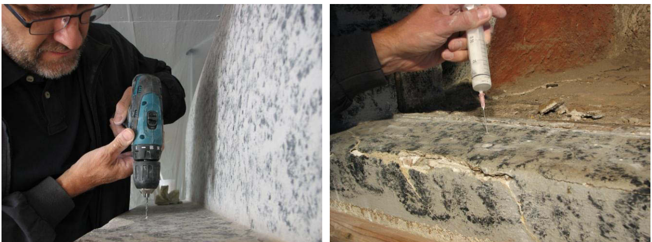
Kuvat 32 ja 33. Kopoihin porattiin reikiä, joiden kautta ohutta laastiliuosta injektoitiin alustan ja rappauksen väliin. (J.Toivio)
