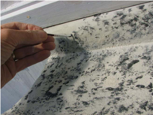
Kuvat 34 ja 35. Takan rapatun ylälistan paikkausten retusointia ja lista valmiina. (J.Toivio)
