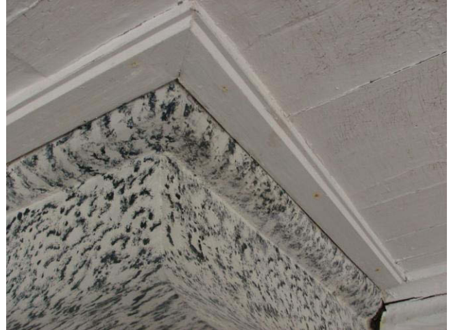
Kuvat 34 ja 35. Takan rapatun ylälistan paikkausten retusointia ja lista valmiina. (J.Toivio)
