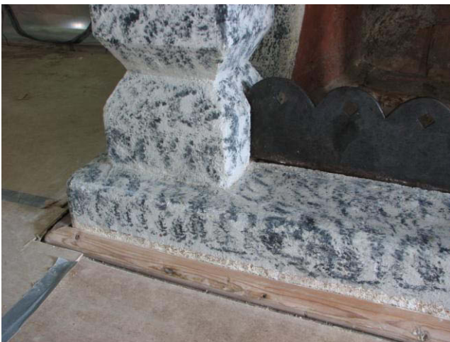
Kuvat 36 ja 37. Takan alareuna paikattuna ja retusoituna. Kipinälevy harjattiin kevyesti teräsharjalla ja sen pintaan levitettiin Can-Trust -ruosteen- ja korroosionsuoja-ainetta. (J.Toivio)
