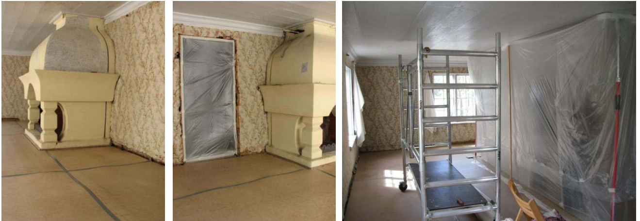
Kuvat 21, 22, ja 23. Lattia suojattiin kovalevyllä, oviaukot muovitettiin ja uunin ympärille rakennettiin muoviteltaa. (21,22 J.Toivio, 23 K.Sommarberg)
