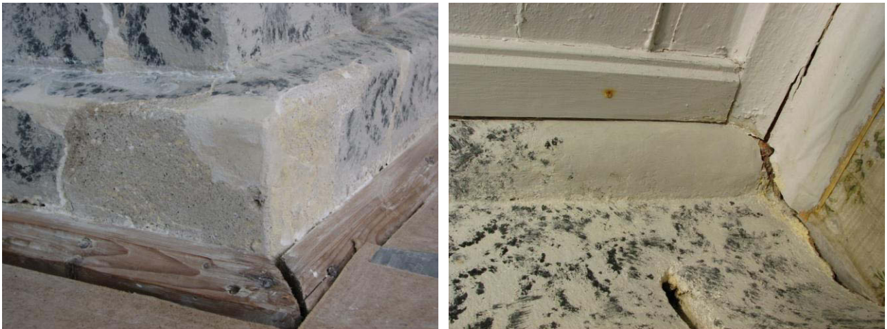
Kuvat 30 ja 31. Takan jalustan oikea etukulma ennen viimeistelytasoitetta ja oikea ylälista valmiina restitoidavaksi. (J.Toivio)
