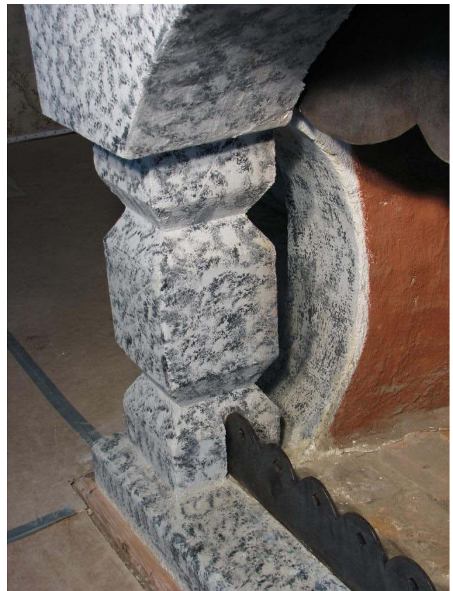
Kuvat 34 ja 35. Takan rapatun ylälistan paikkausten retusointia ja lista valmiina. (J.Toivio)
