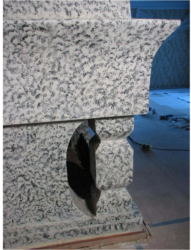
Kuvat 38 ja 39. Väriporras tehtiin takan vasemmalle puolelle huomaamattomaan paikkaan jalustaan. Siitä erottuvat keltainen kalkkimaali pinnassa, sen alla oleva valkoinen kalkkimaali, kivijäljitelmäkoristemaalaus ja alimmaisena rappauspinta. (J.Toivio)
