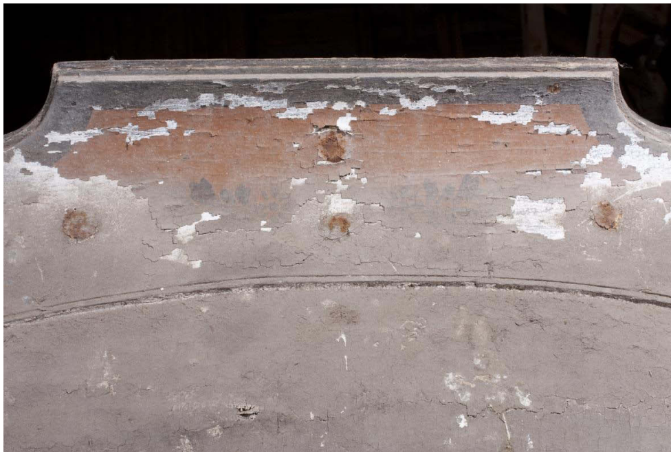
KUVA 24. Etupään koristemaalausta saatiin esiin paksun pölykerroksen alta.
