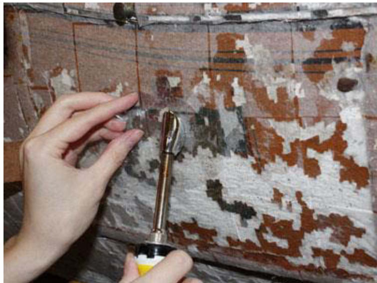
KUVA 29. Pintaa käsitellään lämpölusikalla.
