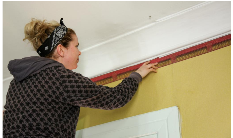
Kopioboordi kiinnitettiin välikamarissa kolmelle seinälle
