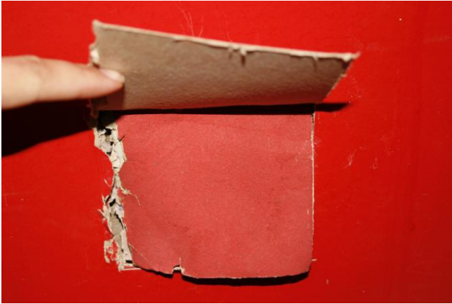
Salin seinässä oleva ikkuna alempiin tapettikerroksiin Kuvassa näkyy alkuperäisen punaisen tapetin ja uuden maalikerroksen sävyero. kuva: Emilia Bergholm
