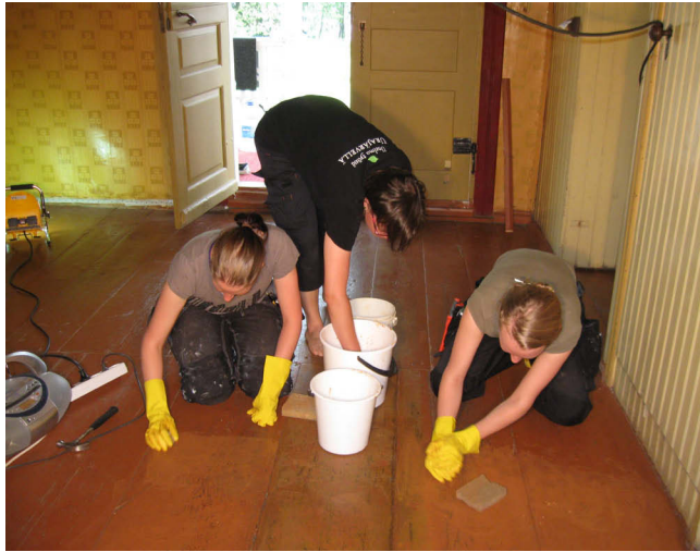
Lattian maalipinta käsiteltiin hohkakivellä ja kidesoodalla ennen uudelleen maalausta.
