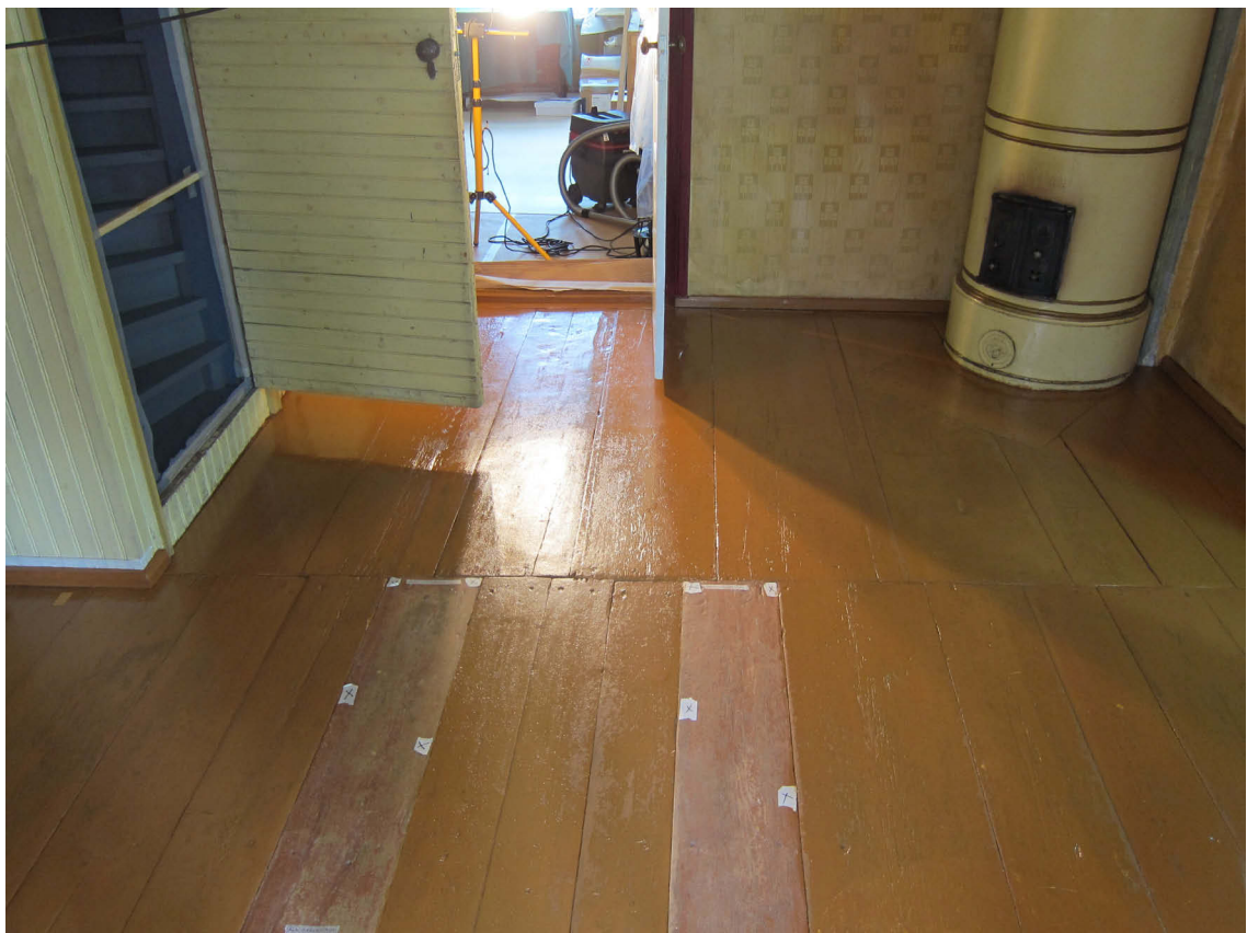
Lattia ensimmäisen maalikerroksen jälkeen. Maalamattomat lankut toimivat kulkureittinä.
