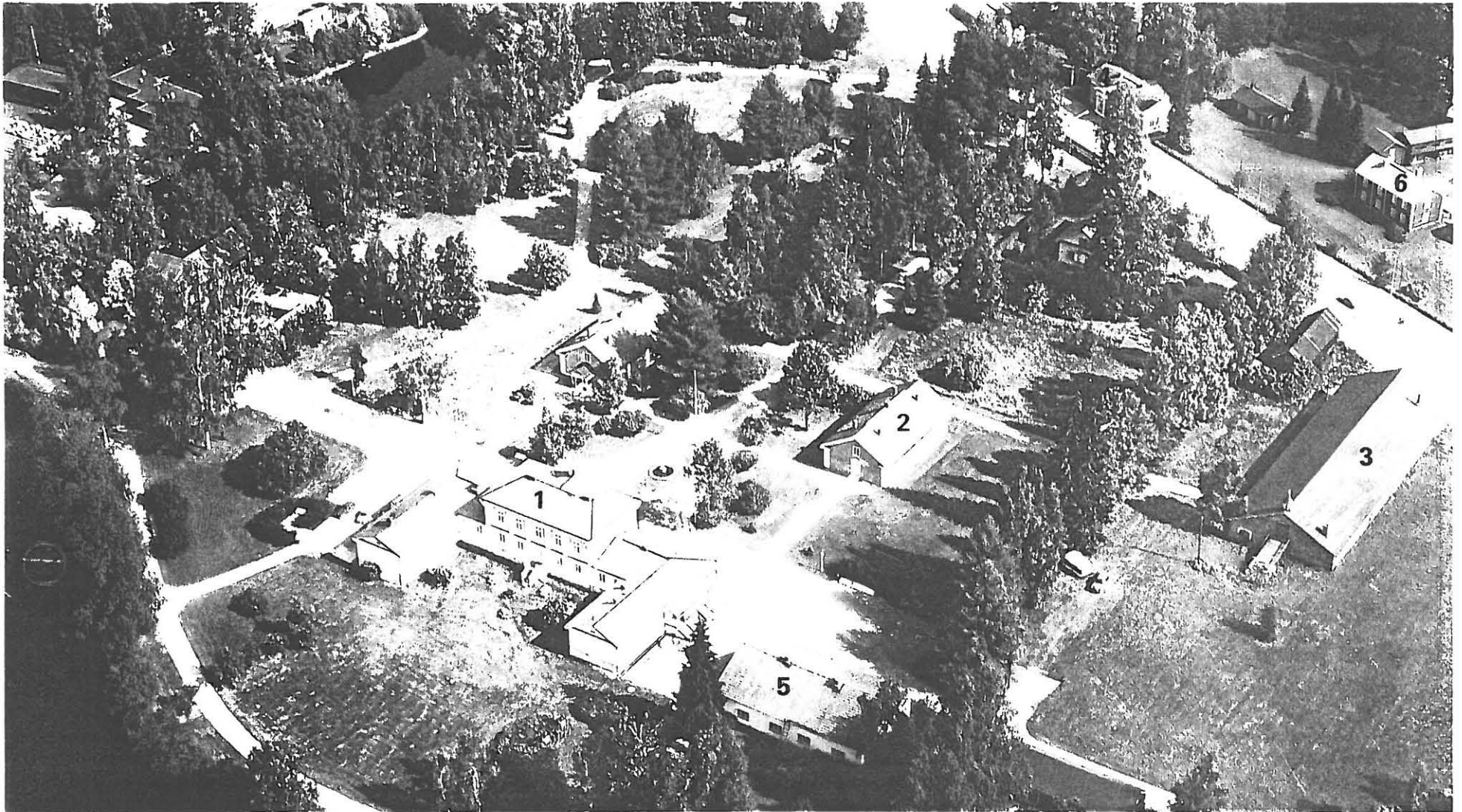
1. Kartanon päärakennus/kaupungin juhlahuoneisto, 2. Palkollisten asunnot/Apteekkimuseo ym., 3. Kivinavetta/Maatalousmuseo, 4. Ruutilaboratorio/Ruutimuseo, 5. Meijeri/Museokäytössä, 6. Talonpoikaismuseoalue, 8. Ruutivarasto/Rakennettu kirkoksi 1864.
