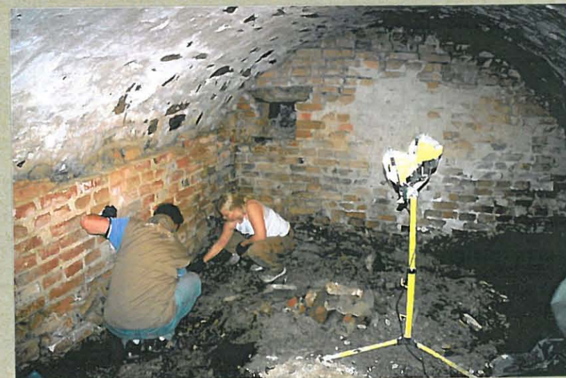
4. Tiilirevetointi - säilytetäänkö vai poistetaan?
