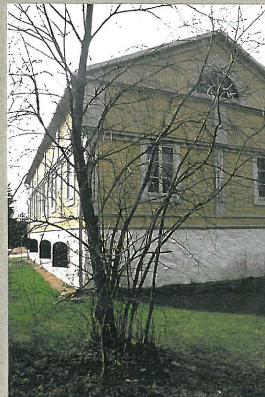
Tuomi poistetaan arvorakennuksen kivistä.
