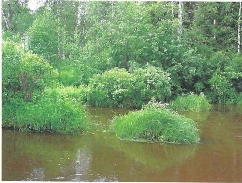
Kuva 15. Muhos; vanhat silta-arkut Muhosjoessa
