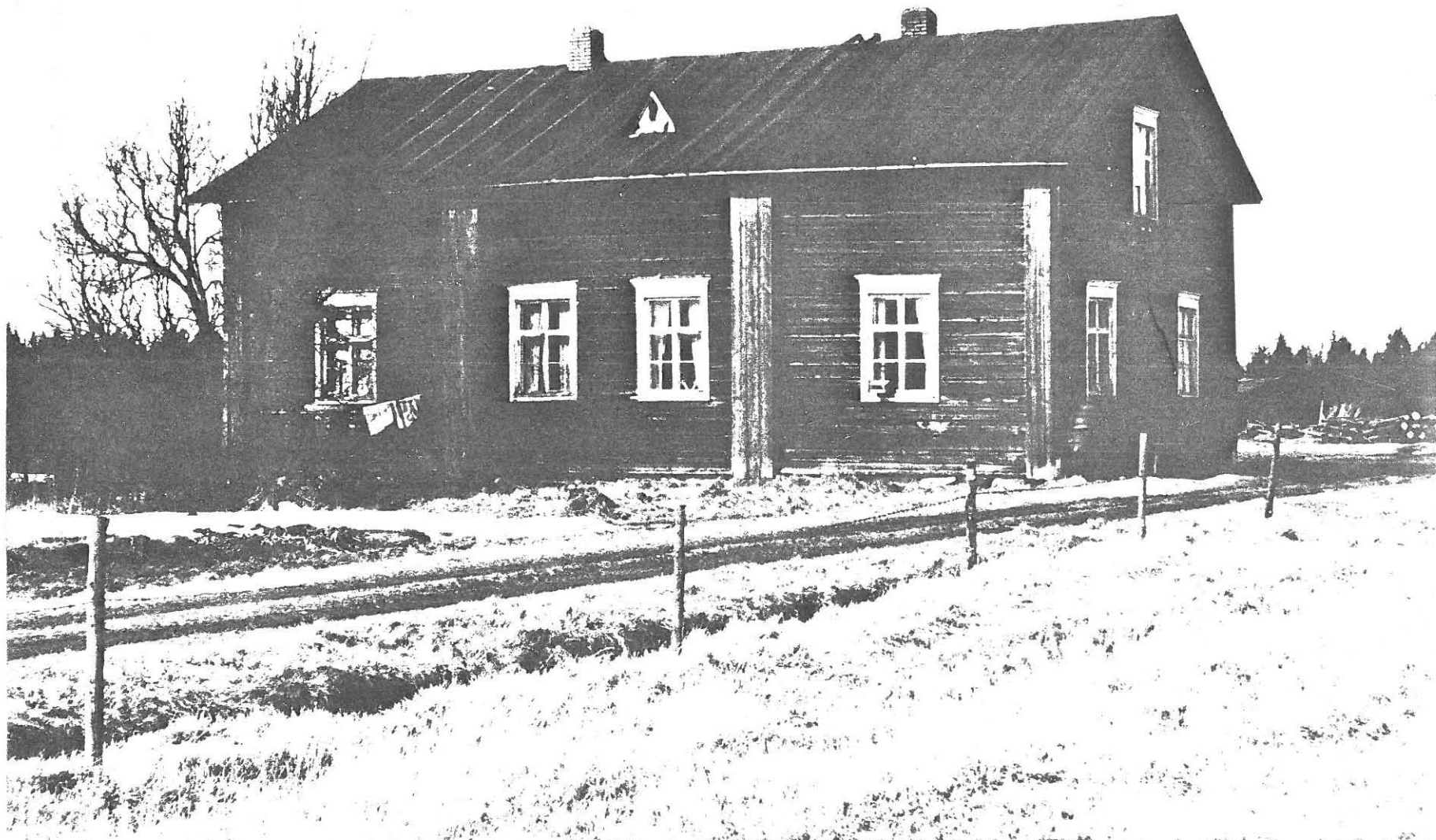
Kuva 36. Vuosisadan kuluessa pappiloiden koko kasvoi vähitellen, vaikka huoneluokan ja -järjestys pysyikin samana. Tämä rakennus valmistui v. 1777 Piippolan pikkutuvassa (kuva 5) asuneelle papille. Nykyään maatalona oleva rakennus on edelleenkin vuoraamaton, vain nurkat on suojeltu pysty-laudoituksella, joka on maalattu vanhaan tapaan seinän punaisella värillä.
