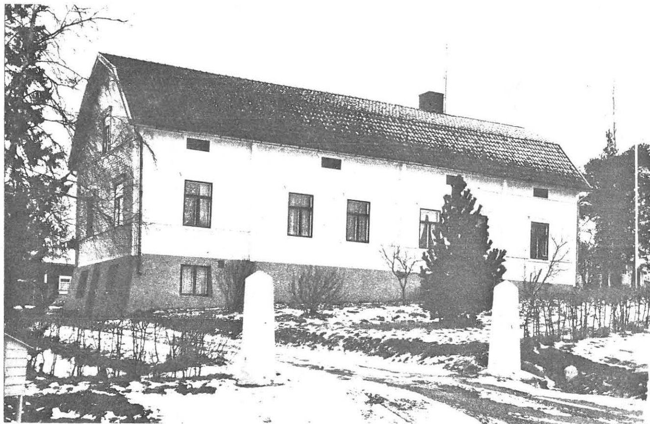
Kuva 26. Teerijärven pappila, rakennettu v. 1800-1806 välillä. Poikkeuksellinen räystäsikkunoin varustettu taitekatto. Perimätiedon mukaan seurakunnan ensimmäinen kappalainen pastori Fontell toi rakennuksen piirustukset mukanaan Ruotsista. Pohjakaavana on huoneparilla jatkettu viisihuonejärjestelmä. Kuvassa näkyvän puutarhajulkisivun takana vasemmalta lukien piispankamari, sali, ruokasali ja makuukamari, vastaavat tilat pihan puolella ovat kanslia, eteinen, keittiö ja lastenkamari. Rakennus oli aluksi katettu punaisiksi maalatuilla laudoilla. Julkisivu muutettu v. 1890.
