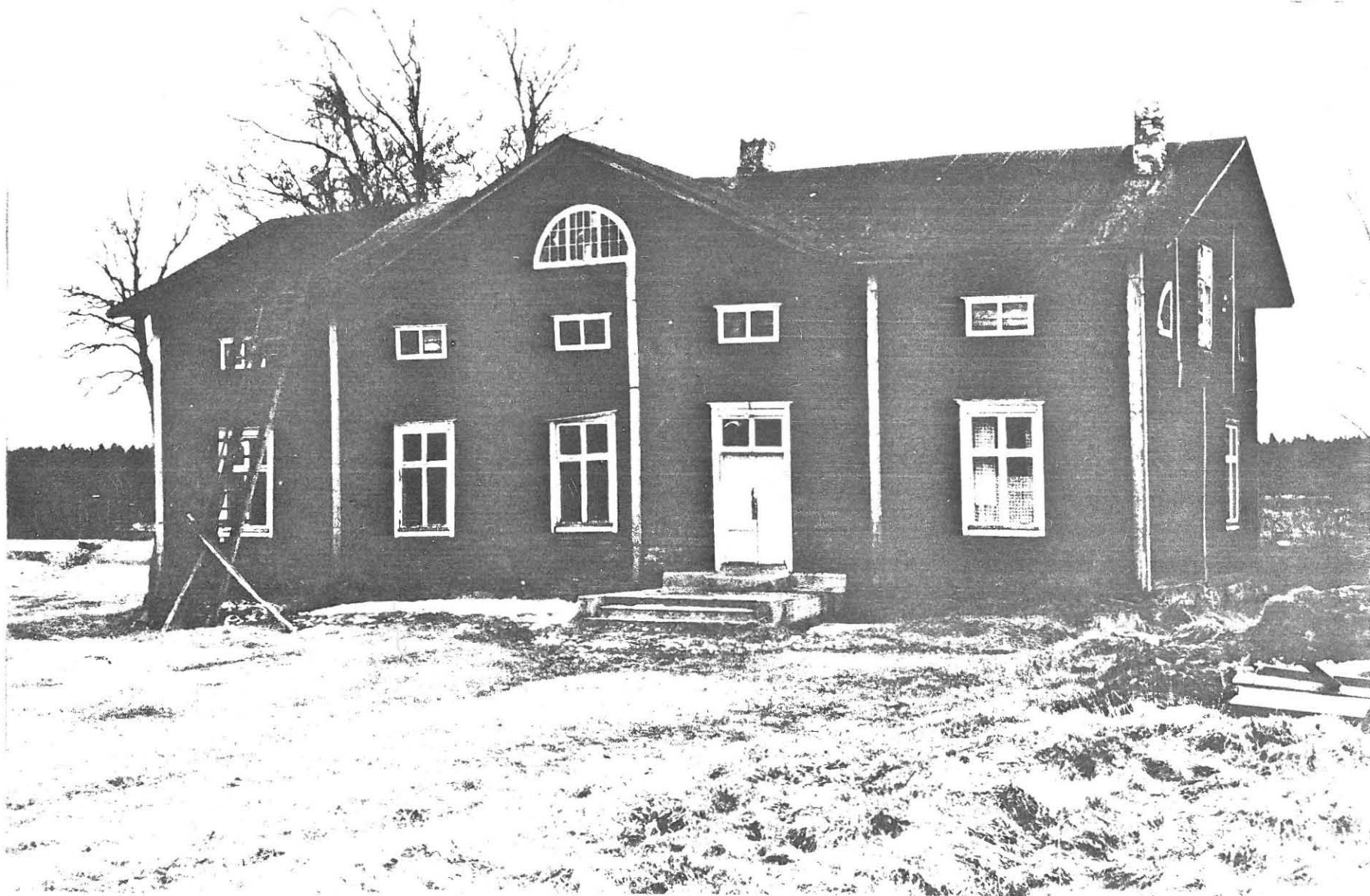
Kuva 62. Sievin vanha pappila, v. 1833. Kulissimainen edustusfasadi, julkisivuaiheiden epäfunktionaalinen käyttö. Frontonin kaari-ikkuna ja räystääslasi sijaitsevat ullakon huonetilaa ajatellen nurinkurisesti, mutta räystääslasin ruutujen takana onkin hirsiseinä. Keskeinen frontoni-aihe vaatisi myös pääoven siirtämistä symmetria-akseliin. Vanhanmallinen pohja ja uudenaikainen julkisivu ovat näkyvässä ristiriidassa.
