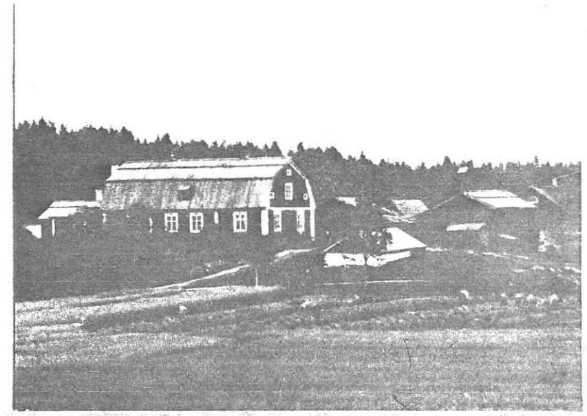
Kuva 25. Iitin pappila. Komea kolmijaksoinen laudoin katettu mansardikatto. Pohjaratkaisu luultavimmin viisihuoneinen.
