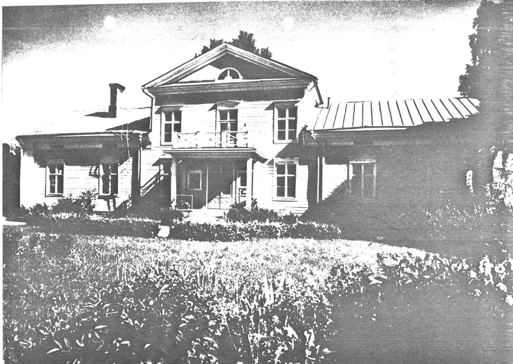
Kuva 56. Vöyri, v. 1825, mahdollisesti Engelin käsialaa. Pohjanmaan suurissa empirepappiloissa oli yleensä ahlakaton sijasta perinteellinen satulakatto (esim. Lapua, Isokyrö). Frontespiisiathe alkoi vasta empireaikana kotiutua ja tulla suosituksi pappiloissa, se saatiin lähinnä kartanoista arkkitehtien kautta.
