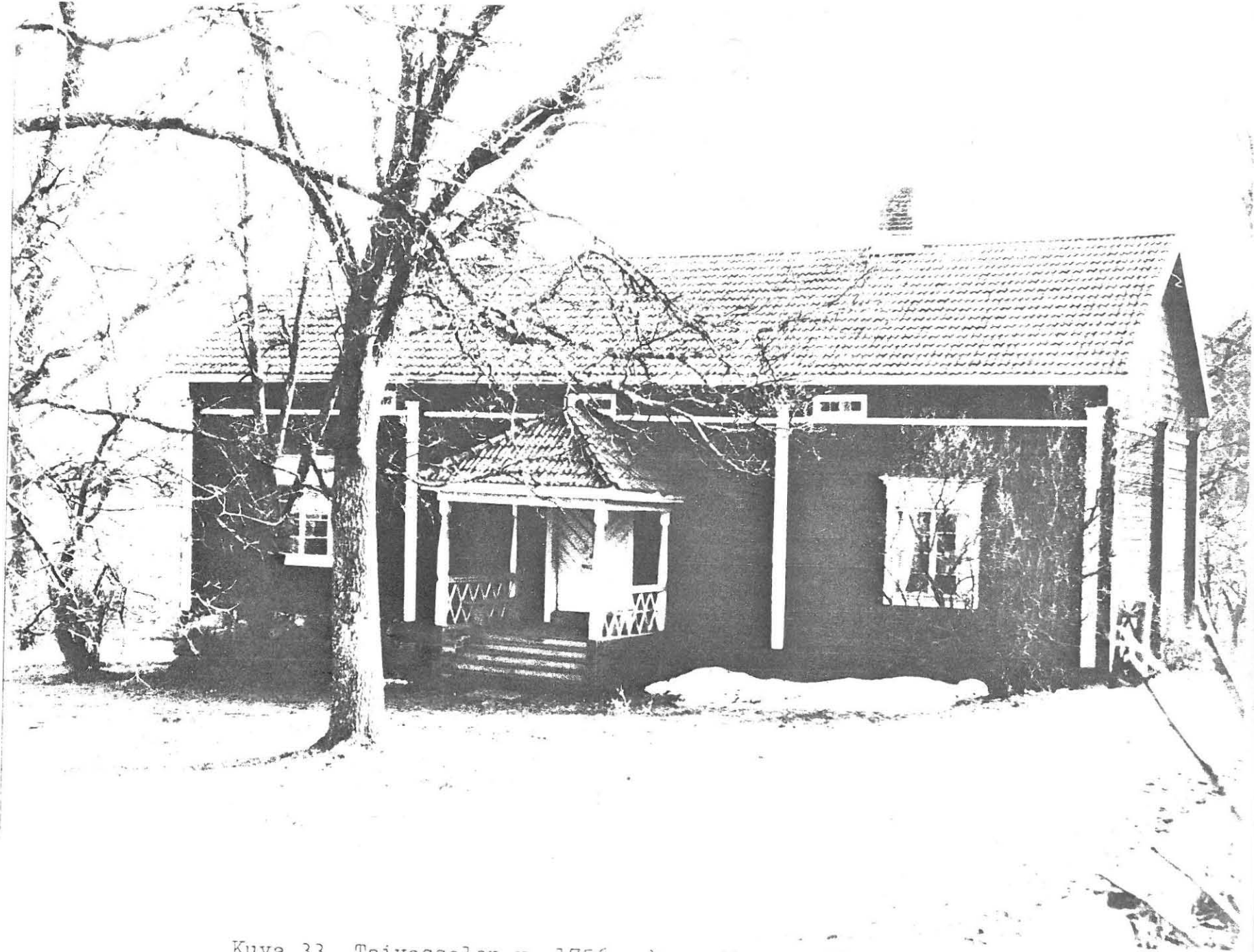
Kuva 33. Taivassalon v. 1756 rakennettu pappila. Hirrenpäiden lautasuojauksesta muodostuu helposti julkisivua jäsentävä pilasteriaihe.
