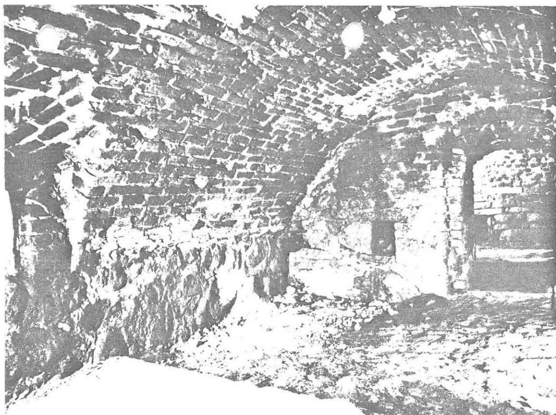
Kuva 2. Taivassalon pappilan kaksiosainen holvikellari on tiilikoosta päätellen muurattu kirkon muutostöiden aikana 1400-luvun loppupuolella. Holvattu kivikellari todistaa tavalliset talonpoikaistalot ylittävästä varakkuudesta. Puolivirallisina kestikievereina toimiville pappiloille olikin hyvä kellari oluen säilytyksen kannalta välttämätön.
