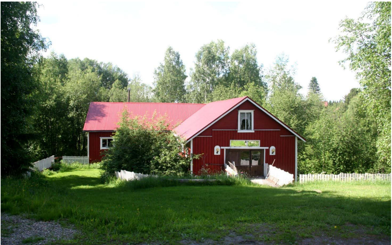
Kuva 11. Vauhdinkosken mylly. Kuva kaakosta. 6.6.2013.
