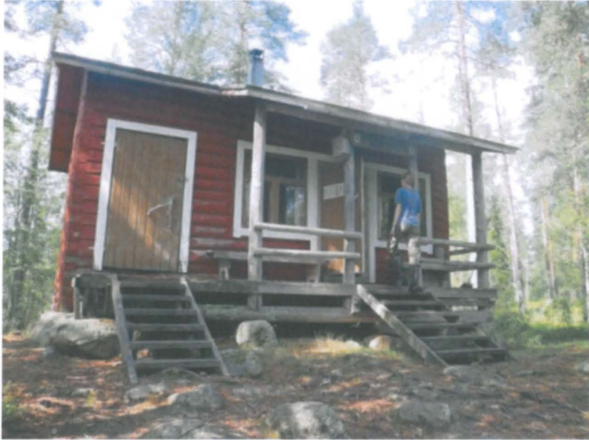
Kuva 46. Kivijärven autiotupa, kuvattu eteläkaakosta
