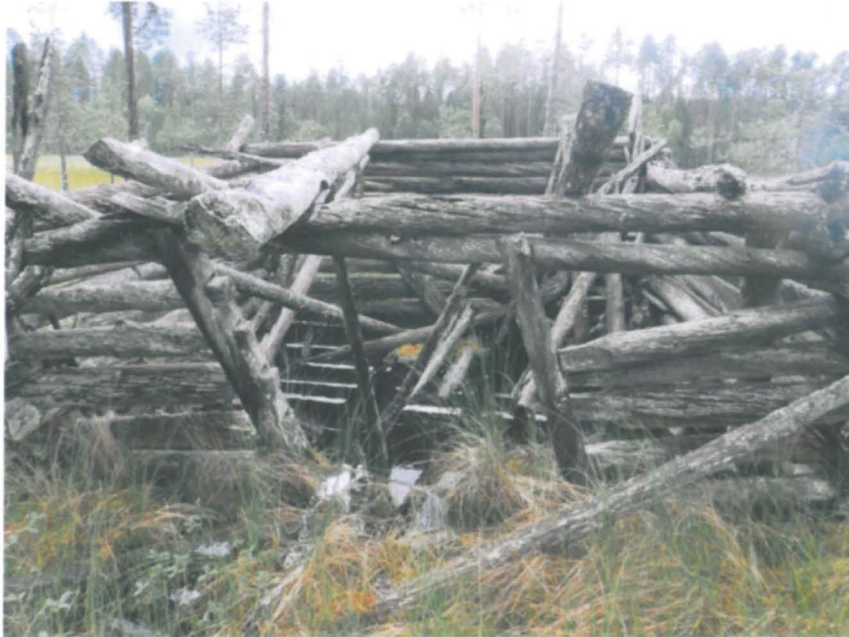
Kuva 72. Ladon jäänteet, kuvattu pohjoisesta.
