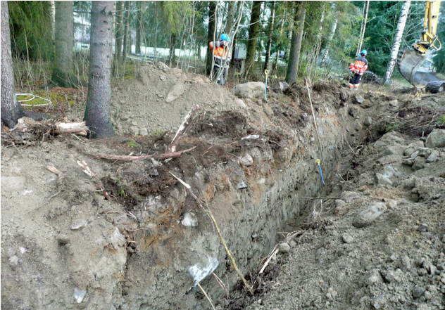
Kuva 3. Ehjiä maakerroksia oli säilynyt tutkitun linjauksen eteläpäässä. Kuva lännestä.
