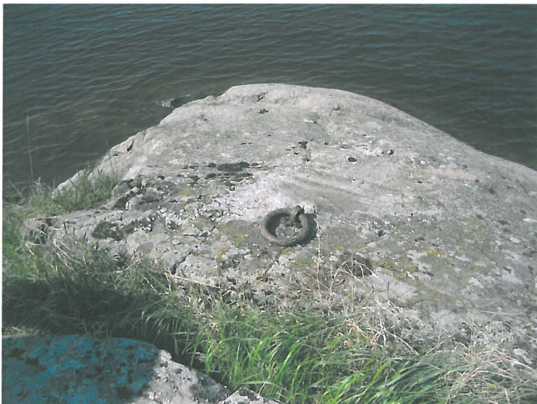
Kallioon kiinnitetty uittopuomin rengas
