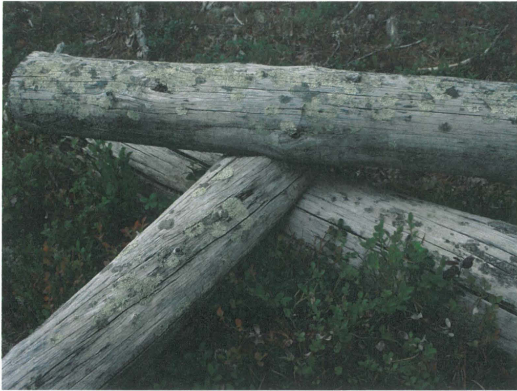
Kuva 5. Kuikkalampi 2. Kehikossa on yksi hirsikerta, joka on tuettu kulmista metrin mittaisilla aluspuilla.
