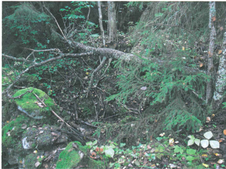
Kuva 4. Kalkkiuunin sisäosa. Uunin sisäosa on täytynyt romahtaneilla rakenteilla, jätteillä sekä tuulenskaadoilla. Kuvattu koilliseen.
