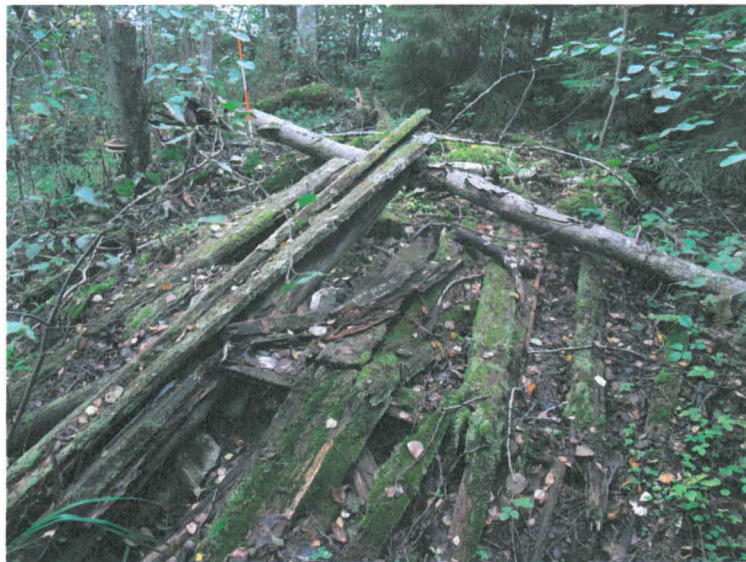
Kuva 3. Romahtaneen kalkin tuotantoprosessiin liittyneen rakennuksen jäännökset noin kymmenen metriä kalkkiuunista länteen. Kuvattu länteen.
