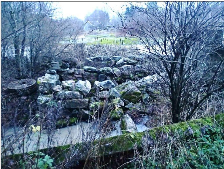
Mylly- tai saharakennukseen liittyviä kivirakenteita. Kuvattu etelään.
