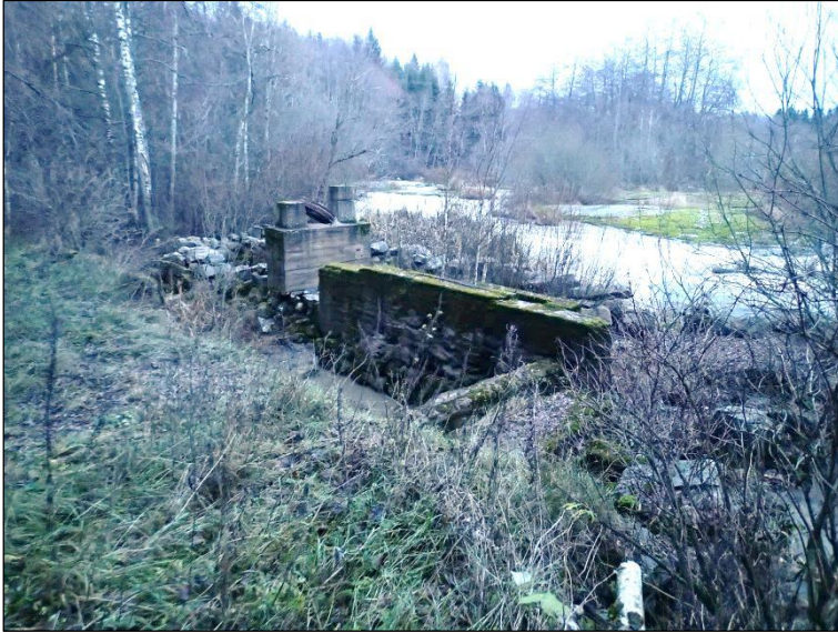
Rakennusjäänöksiä Kosken kartanon sahan paikalla. Ainakin betonirakenteet liittynevät viimeiseen paikalla olleeseen myllyyn. Kuvattu kaakkoon
