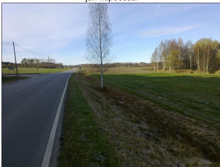
Vesihuoltolinja tien varressa Oikolanjoen varressa Oikolanmäen tasalla. Luoteeseen.
