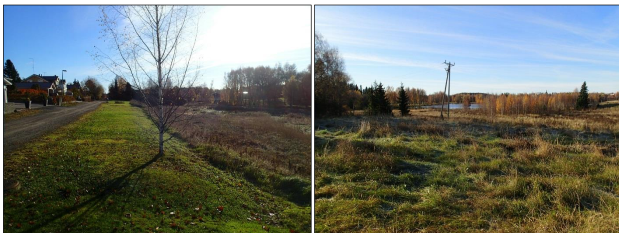
Vesihuoltolinja vesijätöllä Nahkialanjoen varressa (vas) ja taustalla vesijätöllä Nahkialanjärven rannalla (oik)
