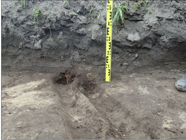
Rakenne BR3 pohjaan kaivettuna ja leikkauksessa. Koillisesta.
