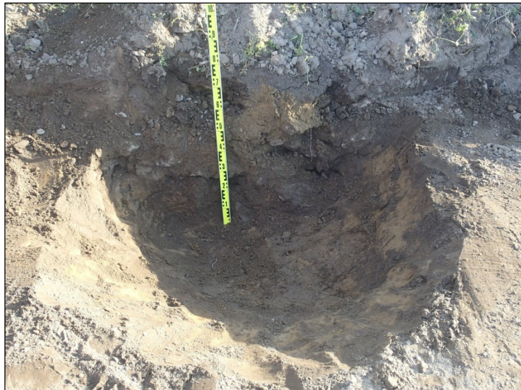
Rakenne AR4 muotoon kuopalle kaivettuna.
