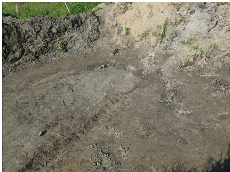
Rakennus BR2 purettuna ja kaivettuna pohjaan.
