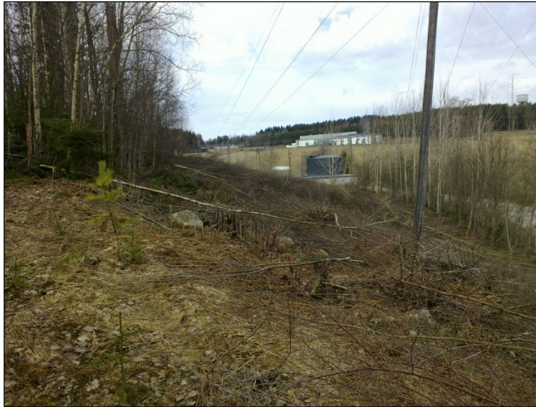
Länteen, pohjoiseen viettävän rinteet alaosaa. Taustalla lämpökeskuksen rakennuksia.
