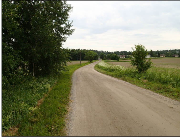
Vaasankatu kuvattuna etelään.
