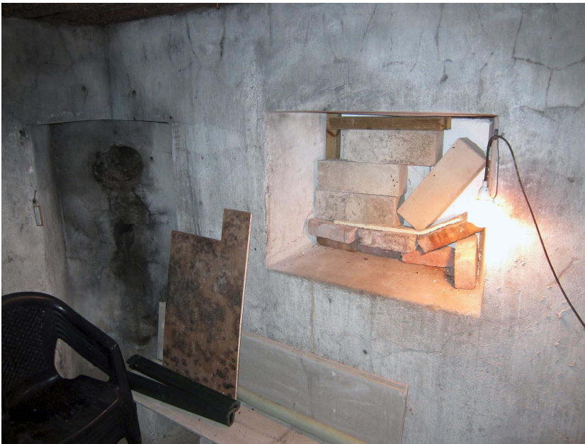
Kuva 20. Itäisen huonetilan eteläseinä. Keskellä on tukittu ikkuna-aukko ja nurkassa kaminan paikka. Kuvaussuunta SE. 10.10.2012.
