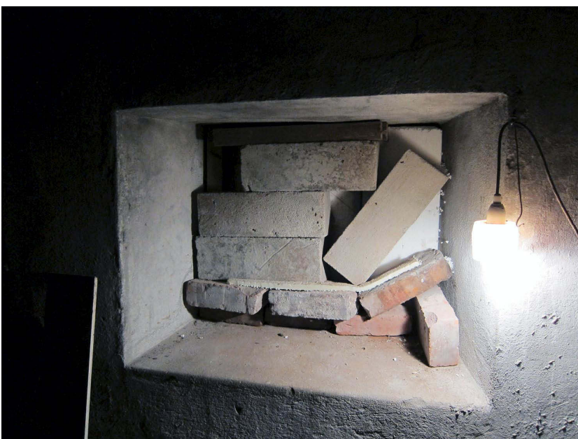
Kuva 31. Eteläseinän tukittu ikkuna-aukko. Kuvaussuunta SE. 10.10.2012.
