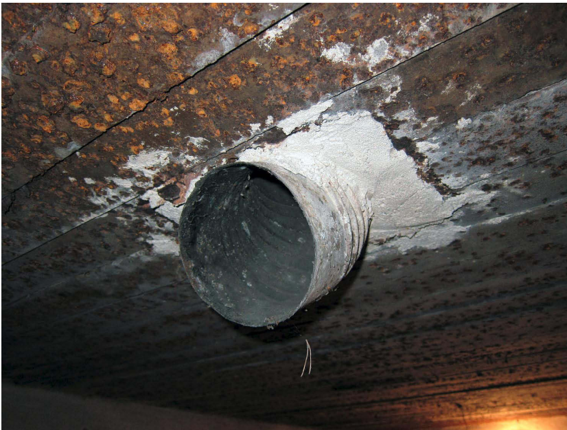
Kuva 14. Läntisen huonetilan pohjoisosan katossa oli ilmastointiputki. Kuvaussuunta SE. 4.10.2012.
