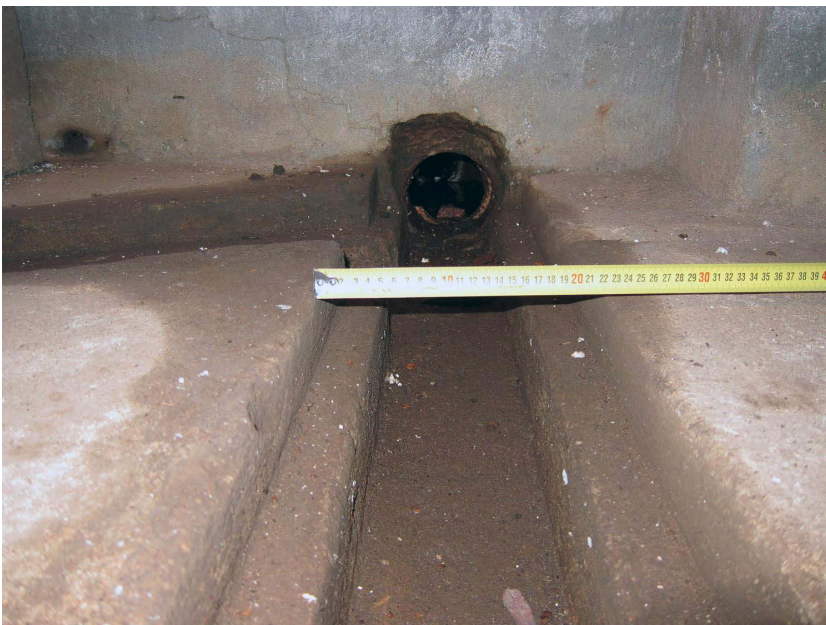
Kuva 36. Kouru itäisen huonetilan lounaisnurkassa. Taaempänä näkyy eteläseinän läpi johtava aukko ja sen päässä oleva rengas, joka on mahdollisesti metalliputken jäännökset. Kuvaussuunta SSE. 10.10.2012.
