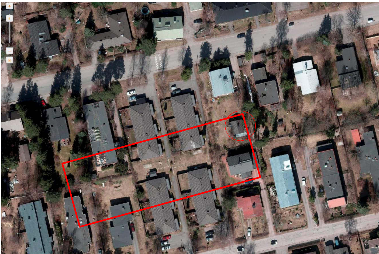
Ilmakuva tykkipatteri (suunnikas) sijainnista Sirkku Laineen inventointiraportin mukaan ja suoja-alueen kartoitusalueesta (ympyrä) vuonna 2010. Kuva: Helsingin kaupunki.
