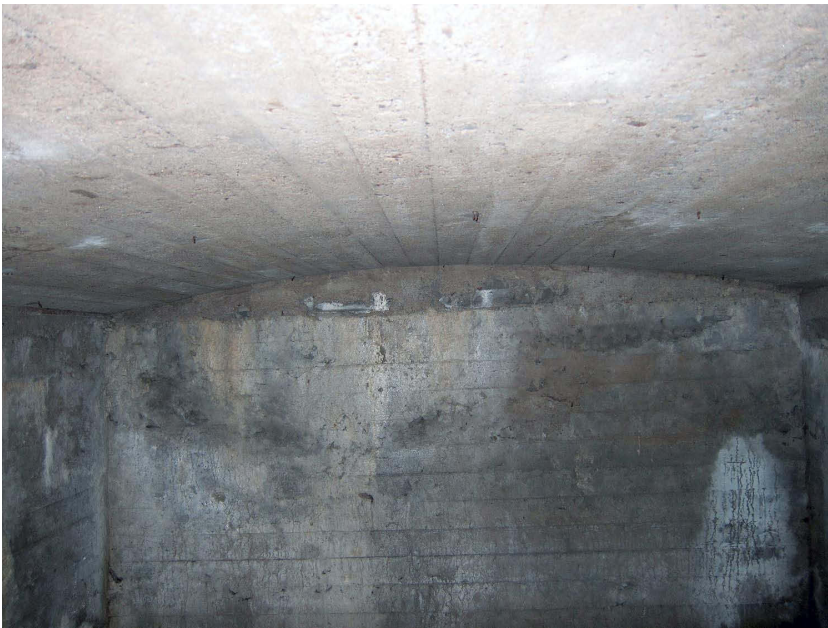
Kuva 32. Suojahuone 2:n loivasti kaareva katto. Kuvaussuunta NNW. 5.6.2012.
