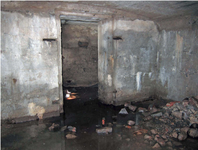
Kuva 29. Taistelu- /yhdyshaudasta johti oviaukko pohjoispuolella sijaitsevaan yksihuoneiseen suojahuone 2:een. Tilassa oli betoniset katto ja lattia. Katto oli erilaista betonia kuin seinät. Kuvaussuunta SSW. 5.6.2012.
