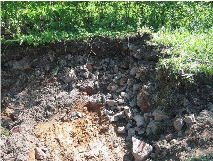
Kuva 21. Edellinen kohdan länsiosa, jossa oli runsaasti pientä louhintakiveä. Kuvaussuunta SSE. 5.6.2012.
