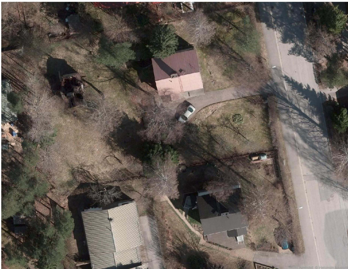
Ilmakuva tarkastusalueesta vuonna 2010. Oikealla alhaalla on Juoksuhaudante 6b ja yläosassa Juoksuhaudantie 8, jonka kohdalle rakennettiin uudet rakennukset. Kuva Helsingin kaupunki.
