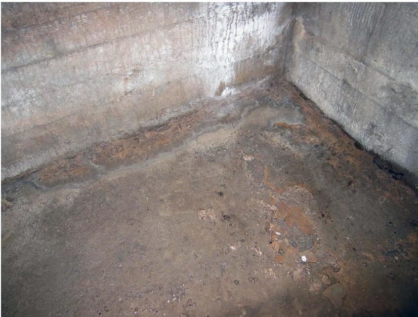
Kuva 34. Lähikuva suojahuone 2:n koilliskulmasta ja lattiasta. Kuvaussuunta NE. 5.6.2012.
