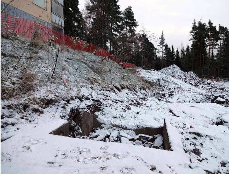
Kuva 21. Suojahuone osittain esiin kaivettuna. Se oli täytetty louhoskivellä. Kuvaussuunta E. 26.10.2012.
