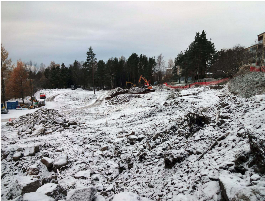
Kuva 12. Kunnostustyömaan keski- ja itäosat työmaan edistyttyä lokakuussa 2012. Kuvaussuunta W. 26.10.2012.
