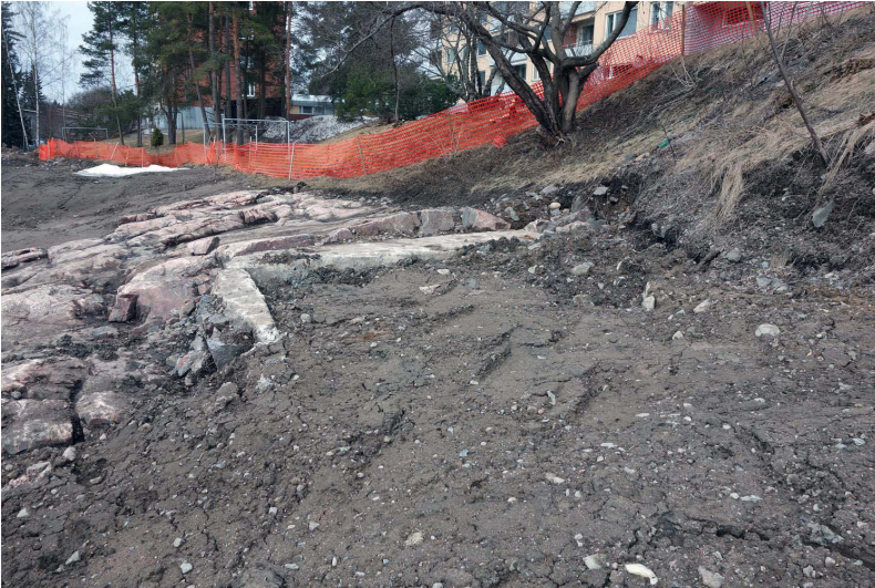
Kuva 24. Edellinen tilanne. Suojahuone jätettiin esille lopullisessakin vaiheessa kuvan esittelemällä tavalla. Kuvaussuunta W. 18.4.2013.
