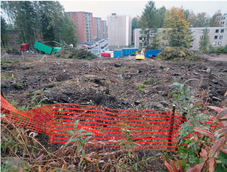
Kuva 6. Kunnostustyömaan keskiosa. Taustalla on Teuvo Pakkalantie. Kuvan vasemmassa reunassa verkkoaidan kohdalla on ensimmäisen maailmansodan aikainen luola. Kuvaussuunta S. 19.9.2012.
