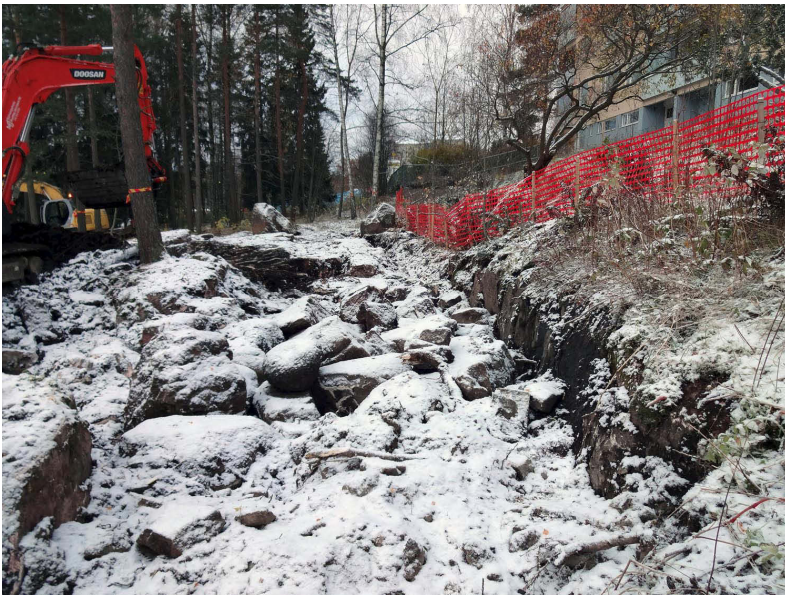
Kuva 15. Kunnostusalueen luoteiskulman kallioaluetta. Kohdalla on sijainnut Haagan ampumaradan ilmeisesti ammunnan näyttöalue. Kohdassa ei ollut rakenteita, mutta edessä kalliota on louhittu ja syntynyt syväne täytetty louhintakivillä. Kuvaussuunta W. 26.10.2012.
