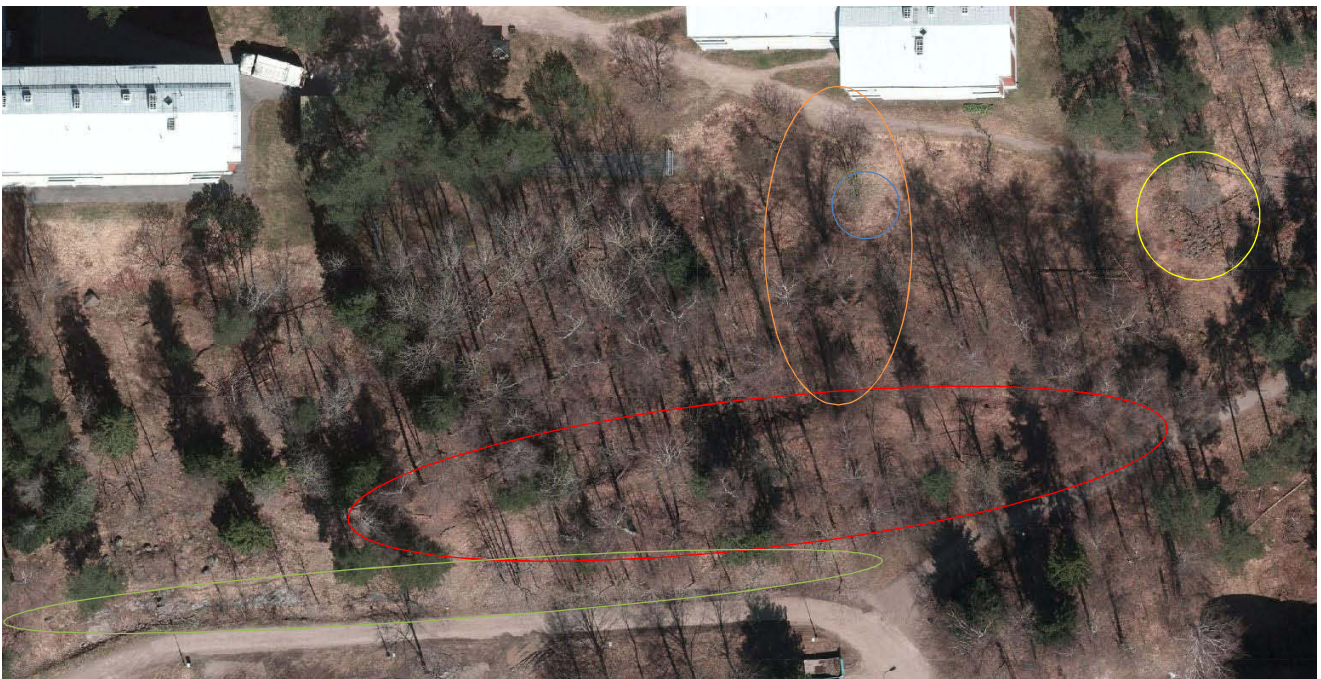
Ilmakuva alueesta vuonna 2010 ennen kunnostustöitä. Ampumaradan takavalli näkyi kaarevana kohoutumana maastossa. Vallin eteläpuolella sen ja tien välissä on ammunnan näyttöalueen kohdalla kallio- ja maaleikkaus . Suojahuone on maapeitteiden alina näkymättömissä luolan yläpuolella. Tulipesäke näkyy louhintakivien kasautumana kuvan oikeassa ylänurkassa. Kuva: Helsingin kaupunki.
