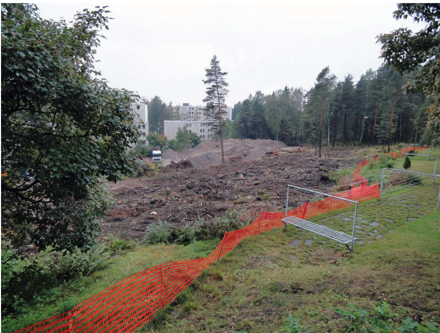
Kuva 7. Kunnostustyömaan keski- ja länsiosa luolan länsipuolella. Kuvaussuunta WSW. 19.9.2012.
