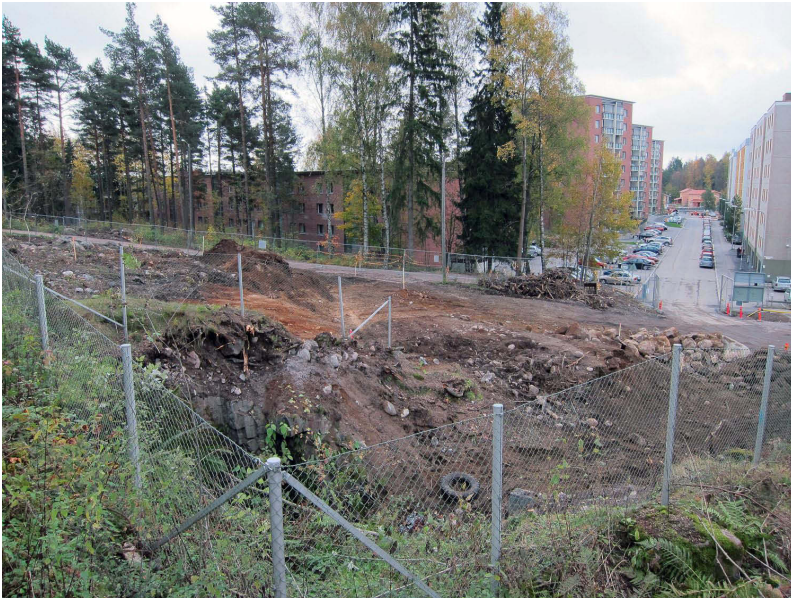
Kuva 27. Luola ja sen takana maamassojen alta paljastanut luolaan johtaneen tykkitien lyhyt jäännös. Kuvaussuunta SE. 4.10.2012.
