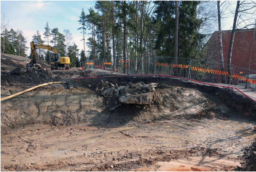
Kuva 45. Alueen eteläreunalla Teuvo Pakkalantien päässä tuli esiin vanhan ampuradan näyttöalueen betonirakenteita. Kuvaussuunta E. 18.4.2014.
