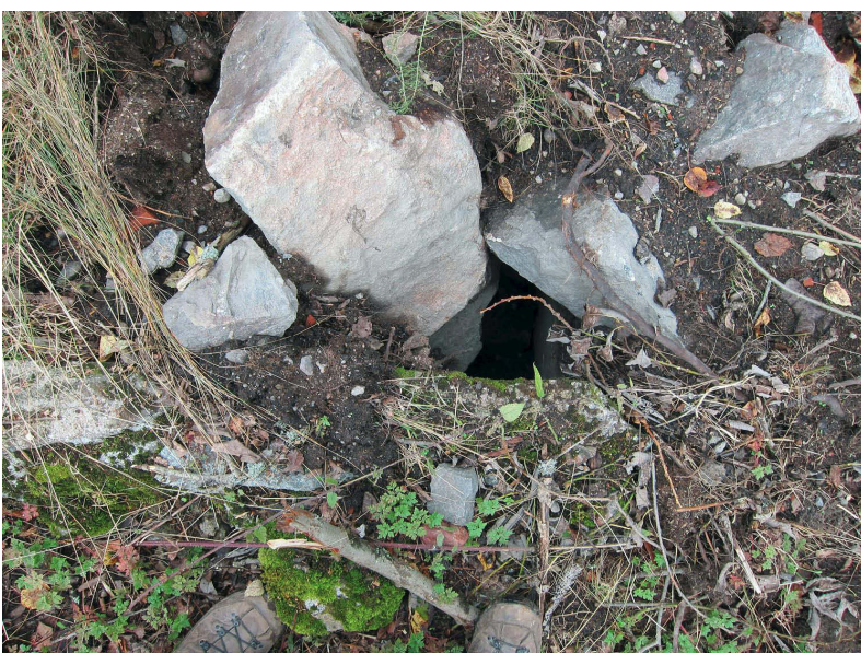
Kuva 20. Suojahuone oli täytetty louhintakivillä. Kuvassa on itäseinä kohtaa. Kuvaussuunta W. 4.10.2012.
