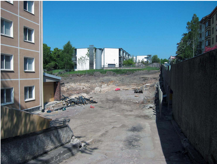
Kuva 1. Pohjoinen Hesperiantie 23 A:n rakennustyömaa on etualalla. Taustalla vihreän rinneosan reunassa on tarkastus- ja kartoitusalue puistoalueella Välskärinkatu 2 B:ssä. Kuvaussuunta NNW. 1.6.2011.
