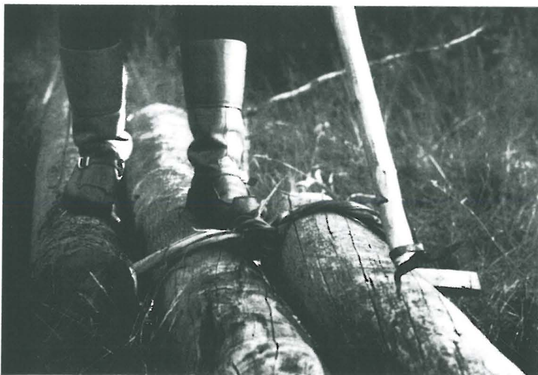
Tukit sidottiin kuusenkarhakoilla, jotka kiinnitettiin tukkeihin nalkkitapeilla.
