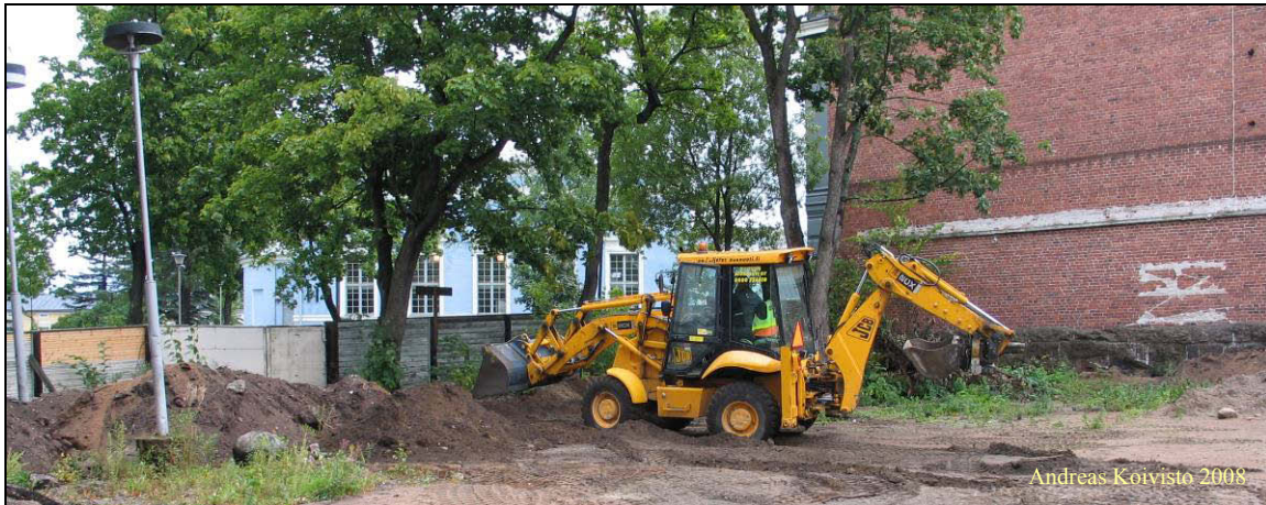
Kuva 4. Kaivauksissa käytettiin apuna konetta.
