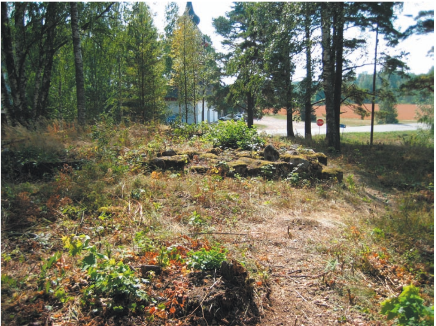
Kuva 2: rakenne 2 eli kellotapulinkin kivijalka. Kuvattu luoteesta.
