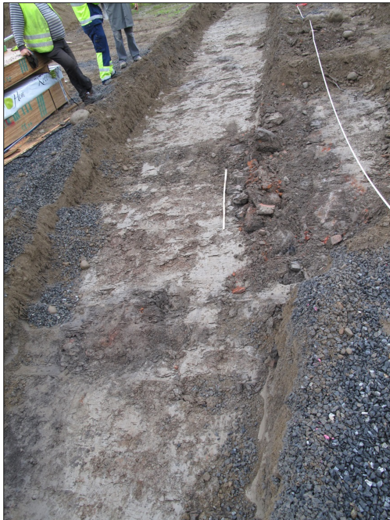
Rakenne 3. Kuvattu pohjoisesta.
