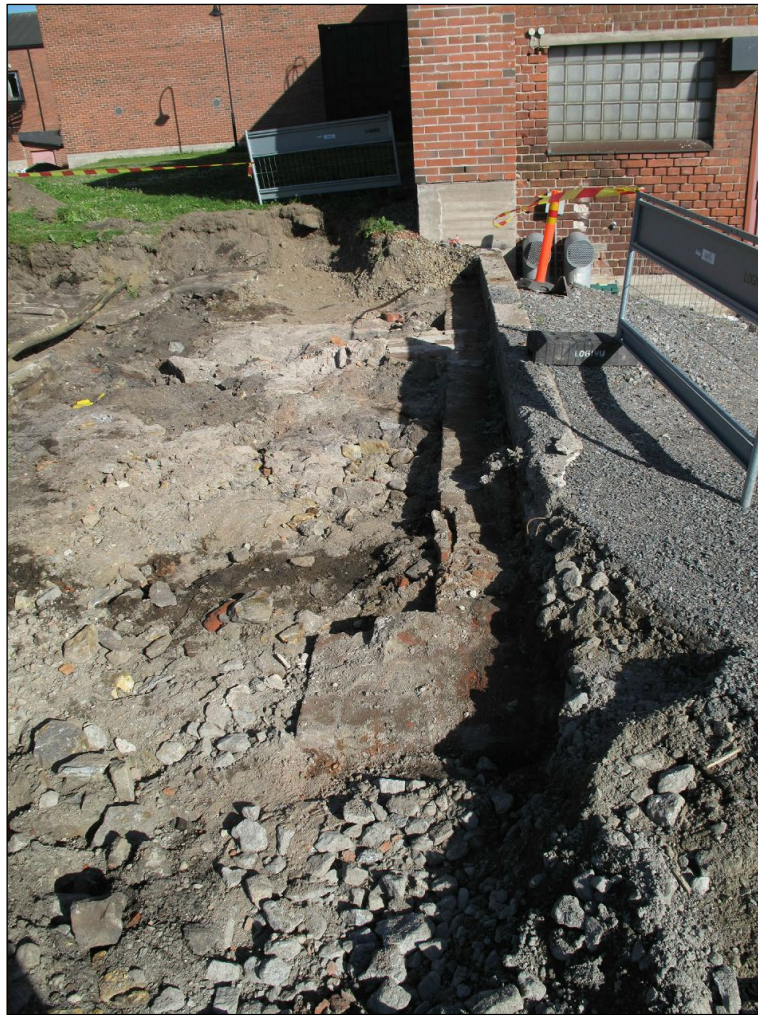
Rakenne R 161, etualalla M 163.
