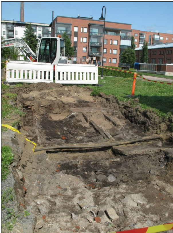
Kaukolämpöputken liittyviä rakenteita.
