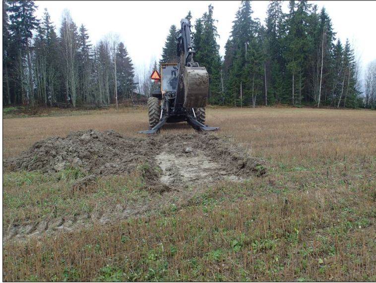
Koeajan kaivuuta. Kuvattu länteen.
