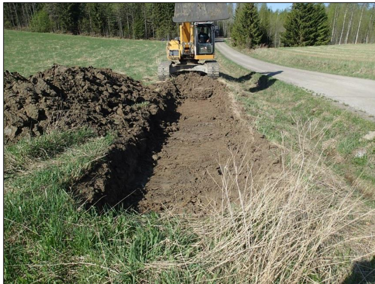
Kaivettua tasoa Hykkyrintien eteläpuolella.
