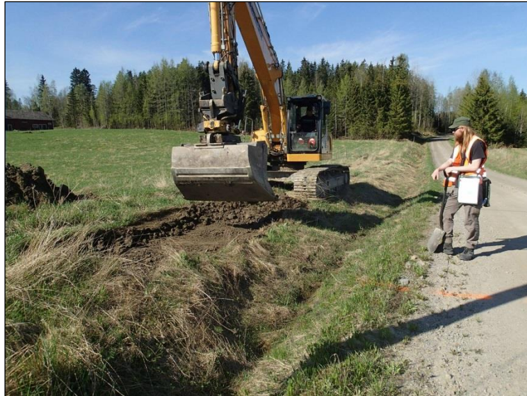
Jasse Tiilikkala valvoo kaivamista Hykkyrintien varressa.
