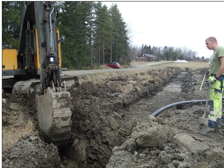
Linjaus nro 2. aletaan kaivaa valvottavan osuuden itäpäässä.
