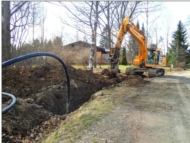
Ojaa kaivetaan arkeologisessa valvonnassa Kuutin kohdalla Tupurlantien 49 eteläpuolella.
