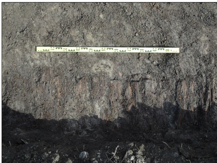
Puurakenne kuvattuna ylhäältä.
