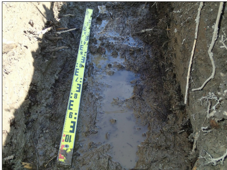
Maatunutta puujäännöstä latan kahden puolen kaivannon.
