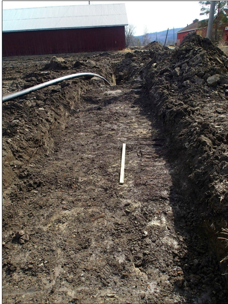
Puurakenne latan vieressä ja sijainti kaivannossa.
