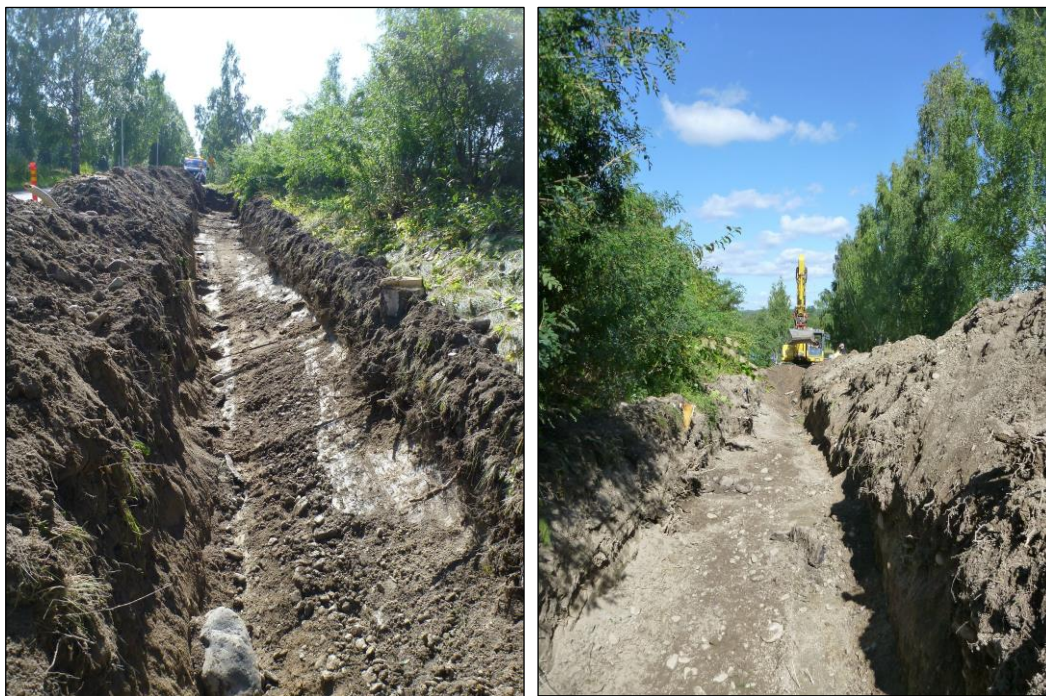
Valvonnassa kaivettu kaivanto
