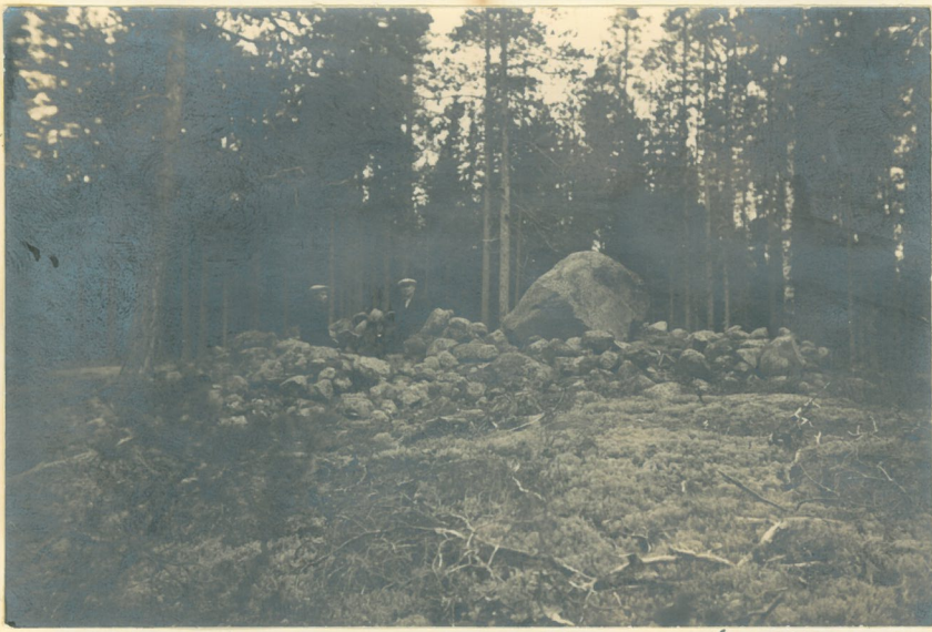
2. Sama raunio kuin yllä paikoisluo- steesta päin. Puutarhuri Ahto Lehtonen ja maanviljelijä Lauri Ylirtalo seisovat rau- nion kaivotussa kuopassa. Valok. 21. 9. 1930. lev. 7551.
