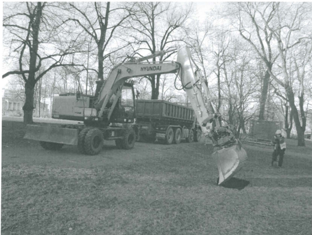
Kuva 1. DT2011_48_1. Pintamaan poistoa aloitetaan kaivannossa B. Kuvattu N-suunnasta. Kuvajaaj Sonja Hukantaival.
