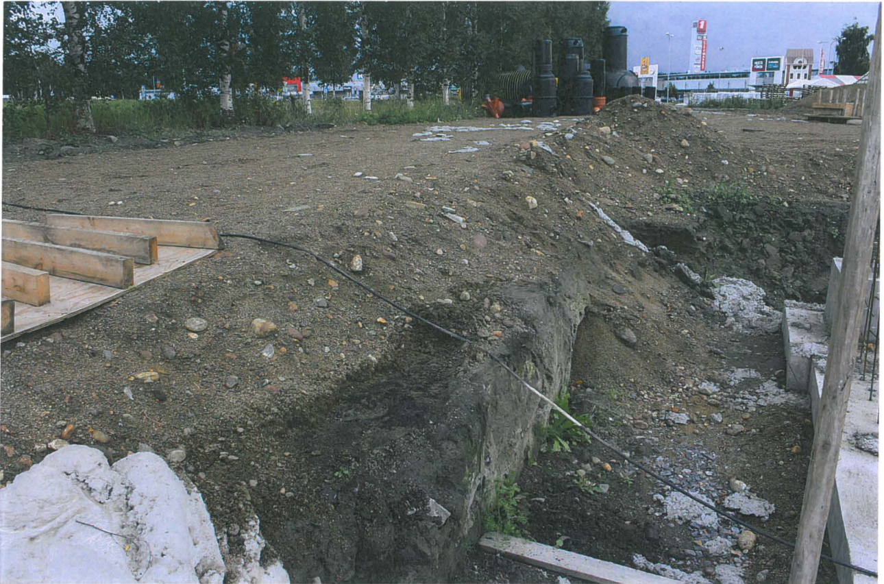
KYY 83 : 3 Nokimaata perustuskaivannon itäreunassa. Pohjoisesta. Vadim Adel 09.08.2011
