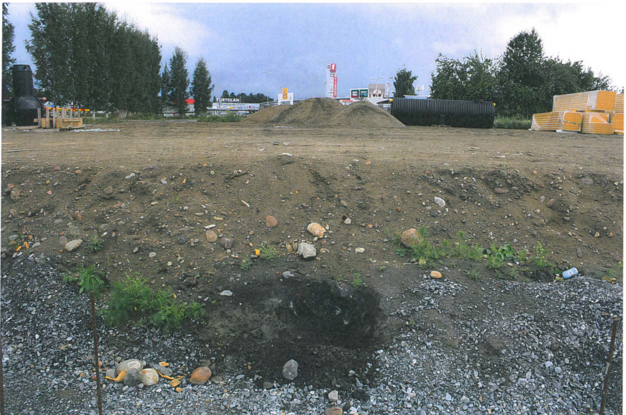
KYY 83 : 6 Tulisijan jäännös kaivannon S-profiilissa. N. Vadim Adel 09.08.2011
