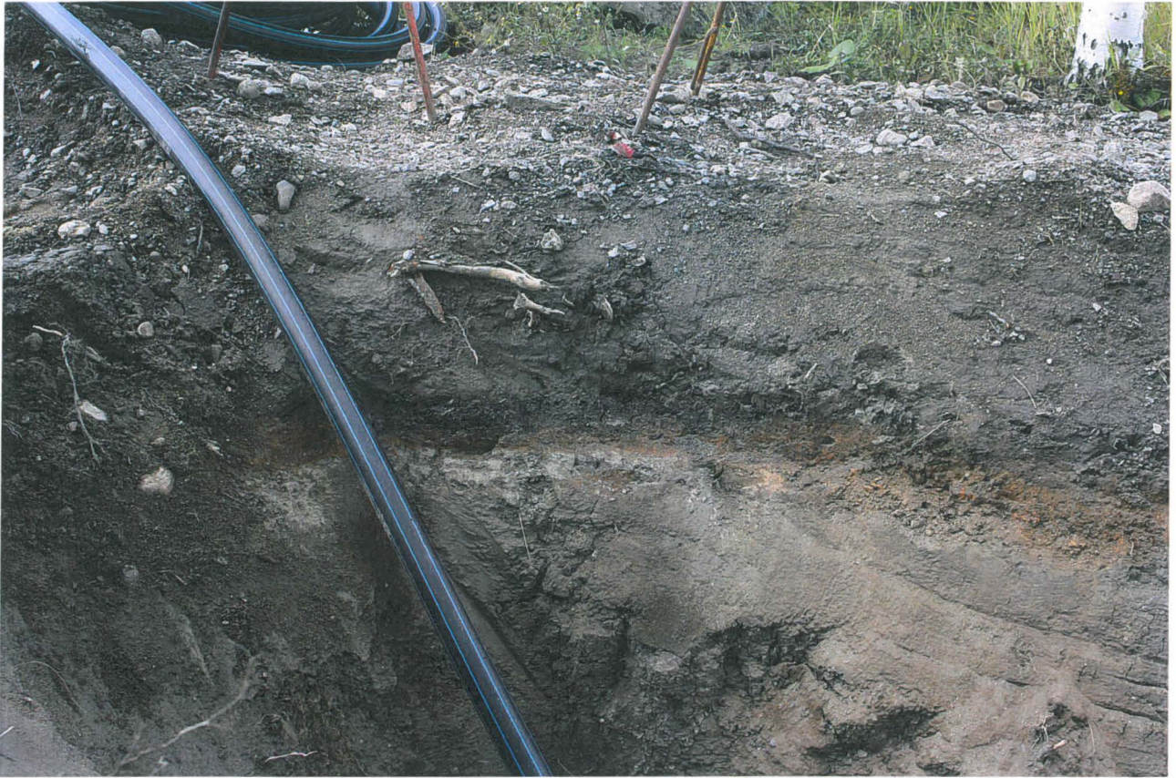
KYY 83 : 7 Noki- ja palomaakerros vesihuoltokaivannossa. Vadim Adel 09.08.2011
