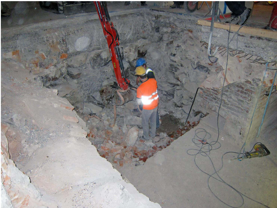
Kuva 14. Kellari 8. Edellinen tilanne. Kiveä nostetaan pois kuopasta. Tilasta oli aiemmassa korjauksessa poistettu tiiliholvikatto. Kuvaussuunta NE. 3.10.2011.
