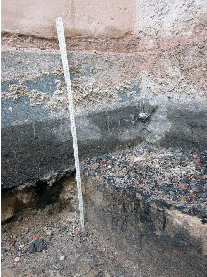
Kuva 140. Piha. Pihan luoteisosan kulman rakenteita. Kuvaussuunta NW. 3.1.2012.
