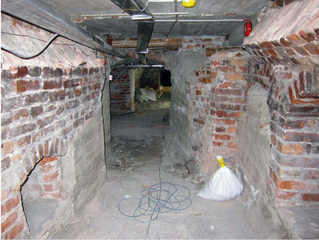
Kuva 33. Kellari 7. Täälläkin tiilinen kattoholvi vaihdettu betoniseen. Kuvaussuunta N. 3.10.2011.
