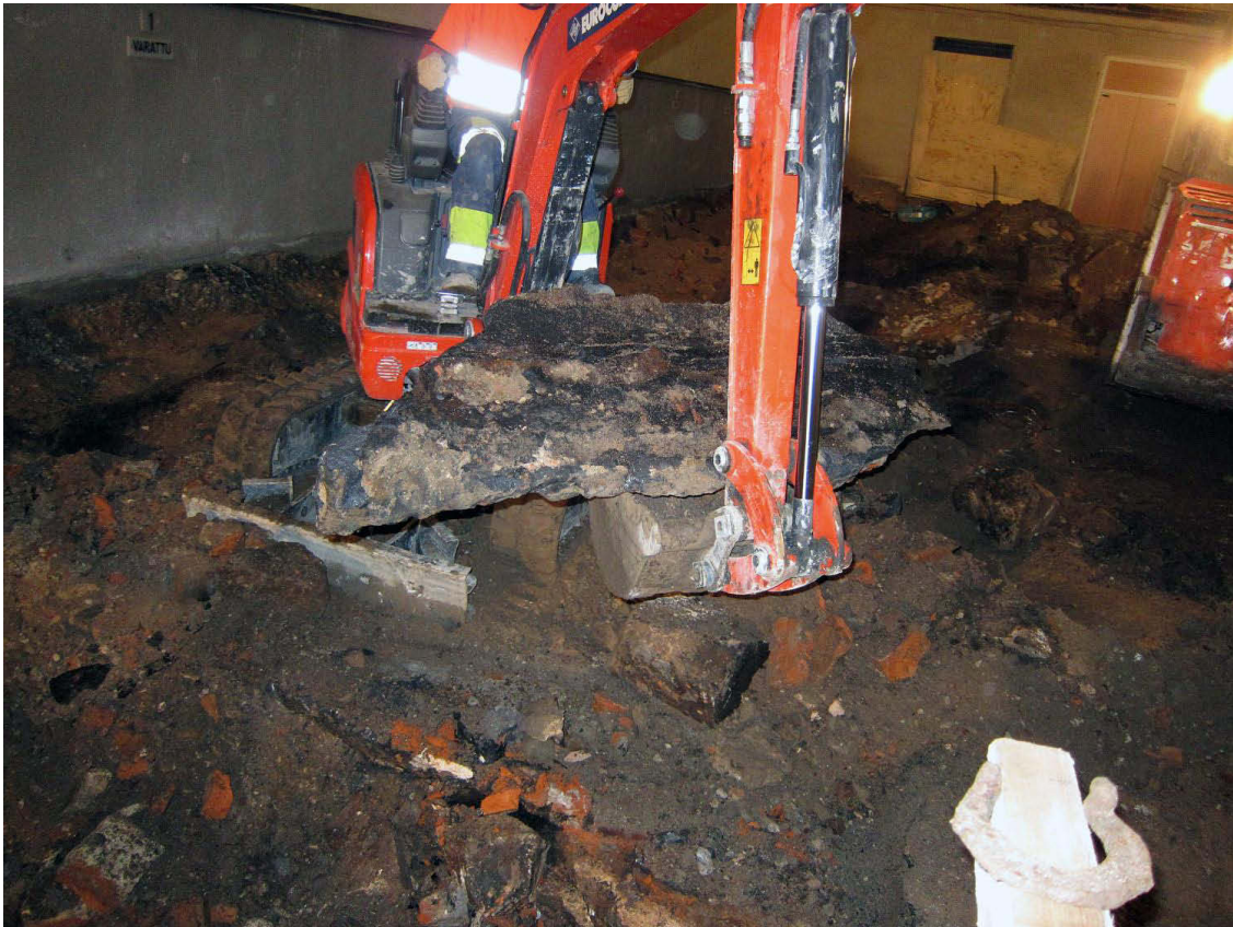
Kuva 85. Piha. Kreosottiseinästä irrotettua palaa nostetaan pois. Kuvaussuunta SE. 7.11.2011.
