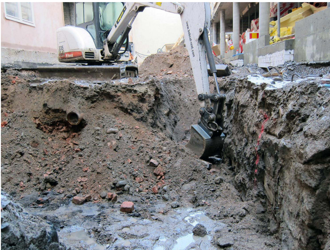
Kuva 133. Piha. Pihan lounaisosan kaivausalueen pohjoisseinän itäosa. Uusi piharakennus on neljä metriä leveä ja vanha piharakennus viisi metriä leveä. Ero näkyy kuvassa. Kuvaussuunta N. 3.1.2012.
