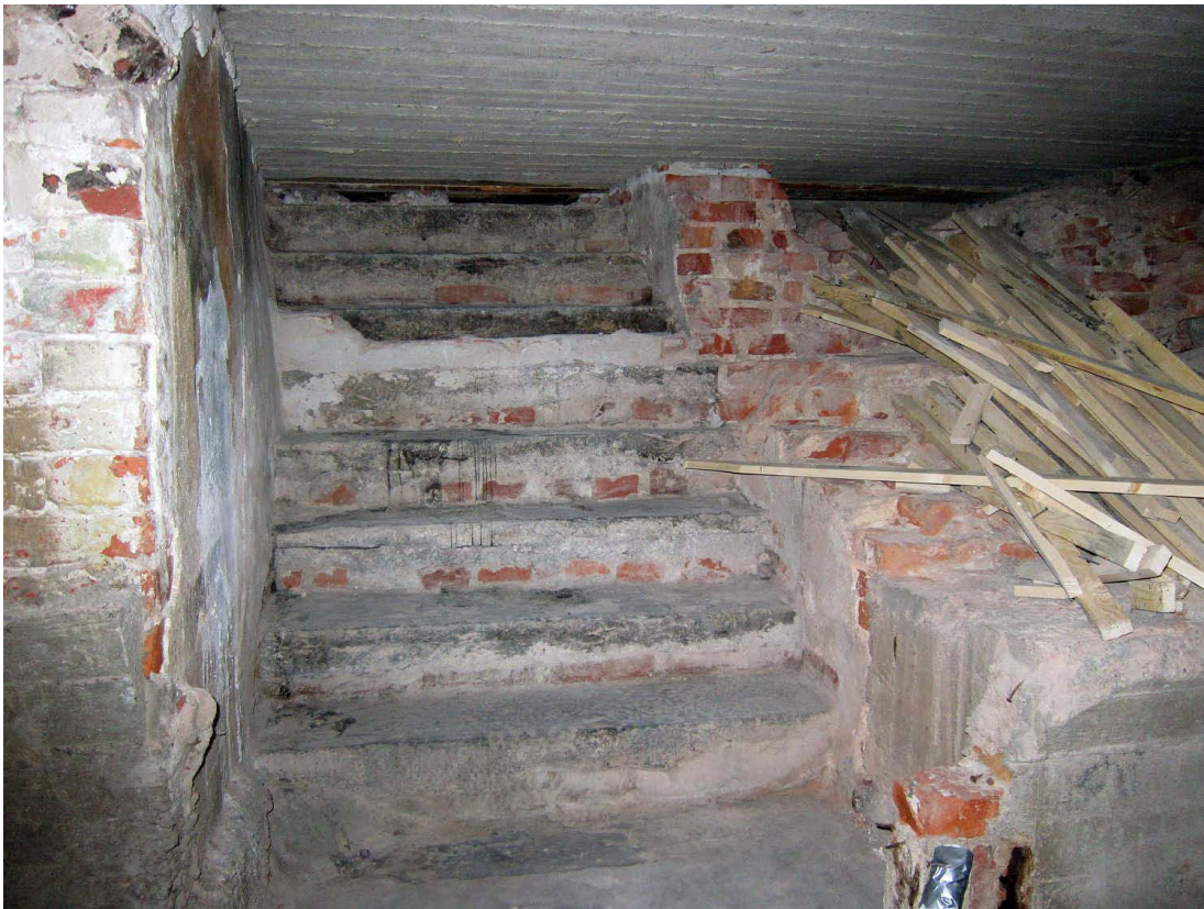
Kuva 20. Kellari 4. Portaat eivät johtaneet enää mihinkään. Tilan seinät ja katto olivat aiemman peruskorjauksen jäljiltä betonisia. Kuvaussuunta W. 3.10.2011.
