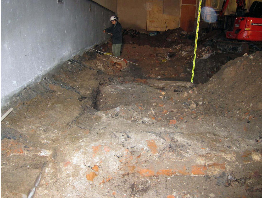
Kuva 79. Piha. Kreosoottitilan itäreunaan on kaivettu koekuoppa 1 (10-14 m). Kuvaussuunta S. 7.11.2011.
