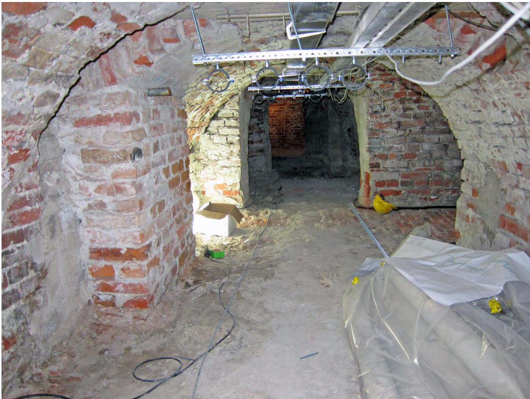
Kuva 36. Kellarit 11, 10 ja 7. Edessä on kellari 11, kypärän takana olevan seinän takana on kellari 10:n itäosa ja taaempana kellarikäytävä 7. Kuvaussuunta S. 3.10.2011.
