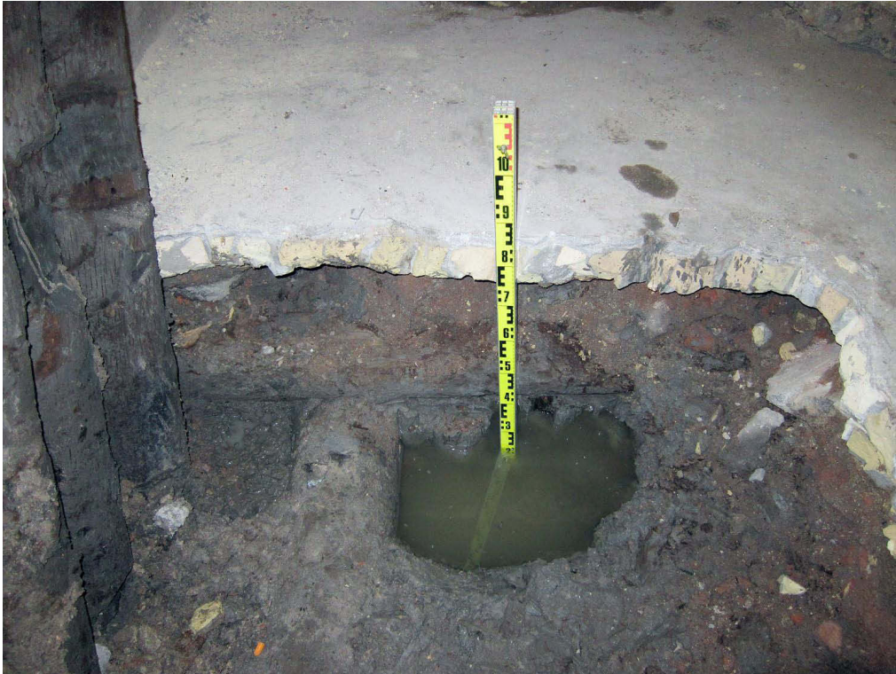
Kuva 6. Kellari 2. Kuvassa uuden hissikuilun perustuskuopan länsiosaa, jossa betonilla pintavaletun ja keltaisia tiiliä käsittävän lattian alla näkyy maakerroksen jälkeen poikittainen hirsi ja sen alla pitkittäinen hirsi. Latan takana pohjavedessä on pystypaalujen päitä. Kuvaussuunta W. 3.10.2011.
