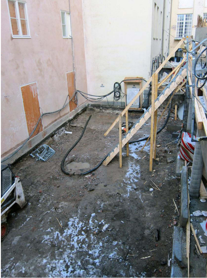
Kuva 134. Piha. Pihan luoteisosaa. Kuvaussuunta NW. 3.1.2012.
