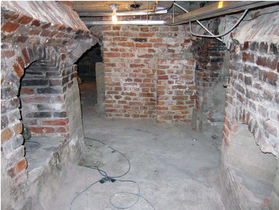
Kuva 34. Kellari 7. Kellarikäytävien 3 ja 7 risteys. Taustalla näkyy kellari 6 ja oikealla on oviaukko kellariin 8. Kuvaussuunta S. 3.10.2011.
