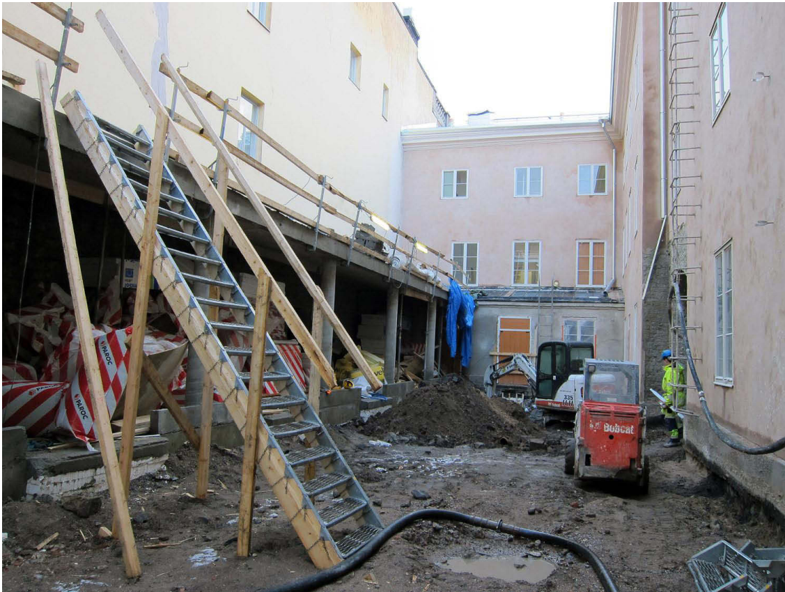
Kuva 148. Piha. Piharakennus rakennusvaiheessa. Kuvaussuunta S. 3.1.2012.
