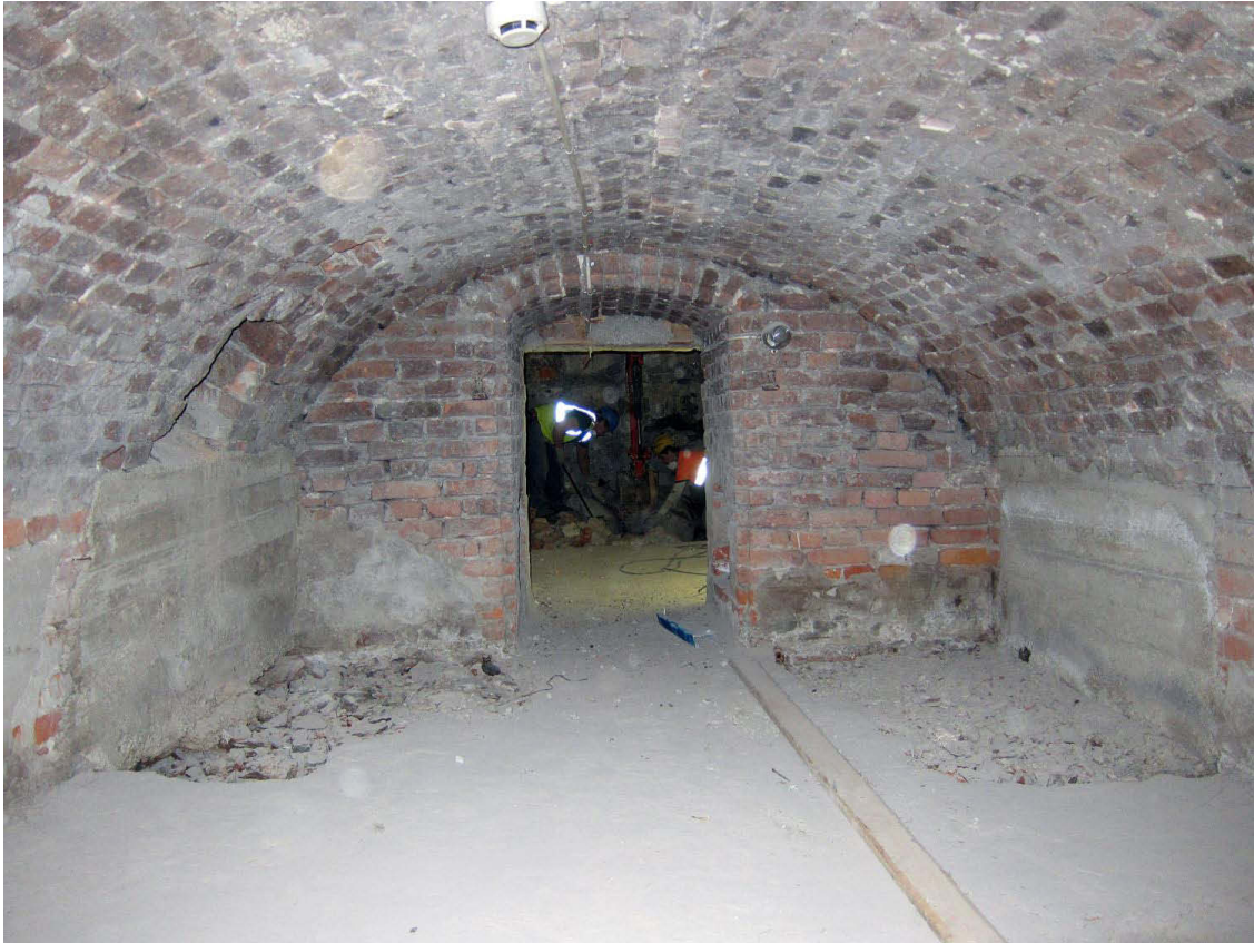
Kuva 32. Kellari 9. Taustalla on kellari 8, jossa kaivetaan hissikulun paikkaa. Kuvaussuunta N. 3.10.2011.
