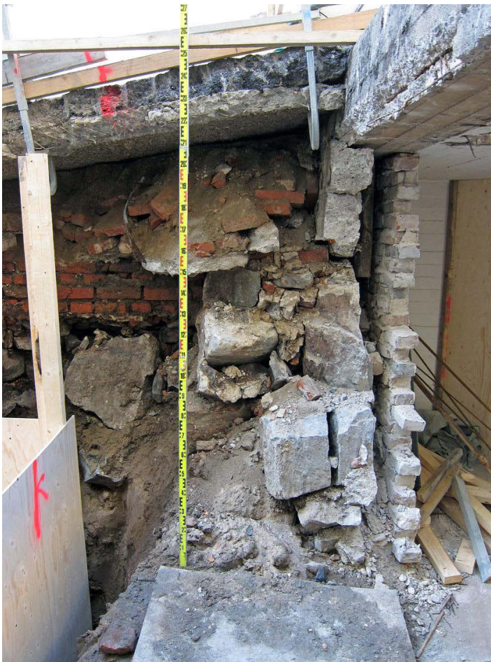
Kuva 56. Piha. Purettun kiviseinän kohta. Kuvan yläosassa on viisto luiska pohjoispuoliselta tontilta Goviniuksen pihalle. Se on purettu hissikuilun kohdalta kuvan etualalta. Purettun muurin eteläpuolella luiskan alla näkyy N-S – suuntainen kivimuri ja sen päällä tiilimuri, jotka kuuluvat pihan itäreunalla vuosina 1819-1959/62 sijainneeseen piharakennukseen ( Havaintopiste 2 ). Kuvaussuunta W. 4.11.2011.
