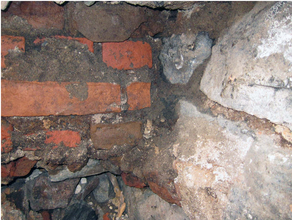
Kuva 58. Piha. Tiilimuurin ja pohjoisen kivimuurin yhtymäkohta. Kuvaussuunta WNW. 4.11.2011.
