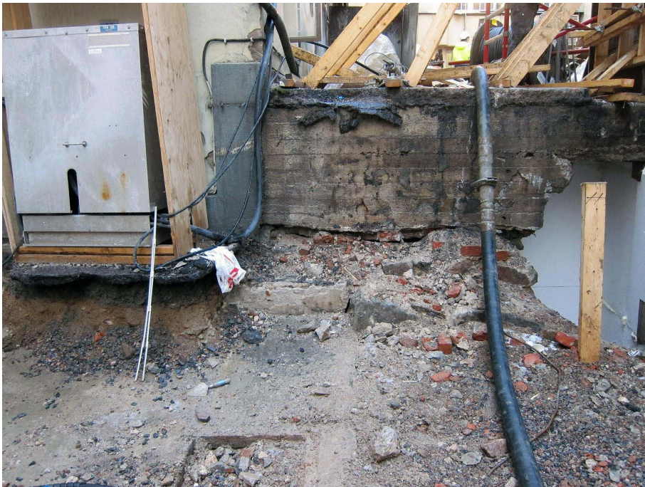
Kuva 143. Piha. Pihan luoteisosan pohjoisseinän rakenteita. Kuvaussuunta N. 3.1.2012.
