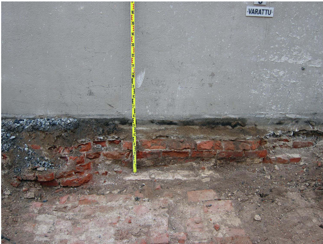
Kuva 101. Piha. Lähikuva itäseinästä tiililattian kohdalla (17-20 m). Kuvaussuunta E. 4.11.2011.
