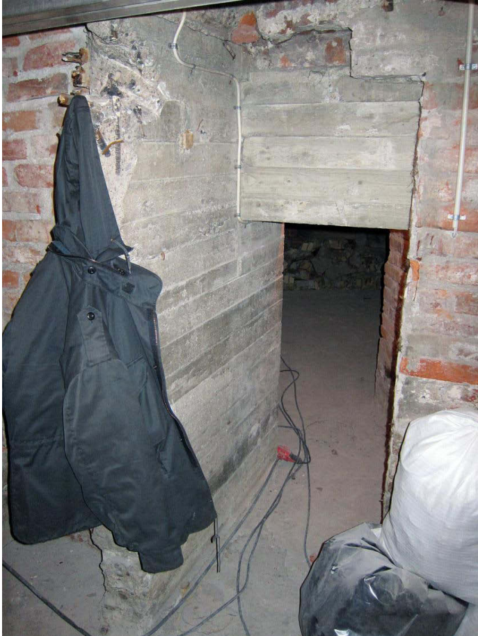
Kuva 21. Kellarit 3 ja 5. Edessä on kellarikäytävää 3 ja taustalla kellari 5. Kuvaussuunta S. 3.10.2011.
