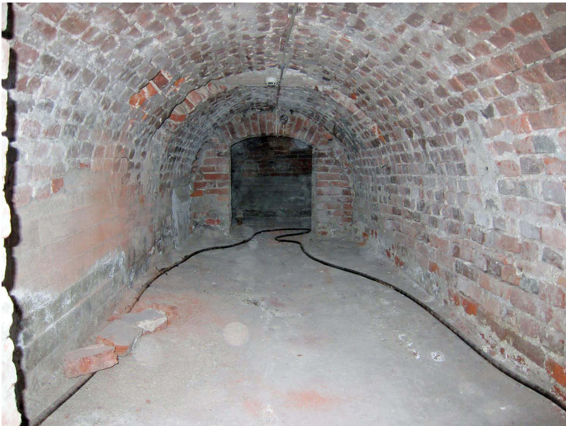
Kuva 40. Kellari 13. Taustalla on kellari 14. Kuvaussuunta N. 3.10.2011.
