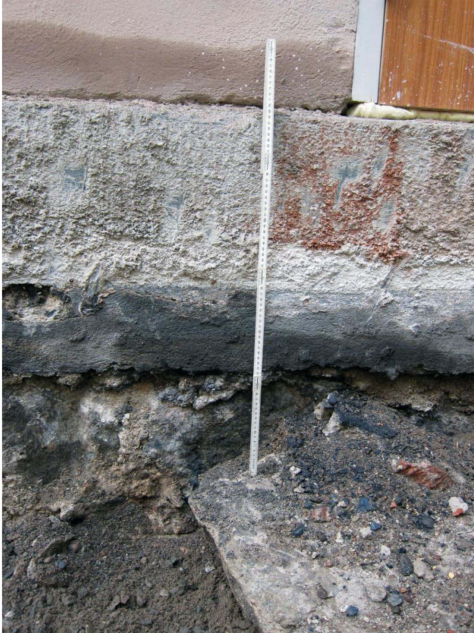
Kuva 138. Piha. Pihan luoteisosassa. Kivijalan ja betonitason vieressä oleva kohta. Kuvaussuunta WNW. 3.1.2012.
