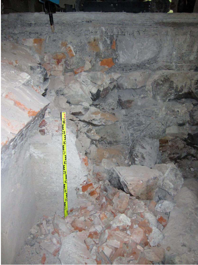
Kuva 13. Kellari 8. Toinen hissikuilu tehtiin kellarin 8 pohjoisosaan (dokumentointikohta 2). Suurin osa siitä sijaitsee purettavan vanhan paksun kiviseinän kohdalla. Latan takana on kellarin jäljellä tiilistä pohjoisseinää. Sen oikealta puolelta on piikattu tiiliseinä kokonaan pois ja osa kiviperustusmuuria. Kuvaussuunta N. 3.10.2011.
