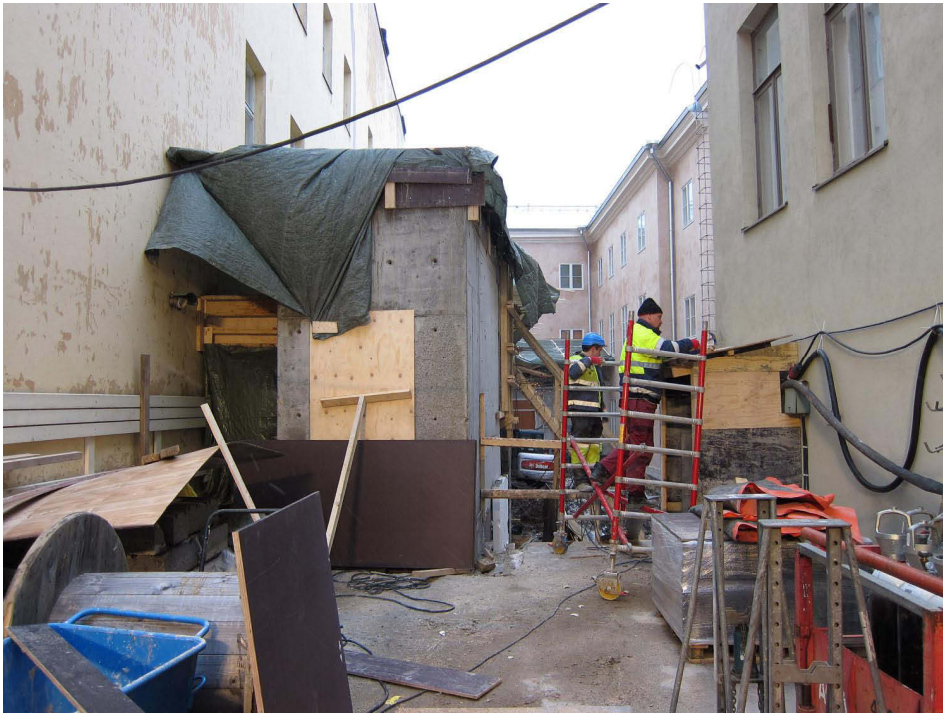
Kuva 146. Piha. Pihan pohjoisosan hissikuilu rakennusvaiheessa. Kuvaussuunta S. 13.1.2012.
