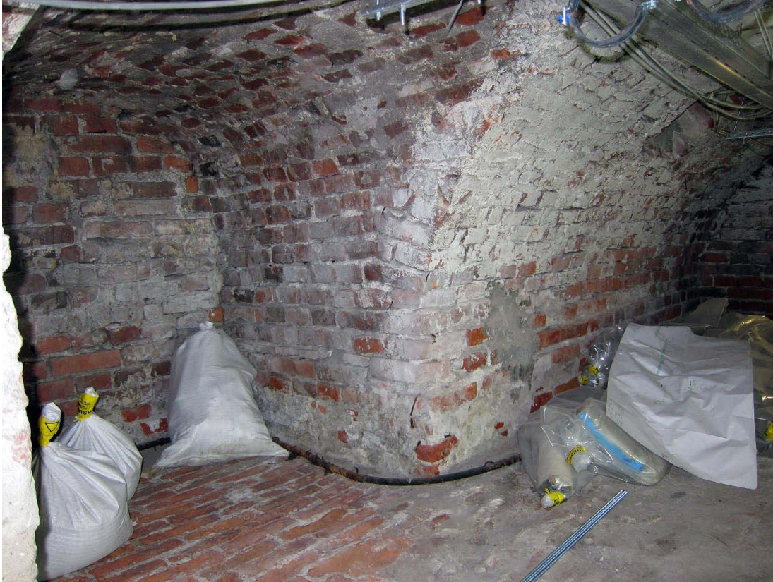
Kuva 37. Kellari 11. Kellarin länsiseinän puolella oli syvennys vasemmalla olevien pussien kohdalla, jossa oli tiililattiaa jäljellä. Kuvaussuunta NW. 3.10.2011.
