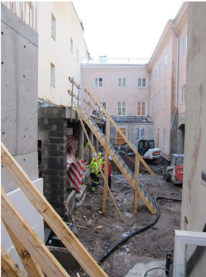
Kuva 147. Piha. Piharakennus rakennusvaiheessa. Kuvaussuunta S. 3.1.2012.
