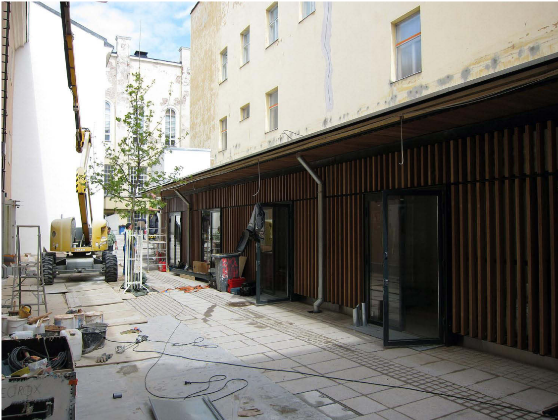
Kuva 150. Piha. Piharakennus rakennusvaiheen loppuvaiheessa. Kuvaussuunta NE. 22.5.2012.
