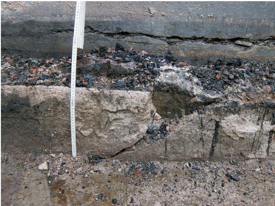
Kuva 141. Piha. Pihan luoteisosan pohjoisseinän rakenteita. Kuvaussuunta N. 3.1.2012.
