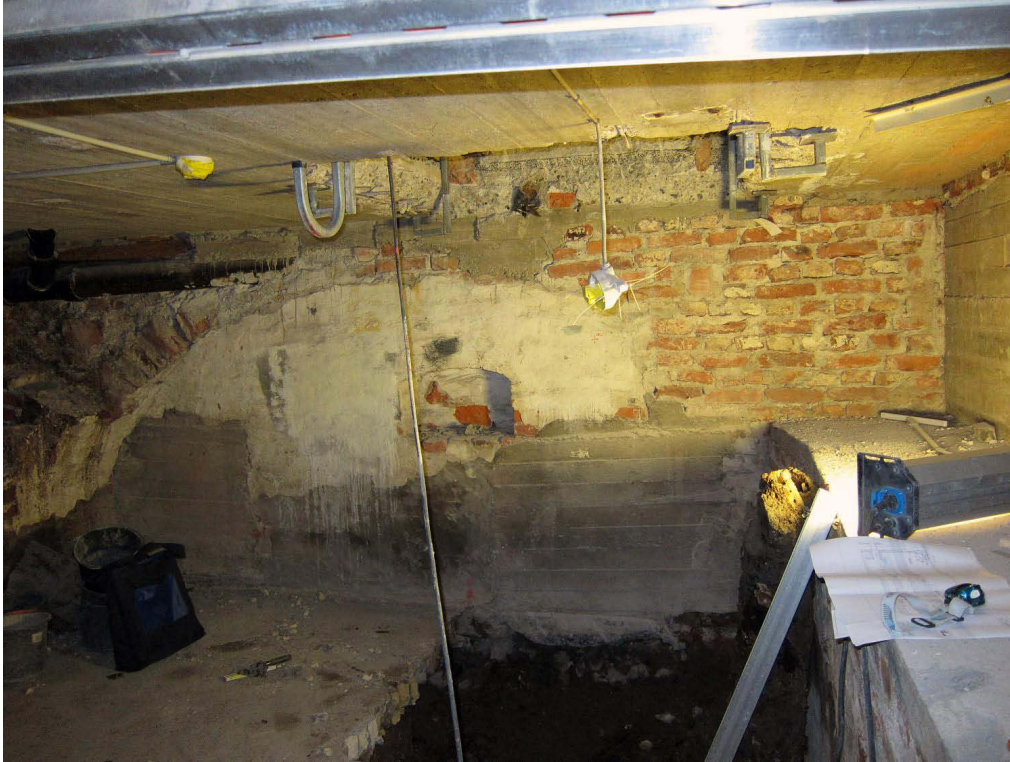
Kuva 5. Kellari 2. Kellari 2:n itäseinä. Rakennus on megapaalutettu 1960-luvulla. Sen jäljet näkyvät Goviniuksen kaikkien kellariseinien alaosassa. Osan kellareiden, kuten kellari 2:n, kattoholvit oli purettu ja tilalle laitettu tasaiset betonikatot. Kuvaussuunta E. 3.10.2011.
