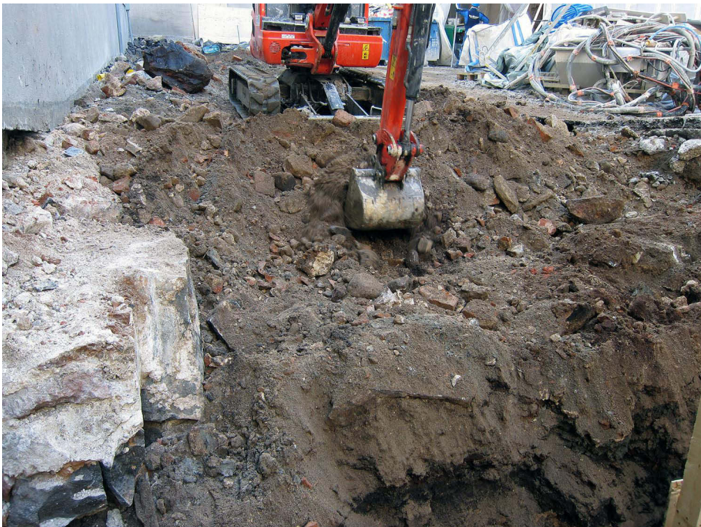
Kuva 64. Piha. Pihan itäreunalle rakennettiin yksikerroksinen rakennus, jonka perustusten takia maata poistettiin 50-60 cm koko pihan itäreunan pituudelta (0-28 m). Kerros oli hiekkaa ja rakennusjätettä. Kuvassa sen alla ennen savea oleva tummempi maa liittyy sen takana olevaan piharakennuksen perustusmuuriin vuodelta 1819. Kuvaussuunta S. 4.11.2011.
