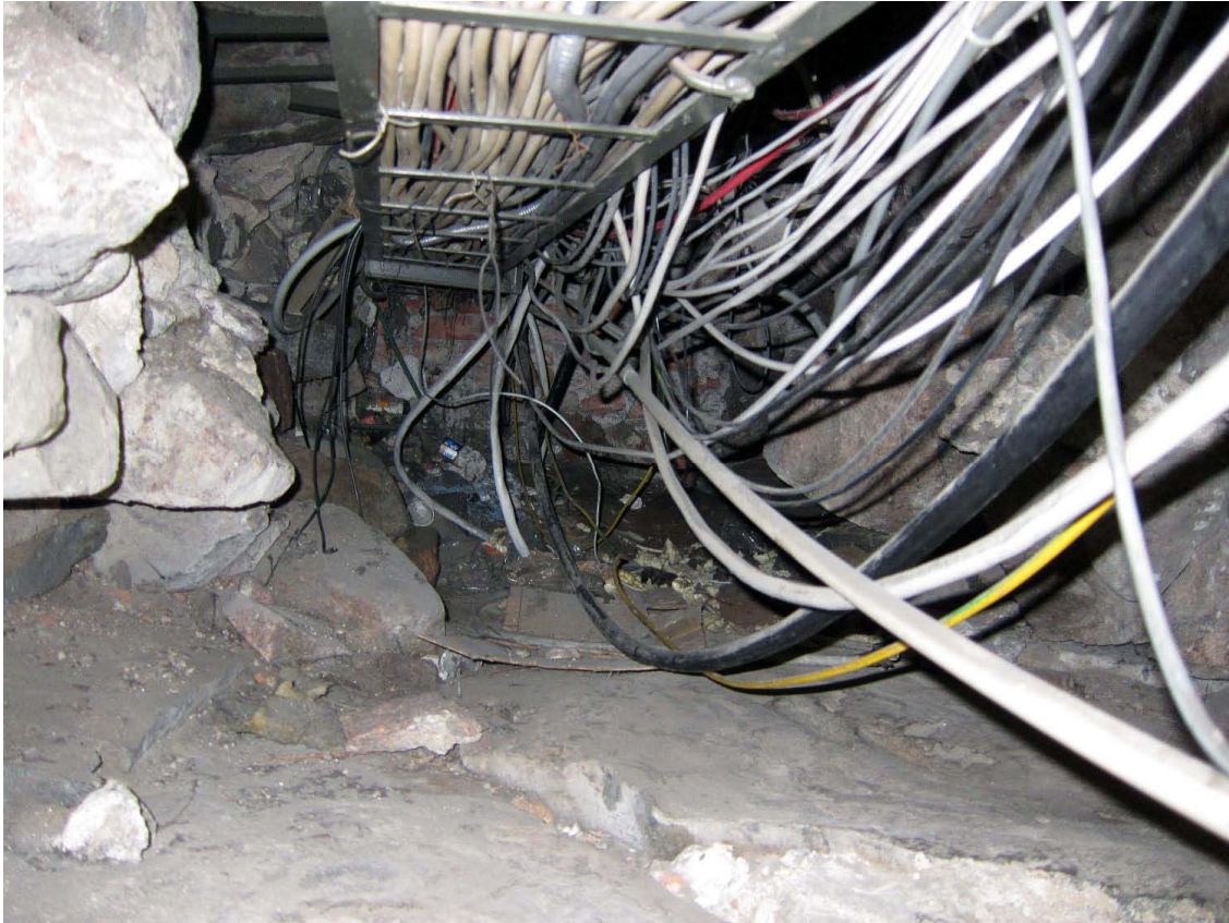
Kuva 54. Kaapelitunneli. Kellarin 17 koilliskulmasta lähtevä kaapelitunneli. Kuvaussuunta N. 3.10.2011.
