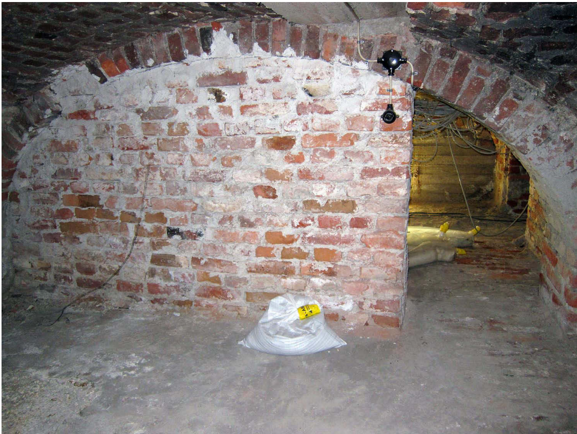
Kuva 44. Kellari 14. Kellarin itäseinä, joka on tehty vasta myöhemmin. Taustalla on kellari 12. Kuvaussuunta E. 3.10.2011.
