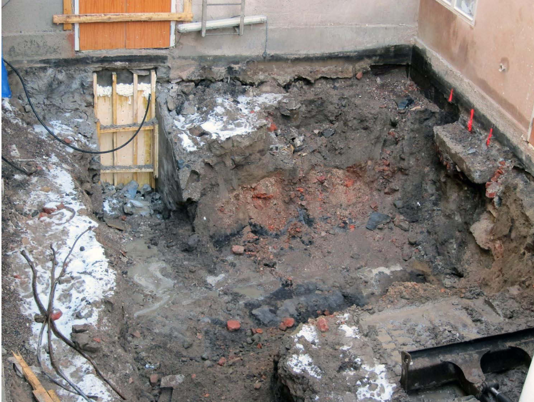
Kuva 121. Piha. Lähikuva pihan lounaisosan kaivausalueesta. Vanha suljettava kellarioviaukko sijaitsee alhaalla kaivannossa. Sen edessä on sijainnut betoninen kellariportaikko. Sen oikealla puolella ylemmässä maakerroksessa oli viemäriputkeen liittyvä tiilirakenne. Kuvaussuunta SSW. 3.1.2012.
