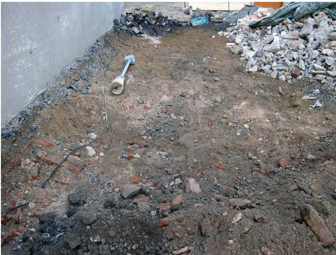
Kuva 108. Piha. Pihan kaakkoisosa edellisen rakenteen eteläpuolella (19-28 m). Kuvaussuunta S. 4.11.2011.
