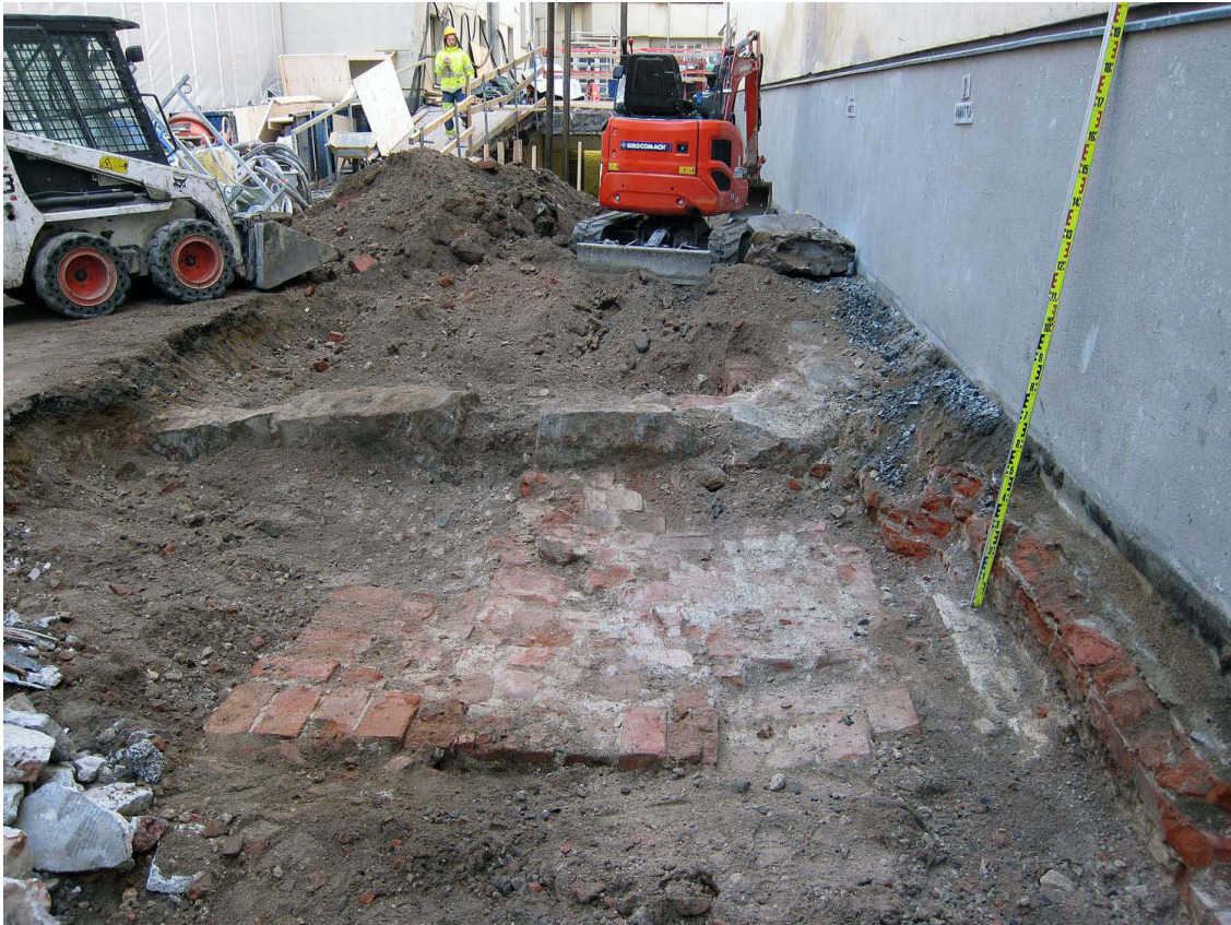
Kuva 98. Piha. Lähikuva edellisestä rakenteesta. Kuvaussuunta N. 4.11.2011.
