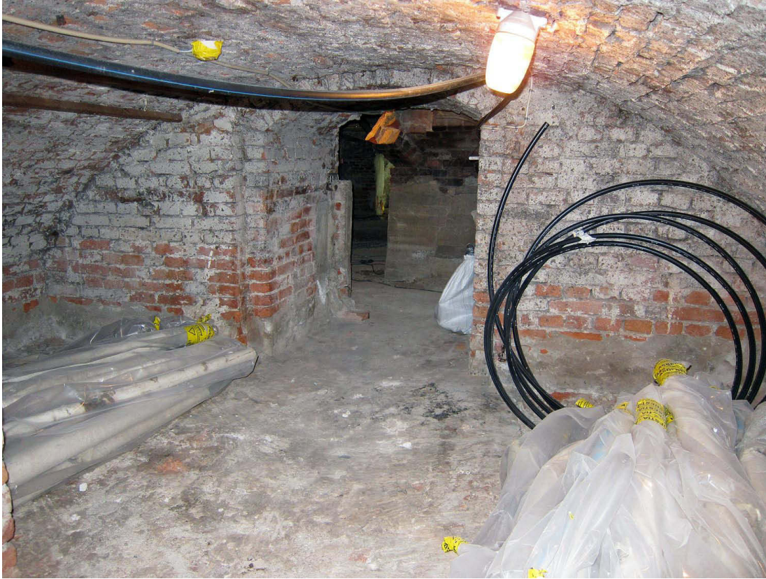
Kuva 29. Kellari 6. Taustalla ovat kellarikäytävien 3 ja 7 risteys. Kuvaussuunta NNW. 3.10.2011.
