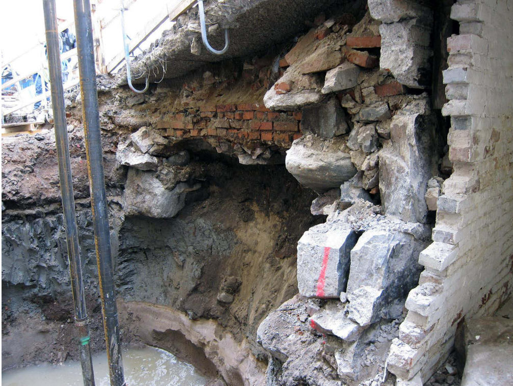
Kuva 63. Piha. Luiskan alla näkyy entisen piharakennuksen kivi- ja tiilimuurin alla luonnolliset savi- ja hiekkakerrokset ( havaintopiste 2 ). Keltainen hiekka on valunut saveen päälle lähempänä kameraa. Kuvaussuunta SSW. 8.11.2011.
