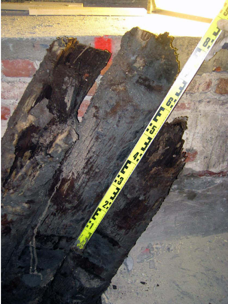
Kuva 11. Kellari 2. Kuopasta ylösnostettuja ylimmän hirsikerroksen hirsiiä. Kuvassa näkyy salvoksia. 3.10.2011.
