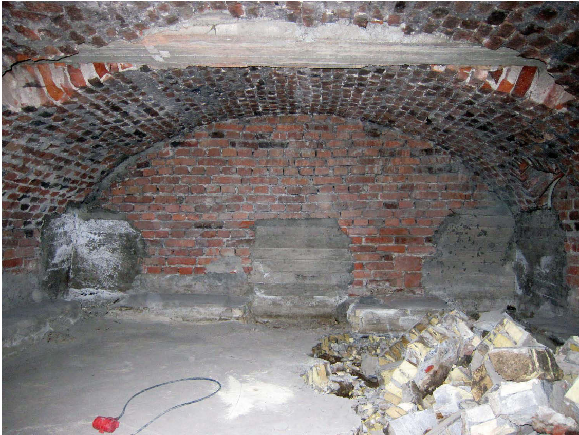
Kuva 24. Kellari 5. Kuvaussuunta E. 3.10.2011.
