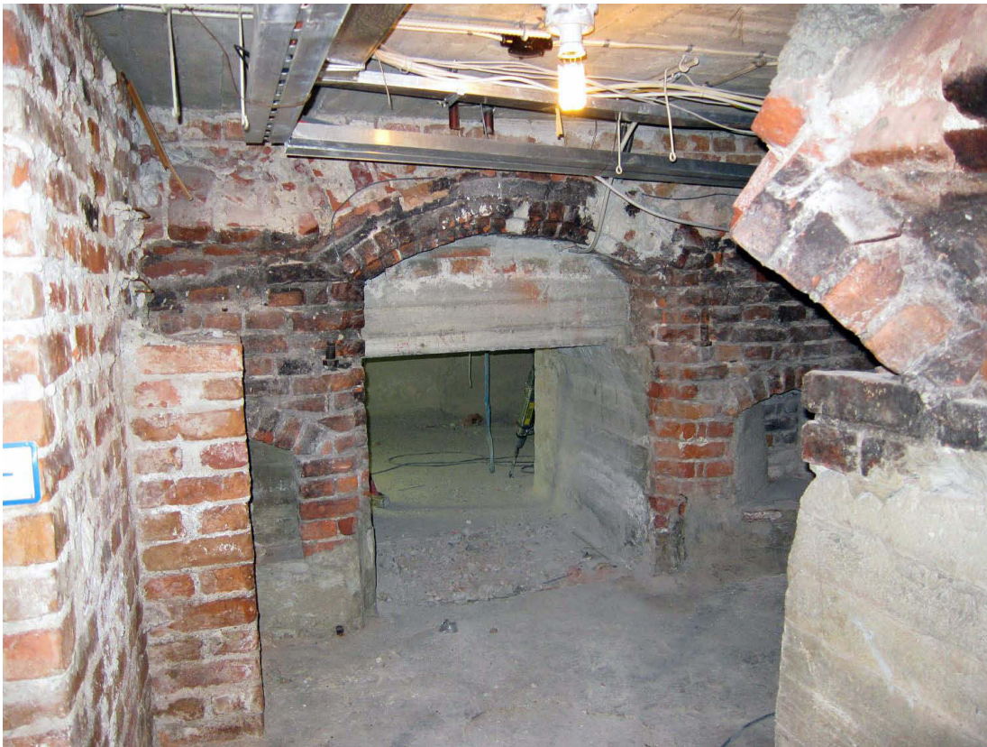
Kuva 30. Kellarit 3, 7 ja 8. Kellarikäytävien 3 ja 7 risteys. Taustalla on kellari 8. Kuvaussuunta WNW. 3.10.2011.
