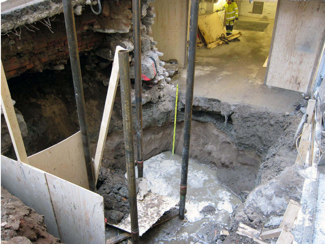
Kuva 61. Piha. Hissikulun kohta (0-5 m). Pohjoispuolisen tontin kellarin lattian alla näkyy melko pian koskematon savea ja hiekkaa ( Havaintopiste 1 ). Kuvaussuunta NNW. 7.11.2011.
