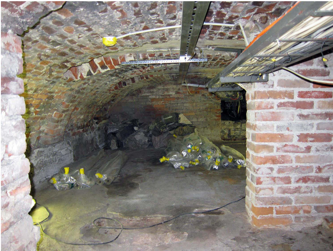
Kuva 50. Kellari 17. Kellarin länsipuolisko. Kuvan oikeassa reunassa sijaitsee tiiliportaati. Kuvaussuunta NNW. 3.10.2011.
