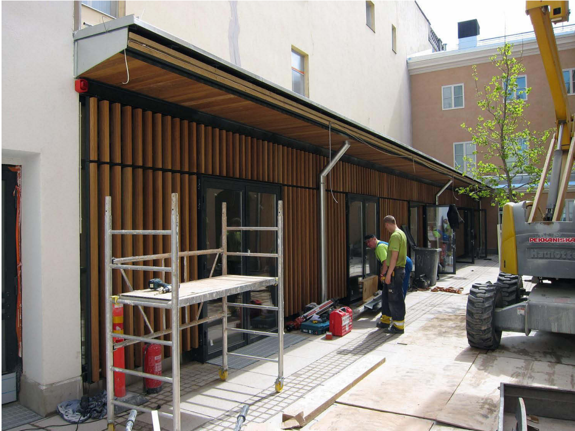
Kuva 149. Piha. Piharakennus rakennusvaiheen loppuvaiheessa. Kuvaussuunta SE. 22.5.2012.
