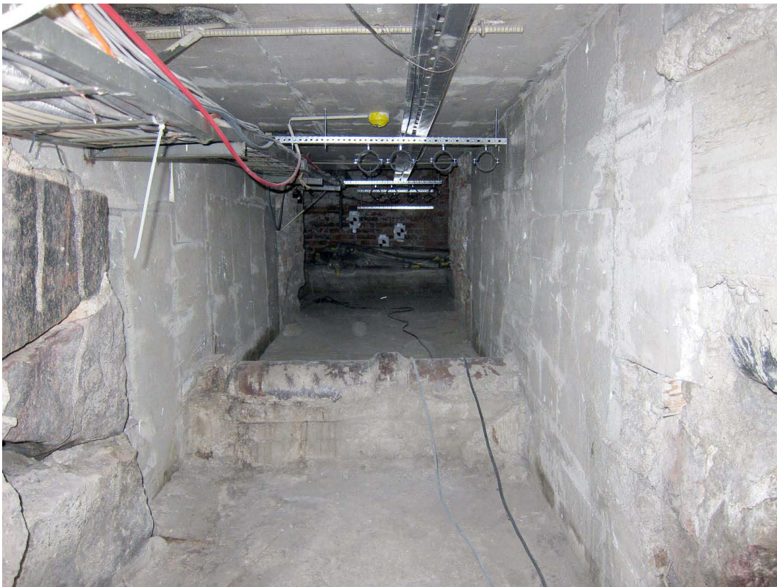
Kuva 46. Kellari 15. Taustalla on kellari 16. Kuvaussuunta N. 3.10.2011.
