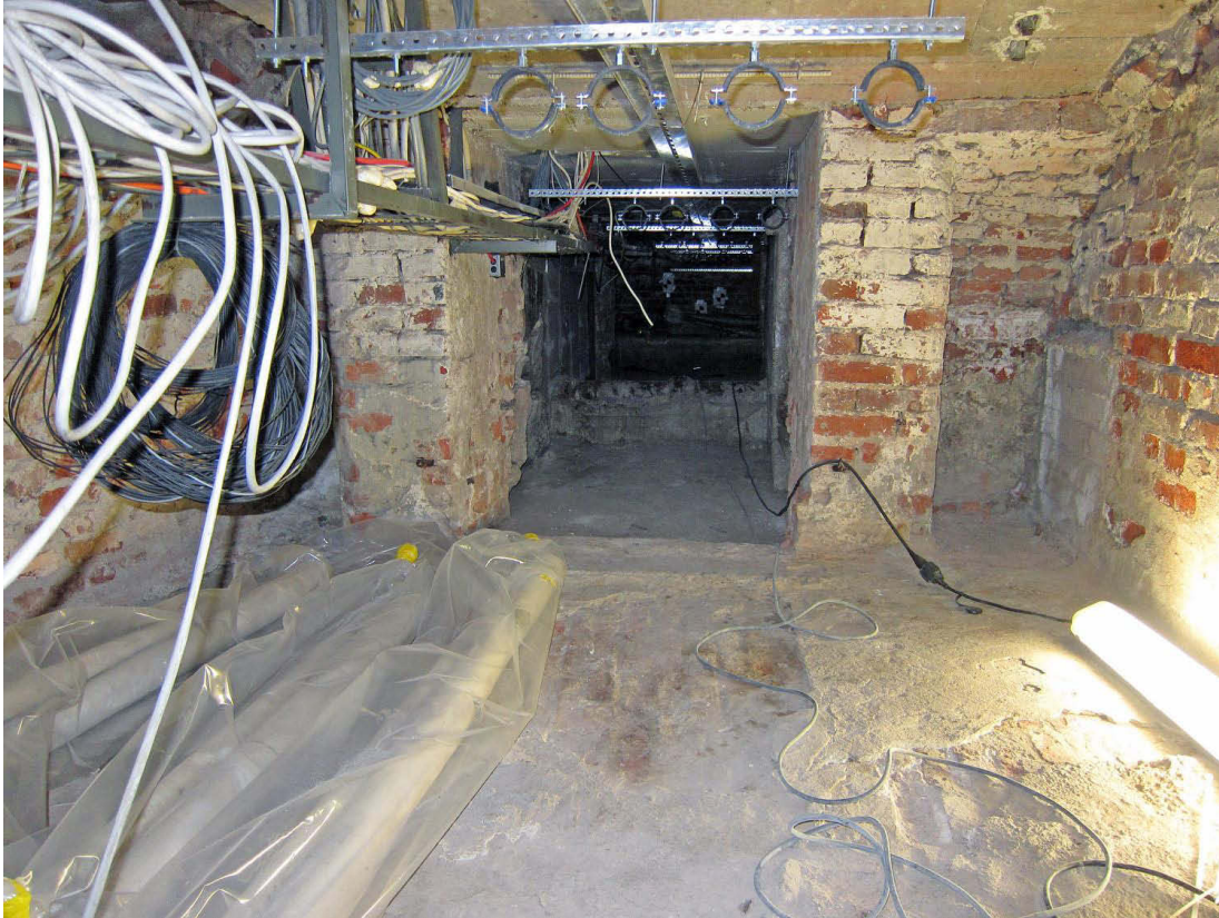
Kuva 45. Kellarit 12 ja 15. Edessä on kellari 12, jossa tiilinen kattoholvi on vaihdettu betoniseen. Takana on vasta 1960-luvulla tehty kellarikäytävä 15 porttikongin toisella puolella olleisiin kellaritiloihin. Kuvaussuunta N. 3.10.2011.
