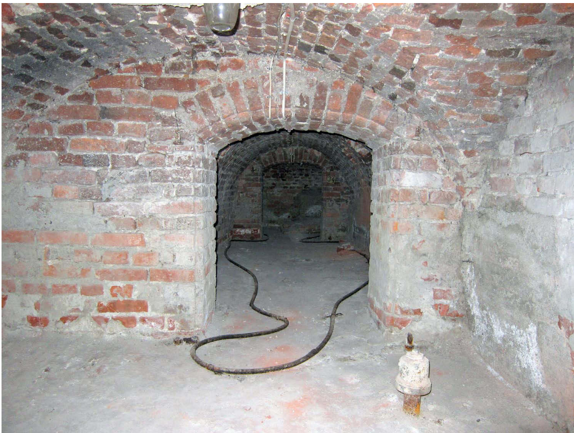
Kuva 42. Kellarit 14 ja 13. Edessä on kellari 14 ja seinän takana kellari 13. Taustalla näkyy kellari 10. Kuvaussuunta S. 3.10.2011.
