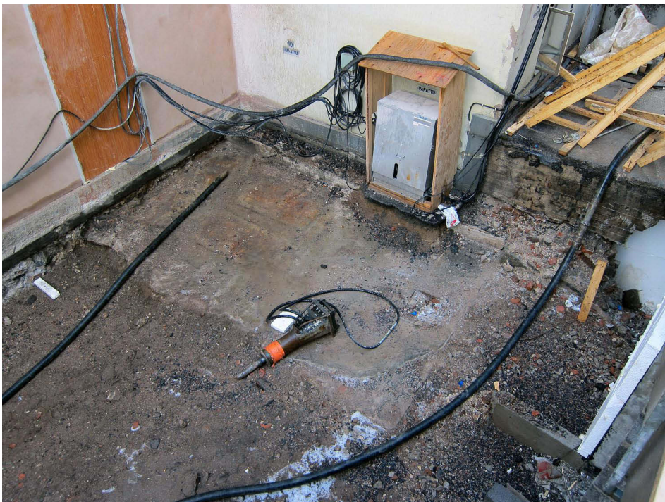
Kuva 135. Piha. Lähikuva pihan pohjoisosan piharakennuksen kattilahuoneen betonilattiasta. Rakennus on purettu vuonna 1959-62. Kattiloiden paikat näkyvät ruskeina läikkinä betonissa. Kuvaussuunta NW. 3.1.2012.
