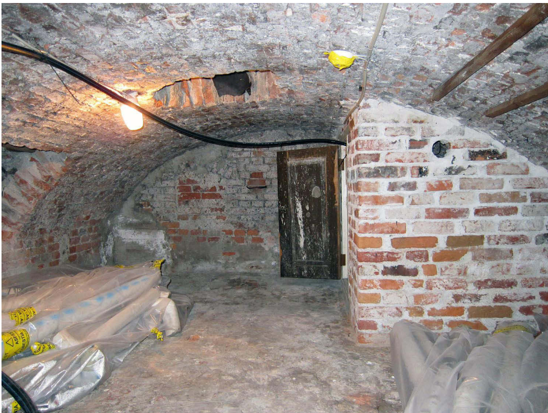
Kuva 28. Kellari 6. Kuvaussuunta S. Tilassa oli erillinen tila lounaisnurkassa. 3.10.2011.
